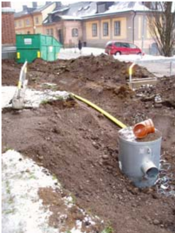
Figur 14. Schakt för eldragning till radonbrunnen. Foto Ivonne Dutra Leivas, Upplandsmuseet.
