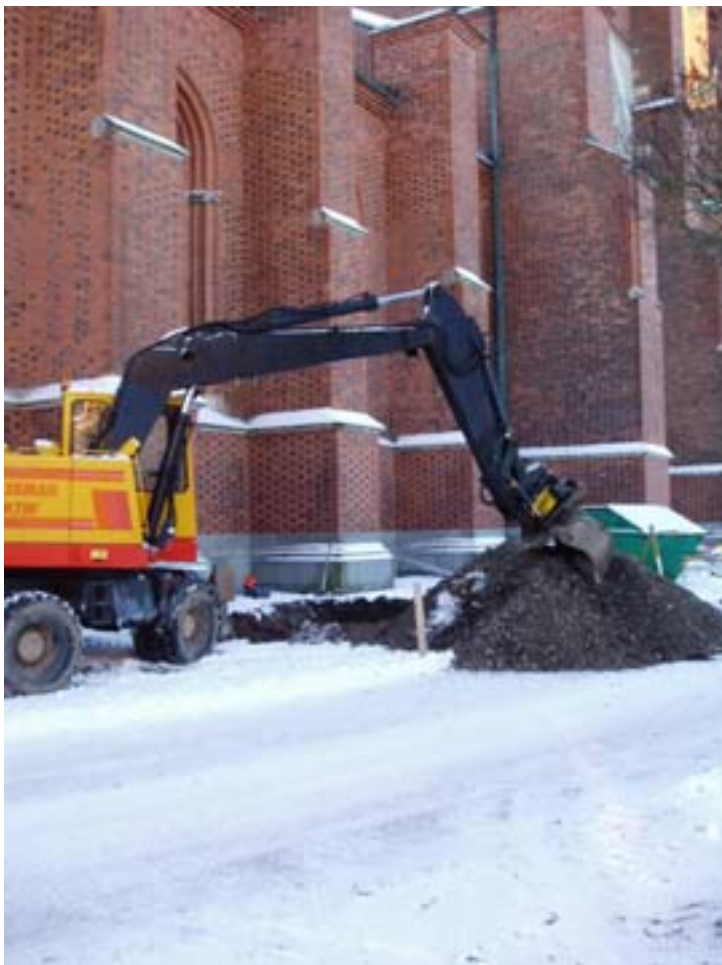
Figur 2. Schaktning för radonbrunn på domkyrkans södra sida. Foto Bent Syse, Upplandsmuseet.
