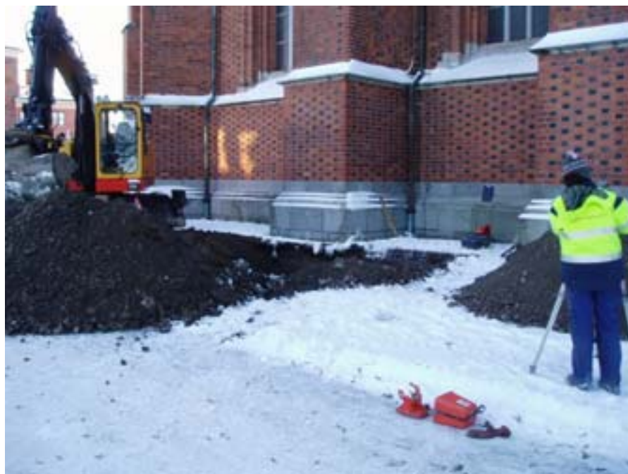
Figur 7. Schaktning för radonbrunn på norra sidan om kyrkan. Foto Bent Syse, Upplandsmuseet.
