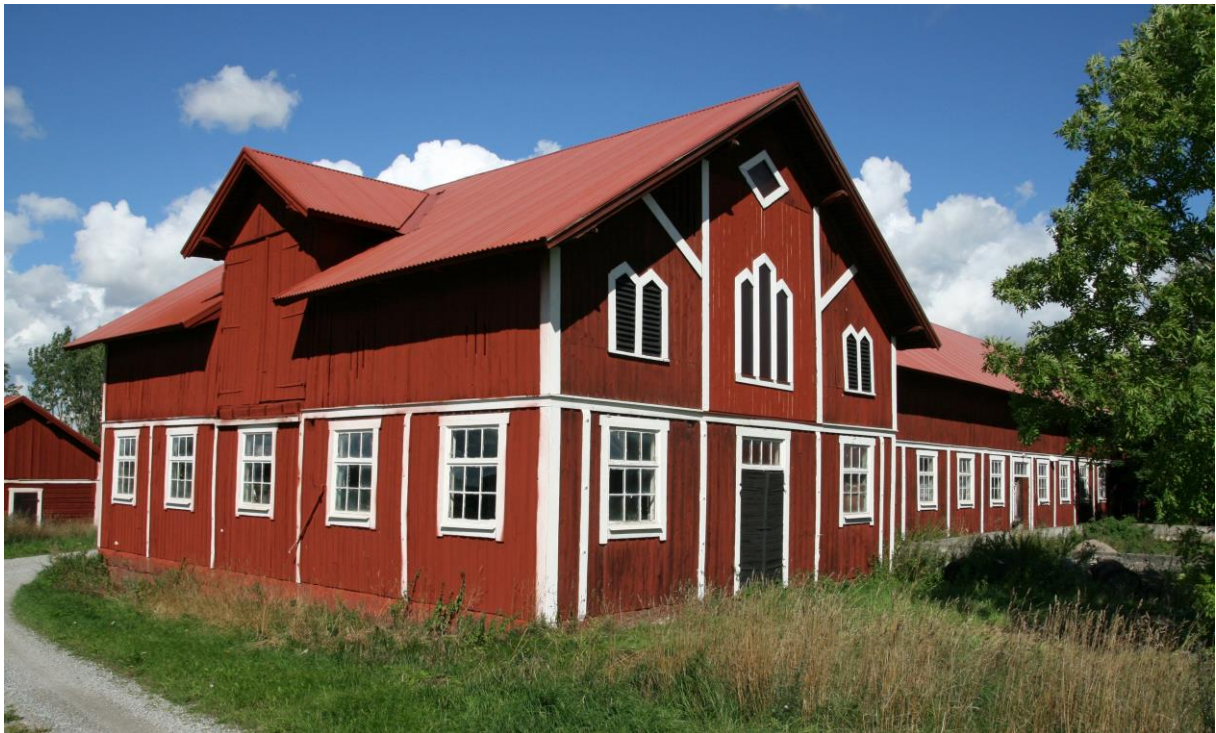
Ladugårdsbyggnad med småspröjsade fönster, öppningsbara ovanför tvärposten, och spetsbågiga omfattningar kring jalsiöppningarna. Ladugård från 1890-talet, Vii gård, Övergrans socken, Håbo kommun.
