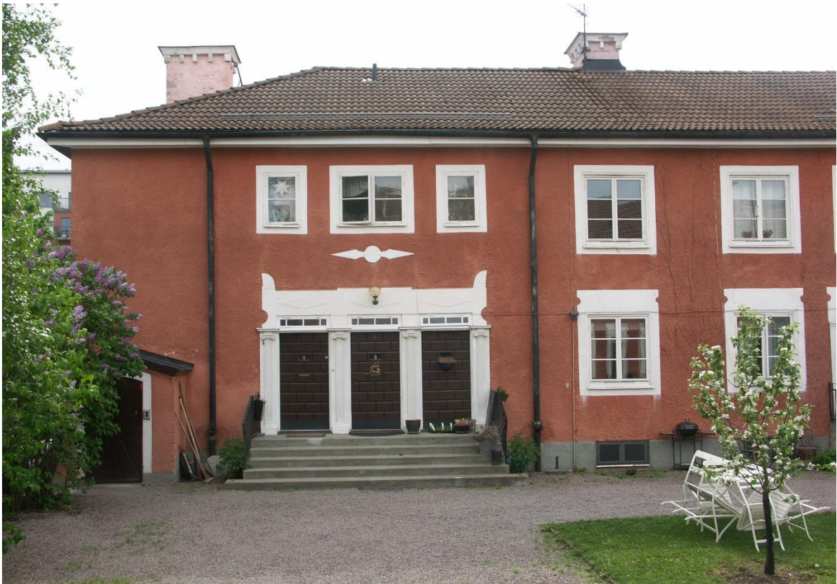
Spröjsade fönster av varierande typ samt överljusfönster ovanför entréerna. Klassicerande och profilerade fönsteromfattningar och dörromfattningar med pilastrar krönta av joniska kapital. "Rödbo", hyreshus uppfört 1924, kvarteret Hovstallängen, Kungsängsgatan 49, Uppsala.
