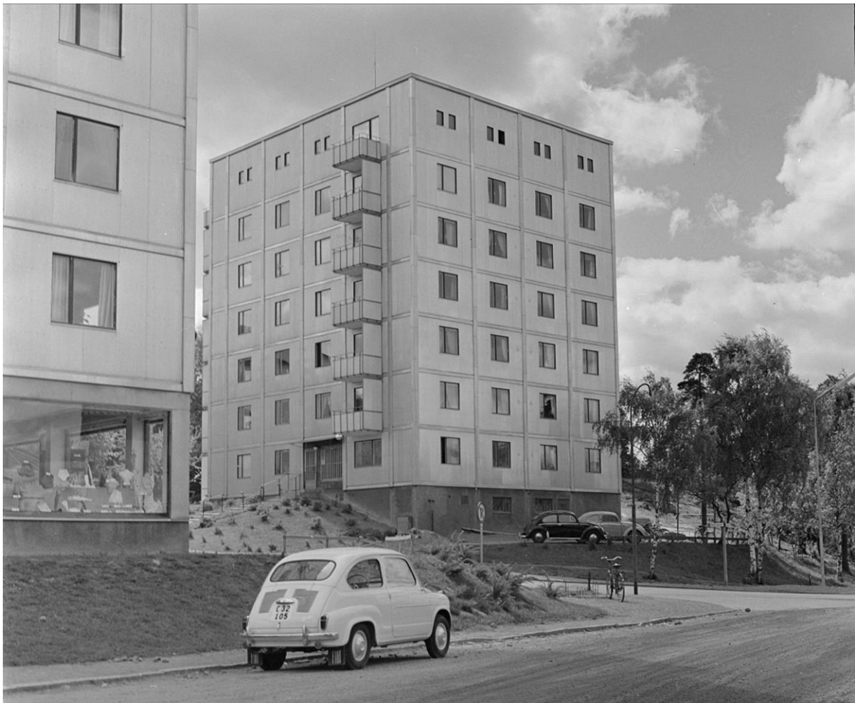
Tidstypiska asymmetriska tvåluftsfönster med vädringsbåge och mörka fönsterbågar. ”Aluminiumhusen”, med ritningsår 1953, kvarteren Gustavsberg och Lindsberg, Karlsrogatan 82 och 81, Uppsala.
