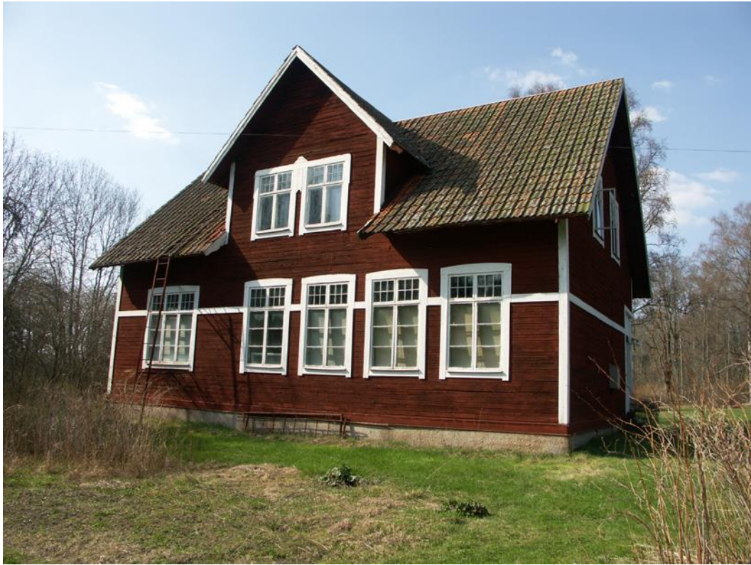
Höga fönster för bra ljusinsläpp i skolsalen. Fönster med mittpost och tvärpost, med småspröjsade rutor ovanför tvärposten. Figursågade, profilerade fönsteromfattningar. Fd Salsta småskola från 1915, Lena socken, Uppsala kommun.
