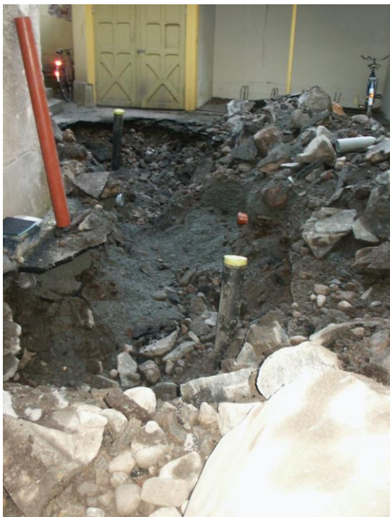
Figur 3. Översikt av schaktet mellan de två borrhålen.
