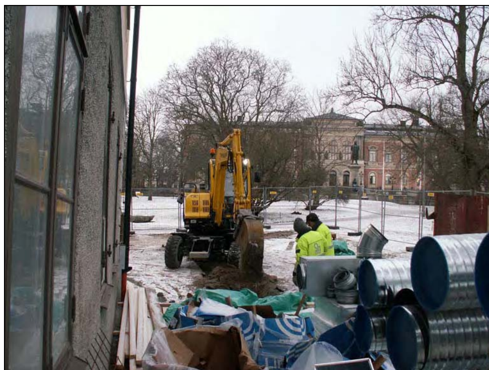
Figur 8. Schaktningen för grundvattenkyla. Till vänster ses Historicums fasad och i bakgrunden ses universitetshuset. Foto mot SSV av Anna Ölund, Upplandsmuseet.
