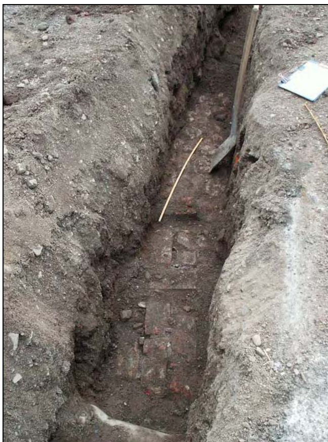
Figur 10. Foto av tegelmuren A1. Mot N
