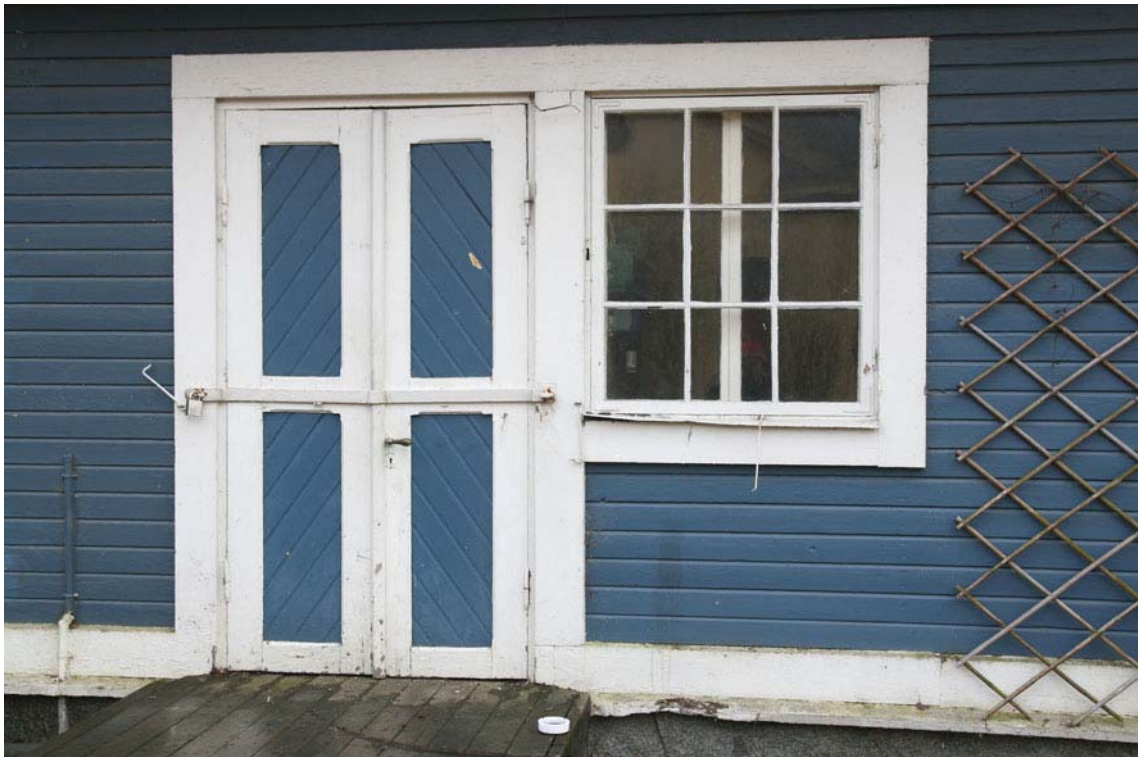
Hus 62. Dörrarna har fyllningar med pärlspontpanel. De tätspöksade fönstren är ursprungliga.
