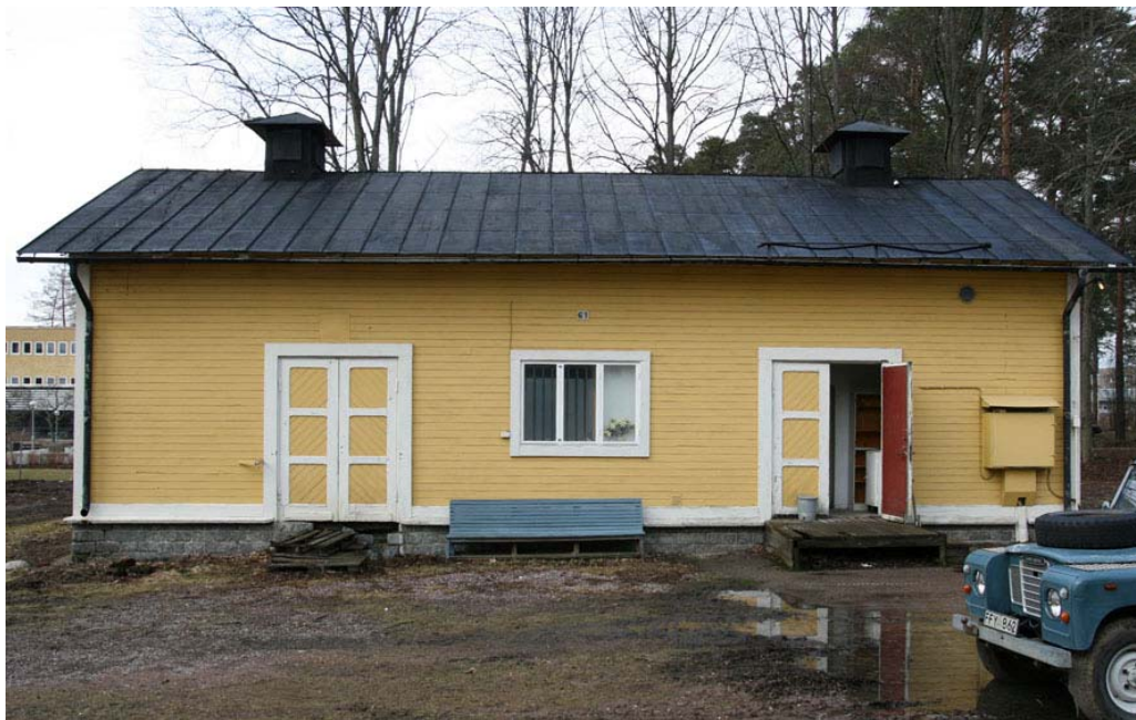
Hus 61, fasad mot söder. Fönstret insatt i senare tid.
