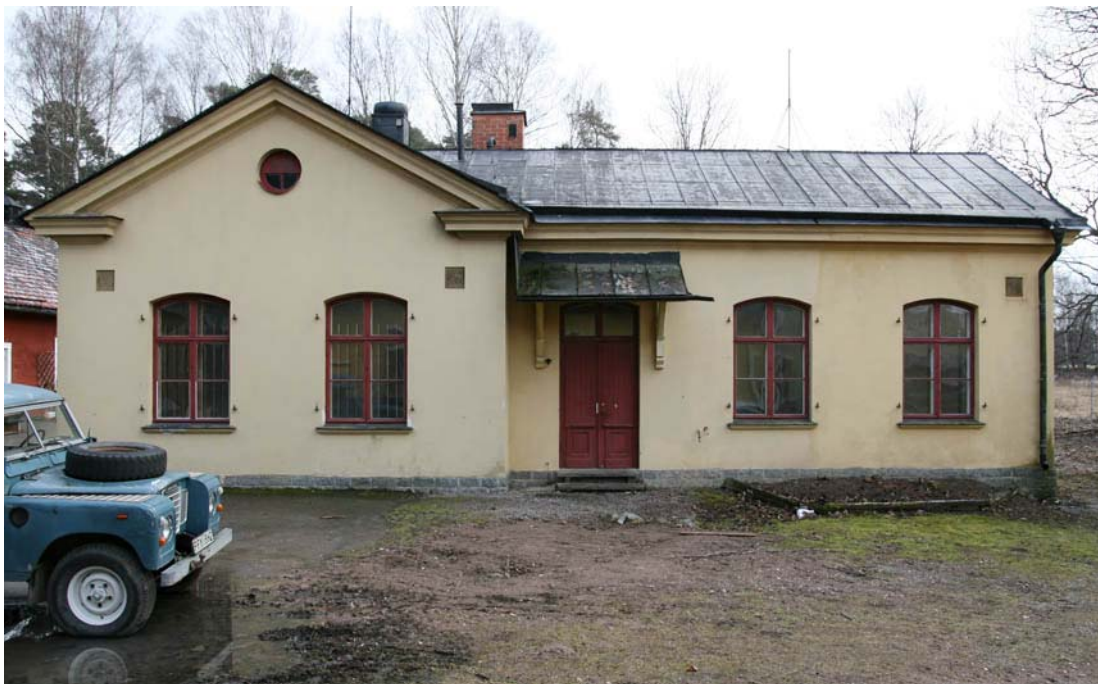
Hus 60 är byggt i tegel med putsade fasader på 1870-talet. Fasad mot norr.
