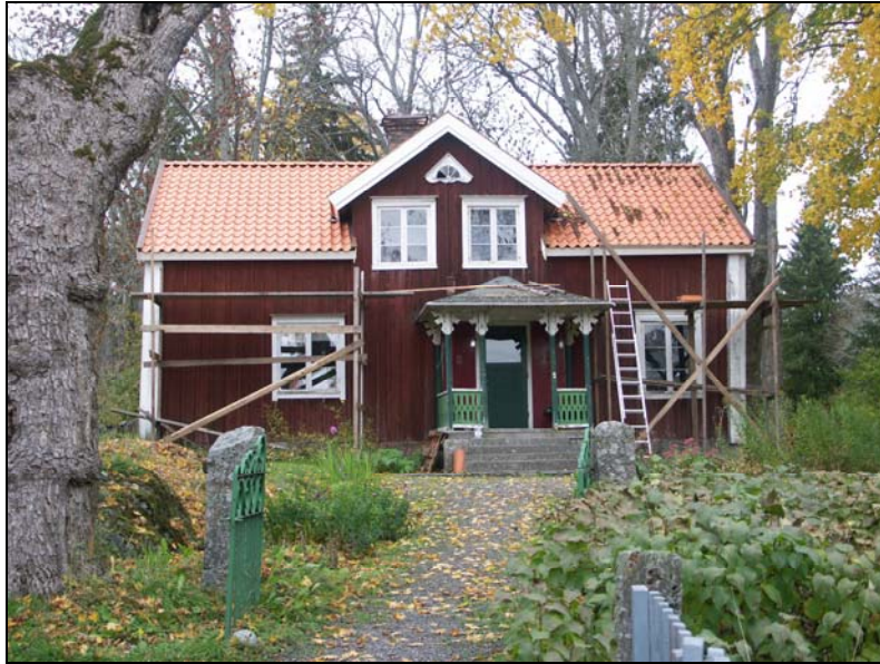
Manbyggnaden efter takomläggning.
