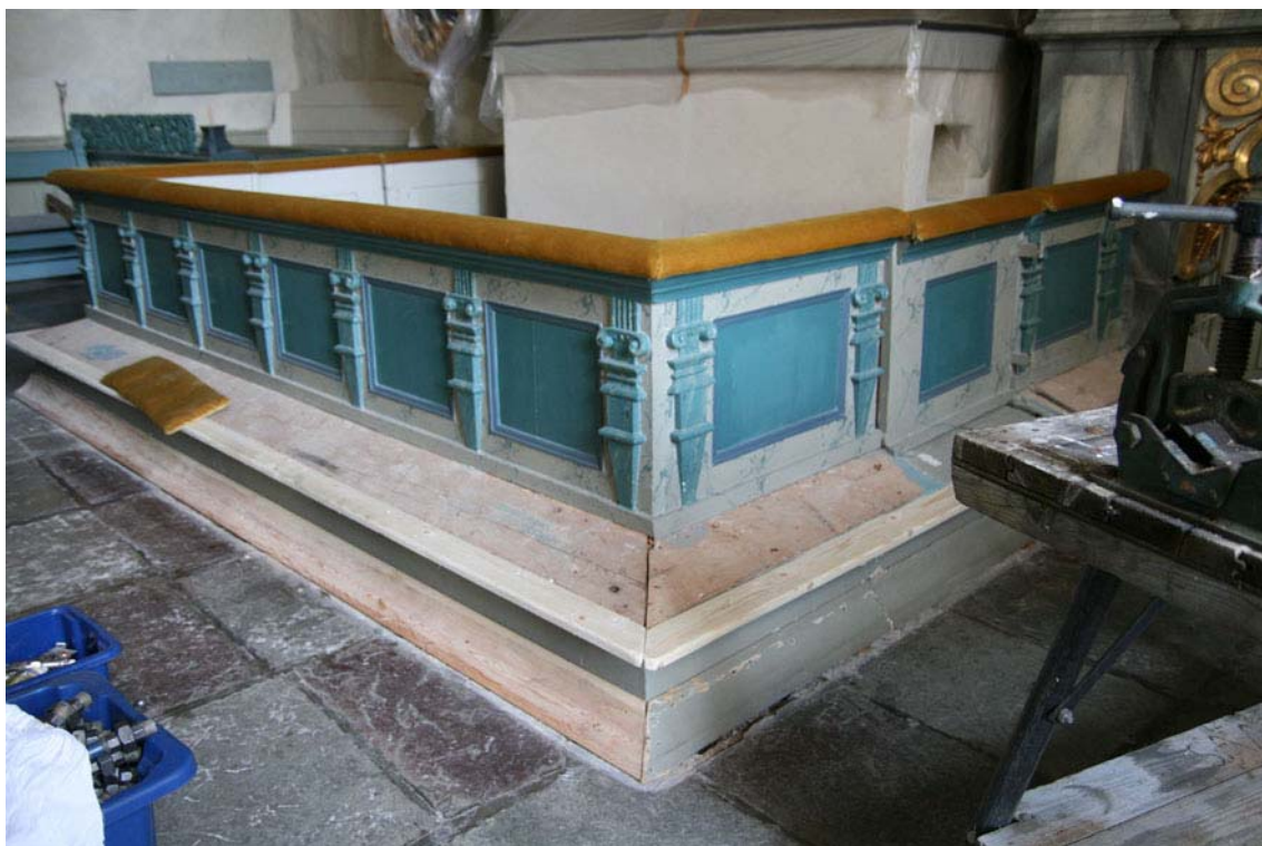
Knäfallet under ombyggnad. Knäfallet breddades. Sockellisten med hålkälsprofil har kompletterats med ny list där den var rötskadad.
