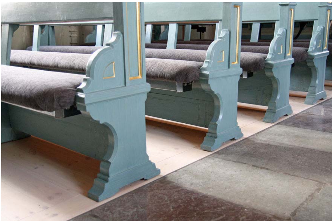
Det nya brädgolvet som har karaktären av traditionellt trägolv. Bänkarna är bättringsmålade. Under sitsarna skymtar de nya bänkvärmarna.
