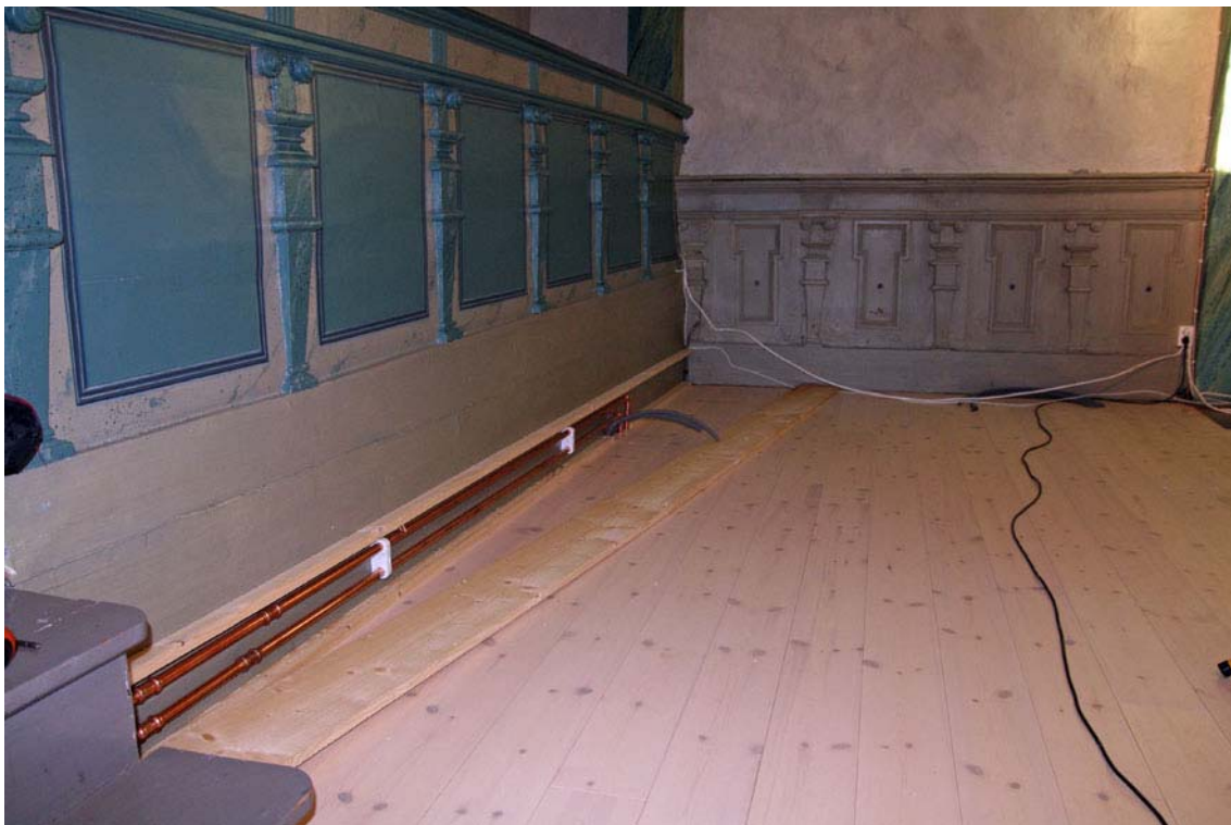
Det nya brädgolvet liknar ett traditionellt trägolv. Till vänster ses hur värmeledningarna byggts in i en träsockel. Sockeln målades sedan i samma färg som bakomliggande panel.
