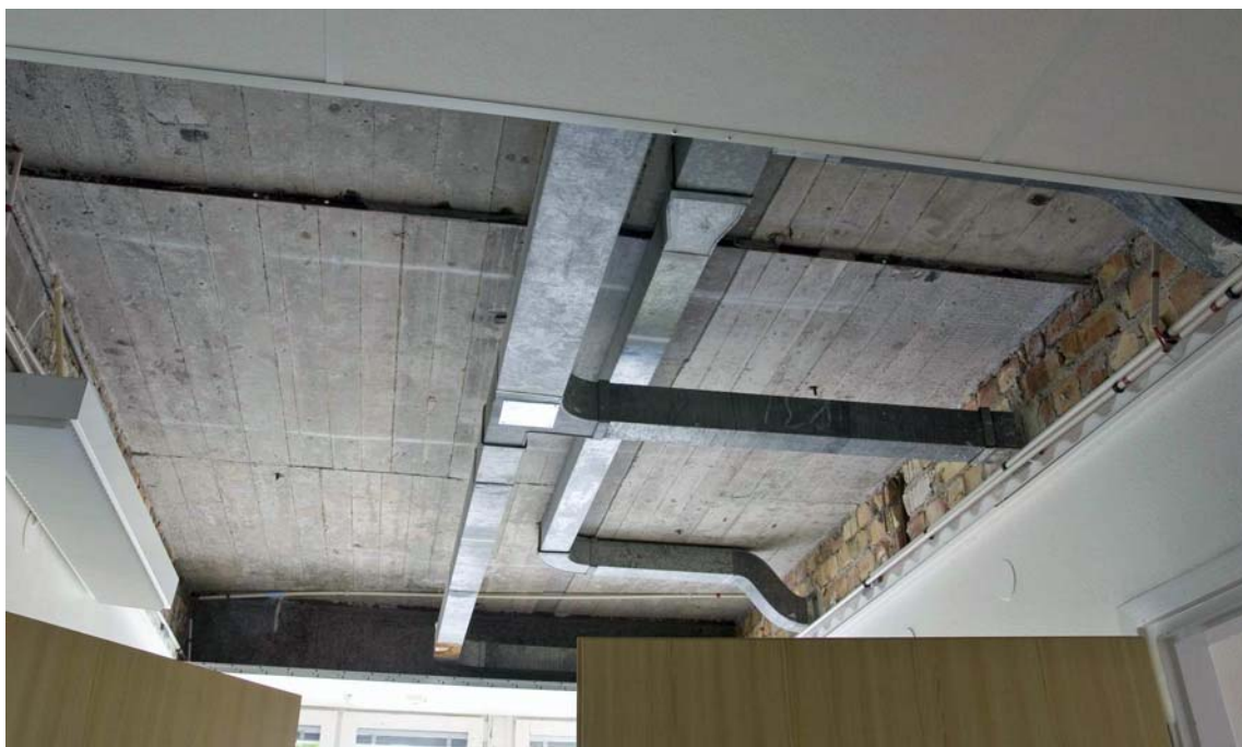
Vårdavdelningarna har nedpendlade undertak som döljer ventilationrör. Här ses att bjälklagen är gjorda av armerad betong. Väggarna är murade av gult tegel. DIG005905
