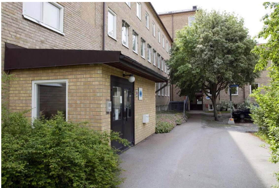
Framför trapphuset på västra sidan av vårdavdelningarna har gjorts en utbyggnad i gult tegel. Även fönster och ytterdörrar har bytts ut på hela byggnaden. Endast i sutterrängvåningen och i trapphusen finns de gamla fönstersnickerierna bevarade. DIG005889
