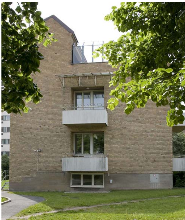
Gavelfasad mot norr med vädringsbalkonger. På tredje våningen ligger terrassen omgärdad av ett högt skyddsräcke. DIG005886
