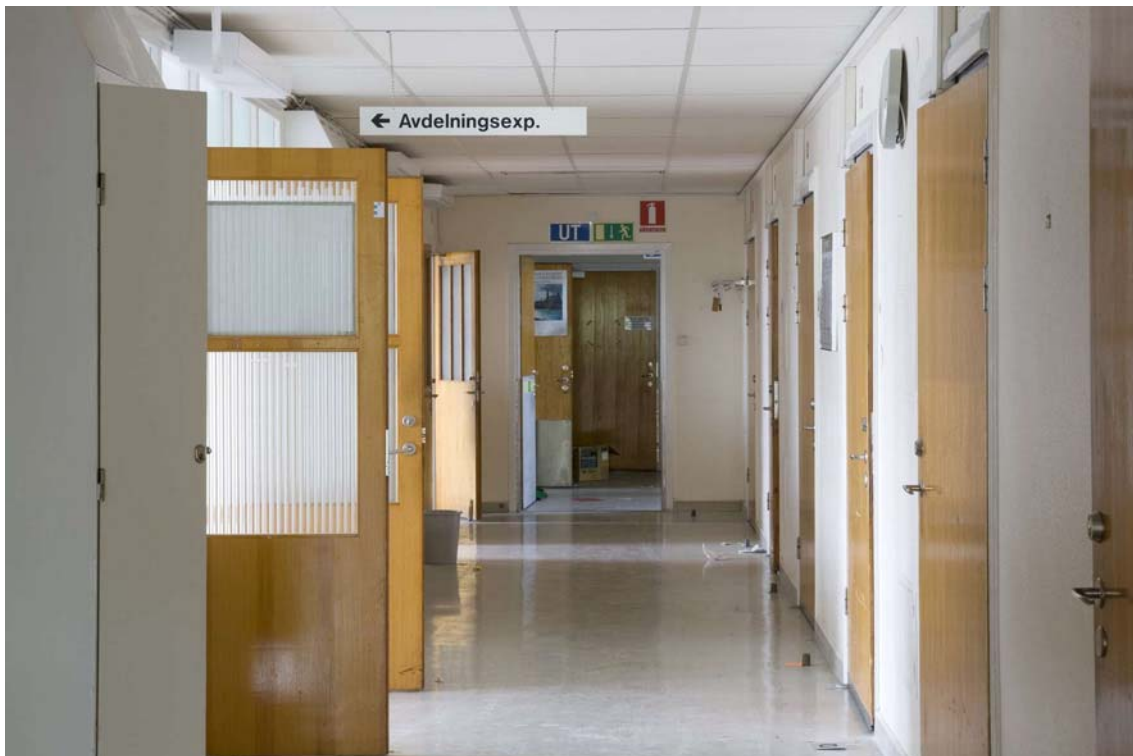
Interiör från korridor på en av vårdavdelningarna. Ursprungliga fanerklädda dörrar finns bevarade till de flesta av rummen. DIG005910
