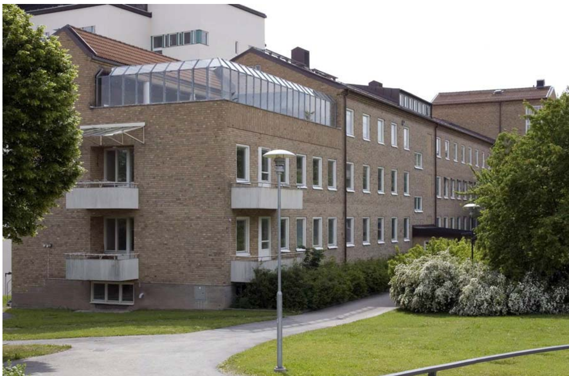
Vy från norr mot vårdavdelningarna. Här ses takterrassens höga skyddsräcke för att förhindra eventuella försök att hoppa från taket. DIG005887
