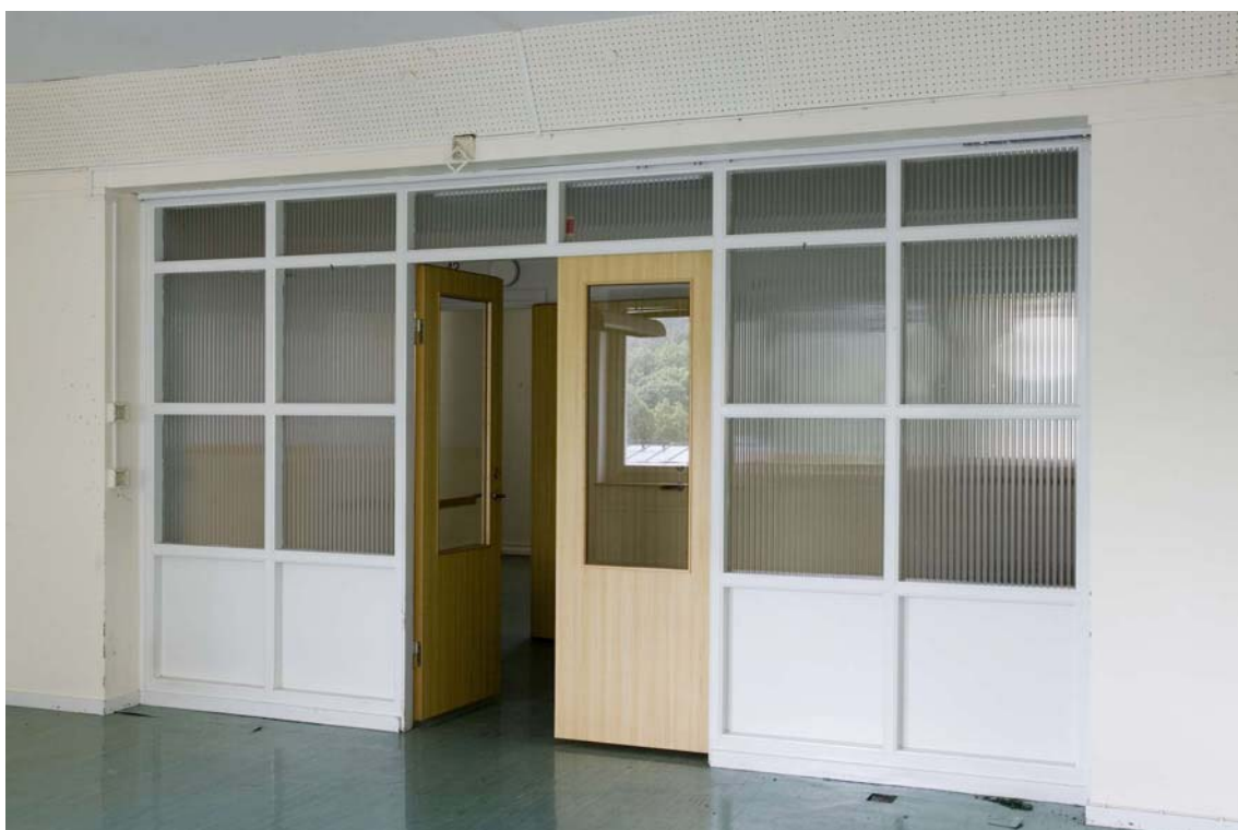
Avdelningen för oroliga och halvoroliga patienter på bottenvåningen. Rum för sex patienter med glasad trävägg ut mot korridoren. På denna avdelning har de gamla fanérdörrarna bytts mot nya laminatklädda dörrar. Golven på avdelningarna är täckta med linoleummattor. DIG005901
