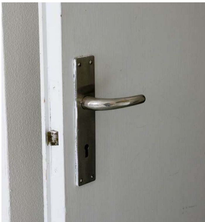
Vitmålad dörr på en av vårdavdelningarna med originaltrycke i rostfritt stål från 1940-talet. DIG005900
