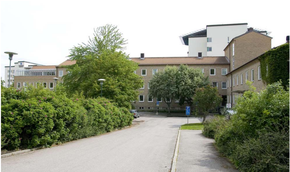
Vy från väster med sängbyggnaden i fonden och behandlingsbyggnaden till höger. Där de bägge byggnadsdelarna möts sticker en högre del med trapphus och hiss upp. Det gula fasadteglet är karakteristiskt för 1940-talets funktionalism som ofta har en mjukare framtoning än 1930-talets funktionalism. DIG005880.
