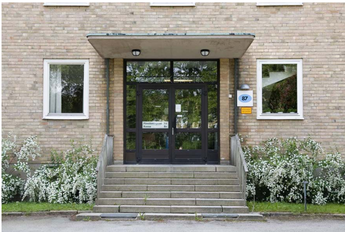
Entrén till kliniken har försetts med nya aluminiumpartier. Över dörrarna står det POLIKLINIK med stora bokstäver av rostfritt stål. Trappan av granit och räcket i stål samt det kopparklädda skärmtaket bidrar till en representativ entré i gedigna material. DIG005876
