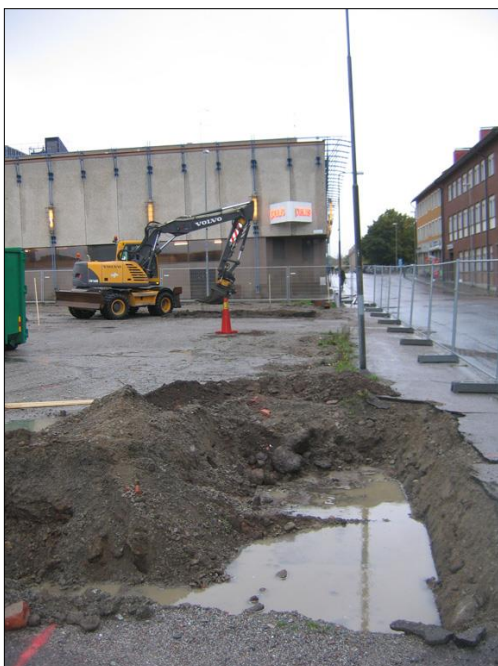
Figur 2. Undersökningsytan vid de inledande schaktningarna för grundläggning i december 2006.
