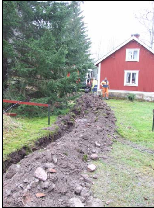
Figur 12. I schakt 6 påträffades lämningar av ett raseringslager troligen tillhörande föregångaren till dagens mjölnartorp.
