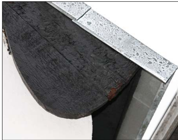
Detaljutförande av taksprång och gavelski- vor innan respektive efter omläggning.
