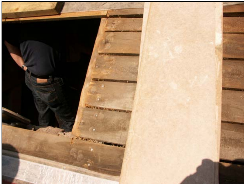
Underbrädningen var i förhållandevis god kondition och mycket lite behövde bytas.
