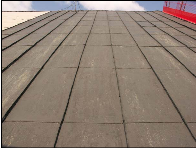
Den gamla plåtens läggningsmönster med hakfalsar på linje.
