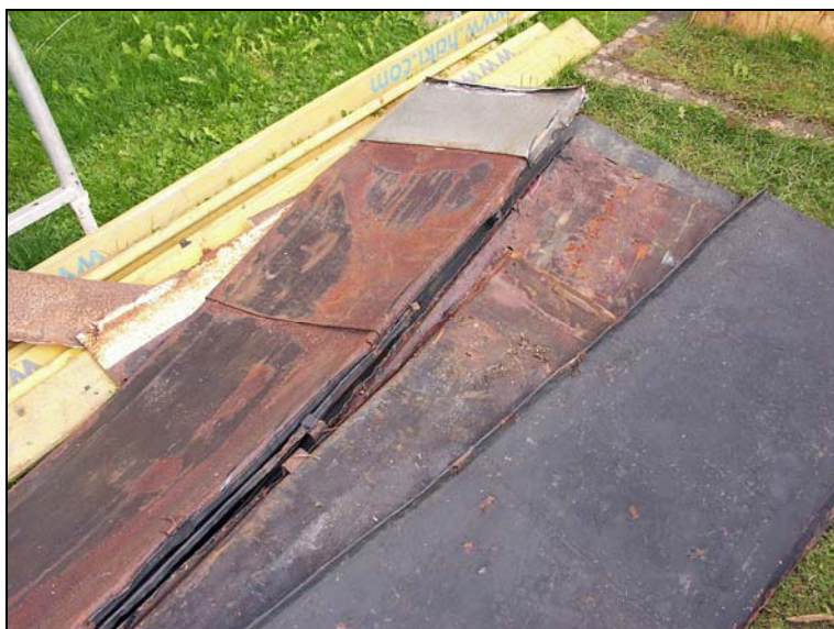
Den gamla plåten från 1880. Plåten var målad med oljefärg på undersidan.
