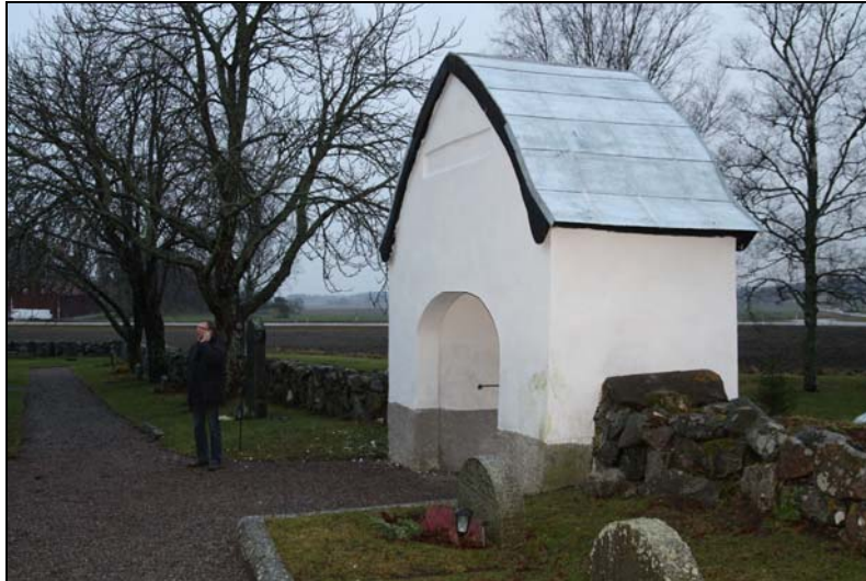
Stigporten i väster efter omläggning.
