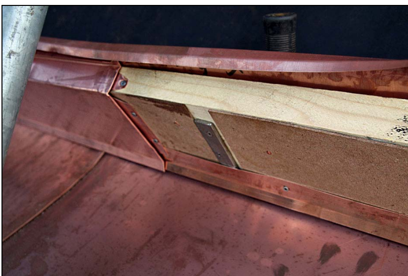
Plättäckning av fotrännans stomme.
