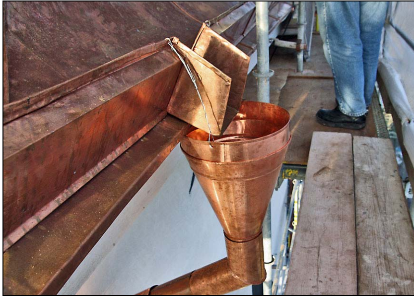
Nya koniska vattkypor med sarg tillverkades. Tornet fick nya 120 mm stuprör. Ståndrännan utfördes med trästomme.
