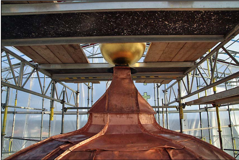
Anslutning mellan toppkarnis och krönkors efter restaurering.
