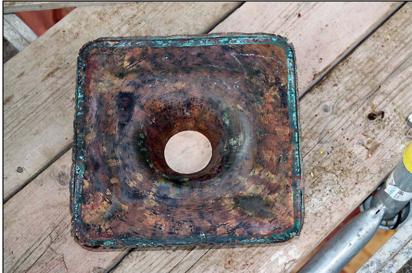
Prydnadens koppertratt som ansluter klotet till fundamentet
