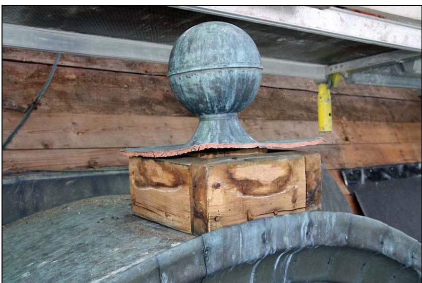
Prydnaden med borttagen plåt för fundamentets stomme.
