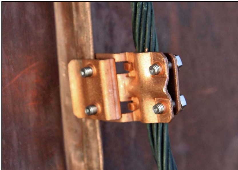
Infästning av åskledarlina med falskramla i kopparkets ståndfals.
