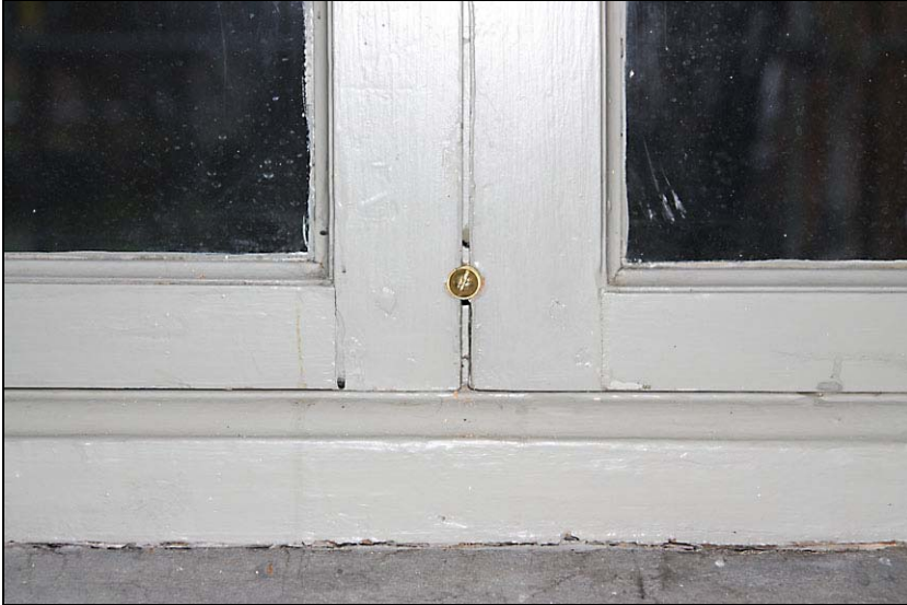
Ny kopplingskruv och bricka i mässing på inner- bågen.
