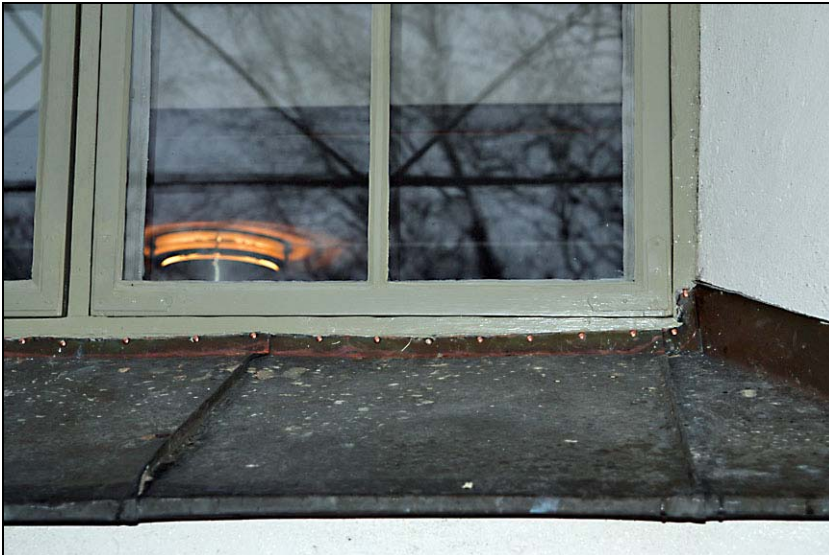
Fönsterblecket har sikats till med ny kopparspik.
