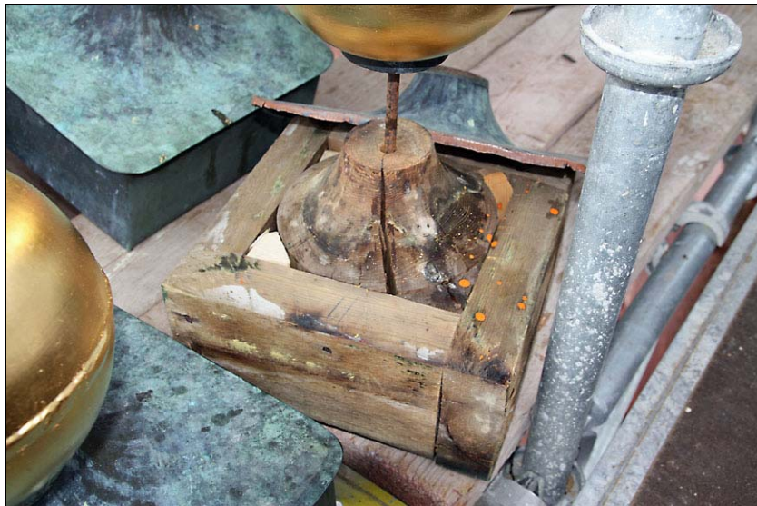
Trästimme för fundament och tratt. Klotet har förgyllts.
