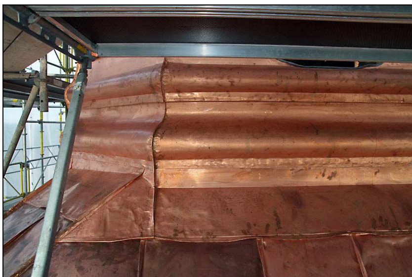
Efter reparation och omtäckning med ny kopparplåt.
