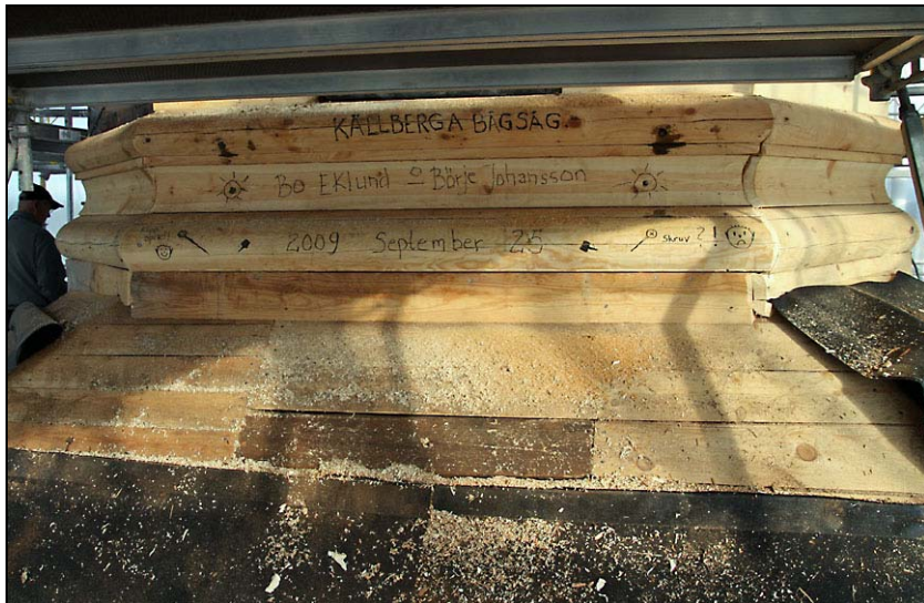
Nya stommar lika de gamla tillverkades och dålig underbrädning ersattes med ny.
