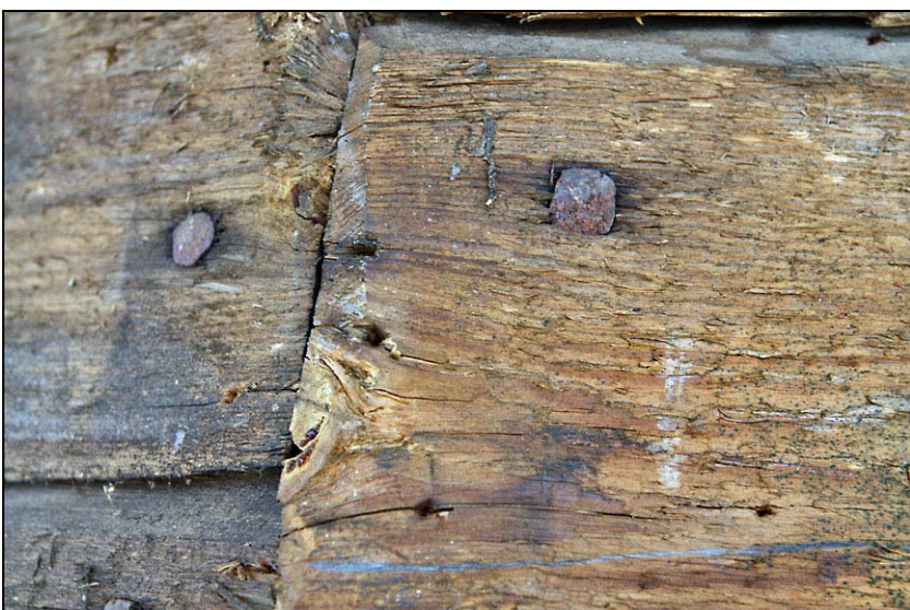
Underbrädningen var till stora delar äldre än från 1930-talet. Den äldre panelen var ramsågade och spikad med smidd spik. På bräderna fanns spikhål, förmodligen från den gamla spåntäckningen. Bräderna överlappar varandra genom snedhyvling av kanterna.
