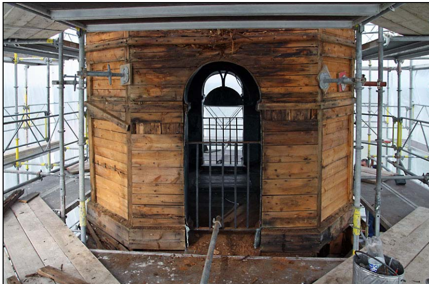
Lanterninens väggar med plåt-täckningen bort-tagen.
