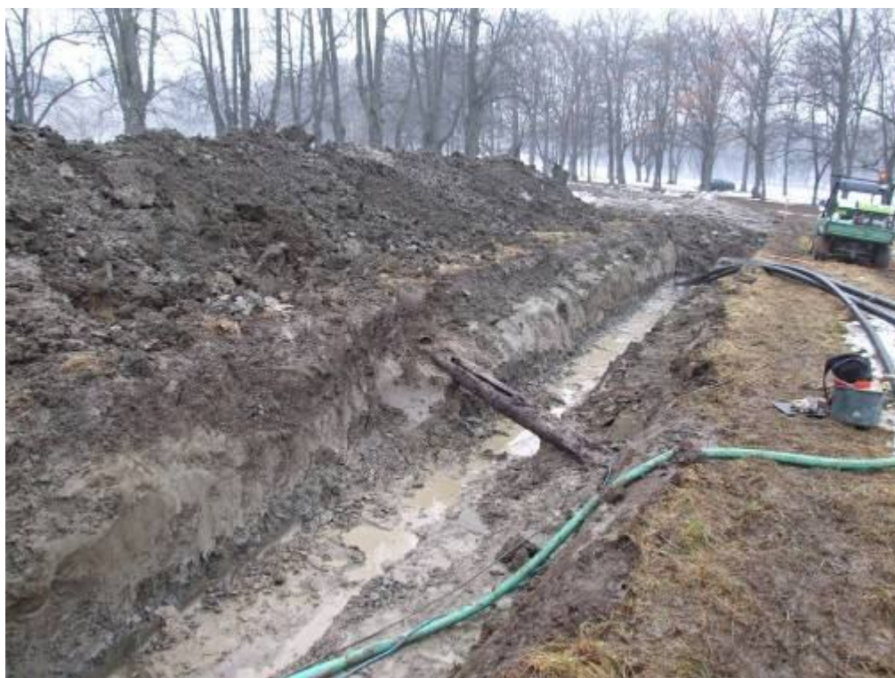
Figur 25. Bevarat trärör som transporterat vatten till vattenkonsten Gåsen i södra boskén. I bakgrunden syns dels den södra slottsallén (th) och dels den fyrradiga lindallén Spanska Trappan . Foto mot norr, Anna Ölund Upplandsmuseet.
