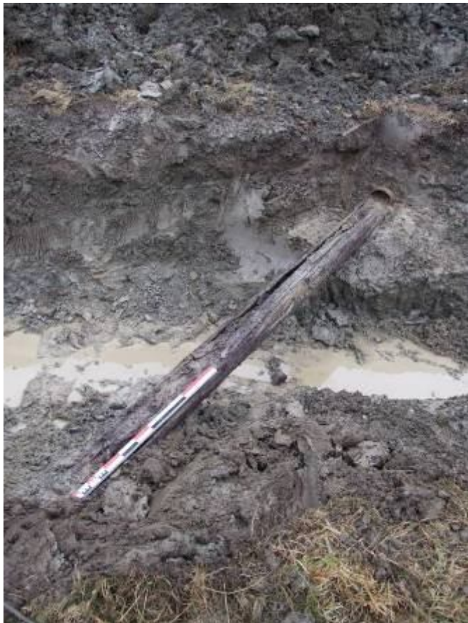
Figur 26. A5. Urholkad trästock av gran med järnring. Denna och ett flertal liknande trästockar har fungerat som vattenrör, vilka försett Ekolsunds slottsträdgårds vattenkonster med vatten. Foto mot väster, Anna Ölund Upplandsmuseet.
