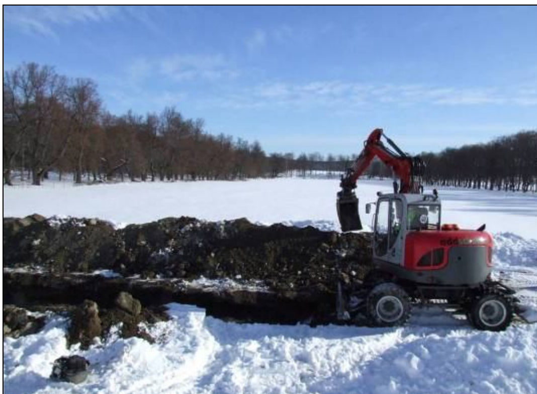
Figur 14. Schaktning över den vidsträckta parterren öster om slottsbyggnaden. Parterren sluttar svagt mot öster ned mot Hjalstaviken och omges av en dubbelallé i söder och norr. Foto mot öster, Anna Ölund Upplandsmuseet.
