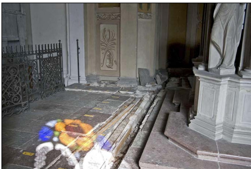
2009-09-14 (JD). Kalstensgolvet i gravkoret har tagits upp för ledningsdragnings.
