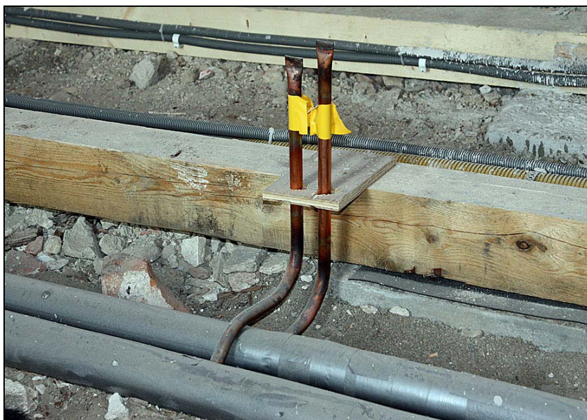
2009-12-01. Detalj av vattenrören och bärlinan till långhusgolvet.
