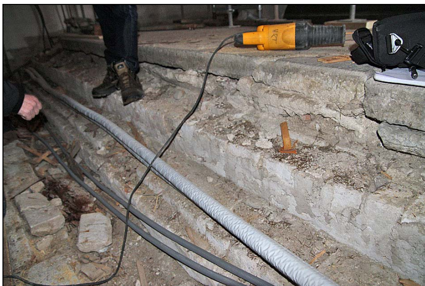
2010-01-26. Den gamla träkorrappan har rivits.
