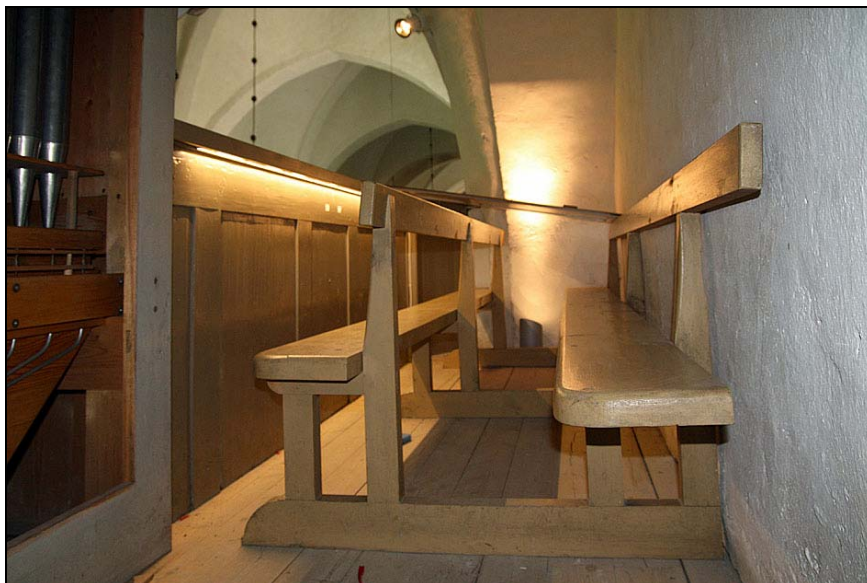
2010-06-03. ny LED-belysning på den södra sidoläktaren.
