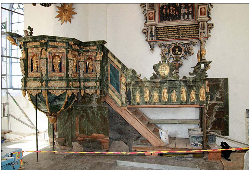
2010-02-23 . Predikstolen efter demontering av bänkar och det gamla tegelgolvet. Ett nytt kalkstensgolv har lagts.
