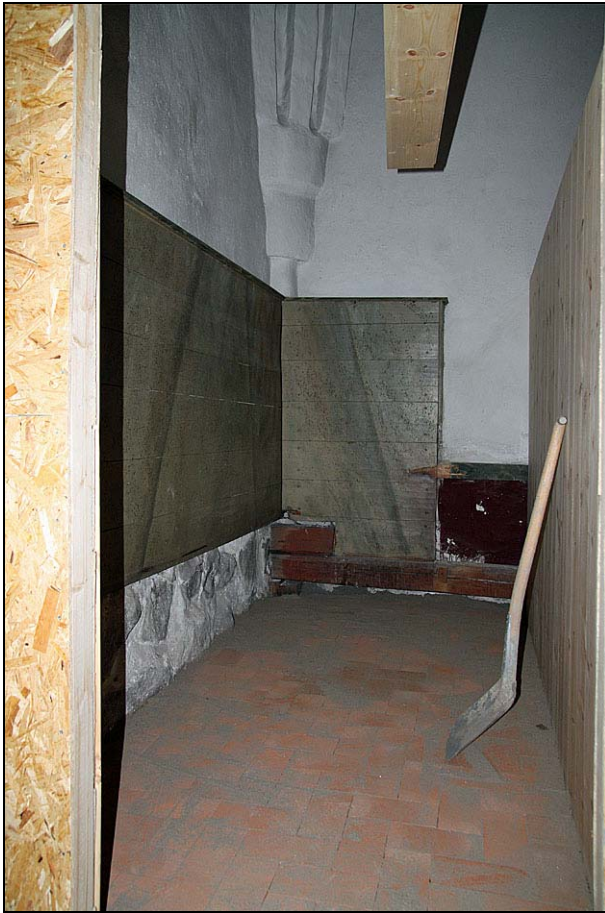
2009-12-01. Det västra biutrymmet i södra korsarmen under uppförande.
