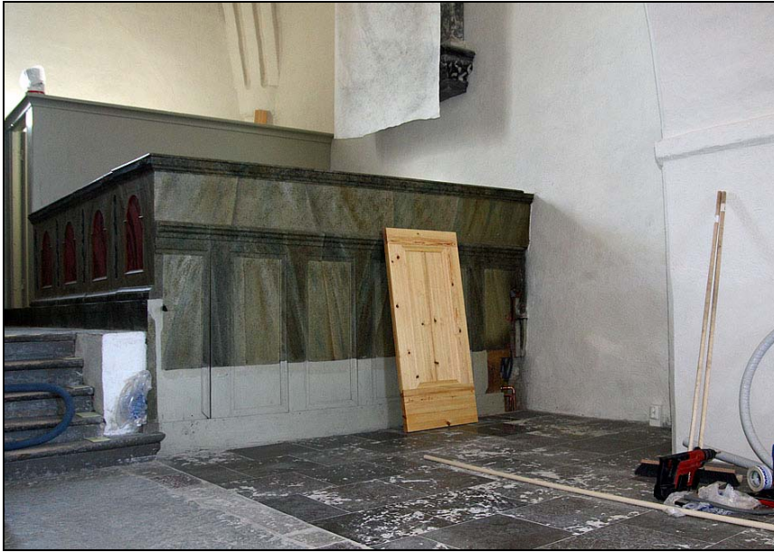
2010-04-13. Södra korsarmens bänkfront efter lagning och grundstrykning men innan färdigmålning.
