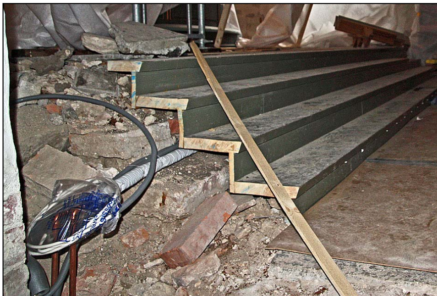
2010-01-12. Den gamla korrappan i trä har sågats upp för installationsarbete.
