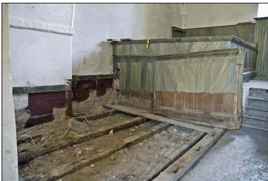
2009-09-14 (JD). De nedre delen av den södra korsarmens östra kvarter efter demontering av bänkar. Tröskelstocken och bärlinorna magasineras.
