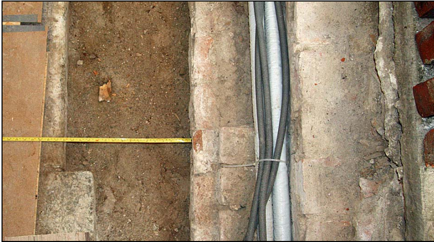
2010-03-02. Blottlagt tegelmurverk efter rivning av den gamla korttrappan
