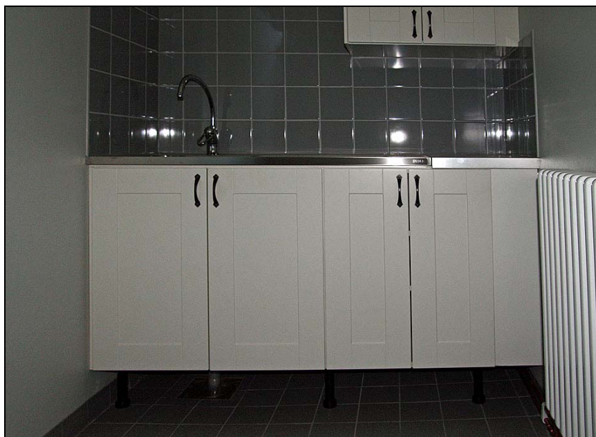
2010-06-03. Det östra biutrymmet med färdigställd inredning.
