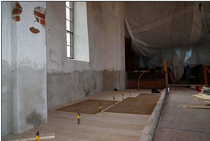
2009-12-01. Det nya grangolvet i långhusets norra bänkkvarter har lagts klart. Den gamla tröskelstocken har bevarats. Väggens nederdel är nyputsad men ännu inte avfärgad.
