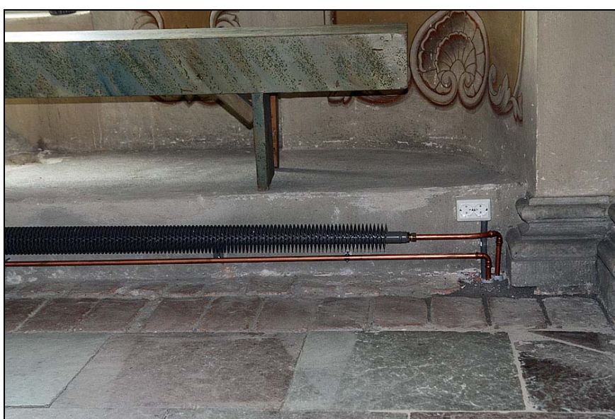
2010-06-03. Ny kamflänsradiator monterad vid fönsternischen till gravkorets södra vägg. Kopparrören kommer att målas in i bakomliggande färg.
