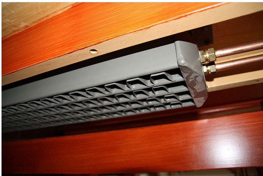
2010-06-03. Bänkvär- mare monterad under den nya bänksitsen.
