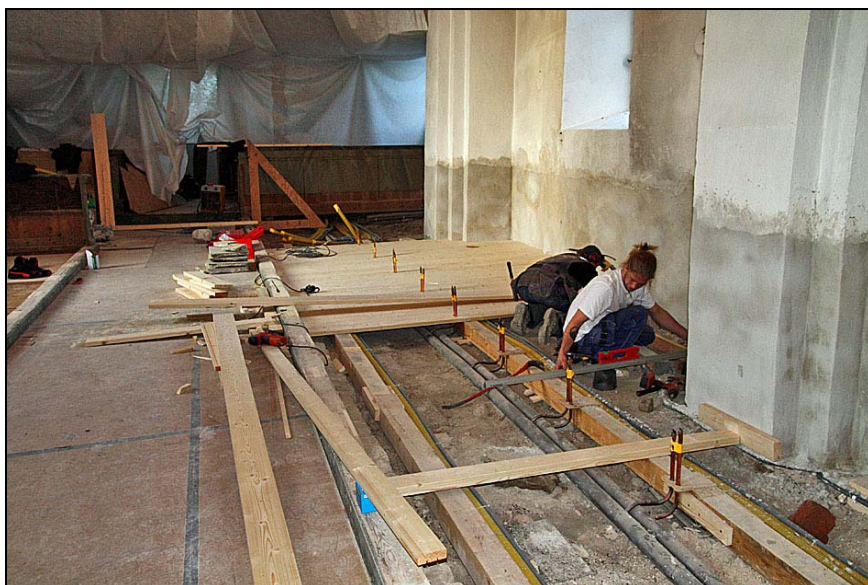
2009-12-01. Läggning av golv i lånhusets södra del. Både golv och bärlinor är nya. Kopparrören för bänkvärmarnas till- respektive frånvatten löper i två slangar mellan de båda bärlinorna.
