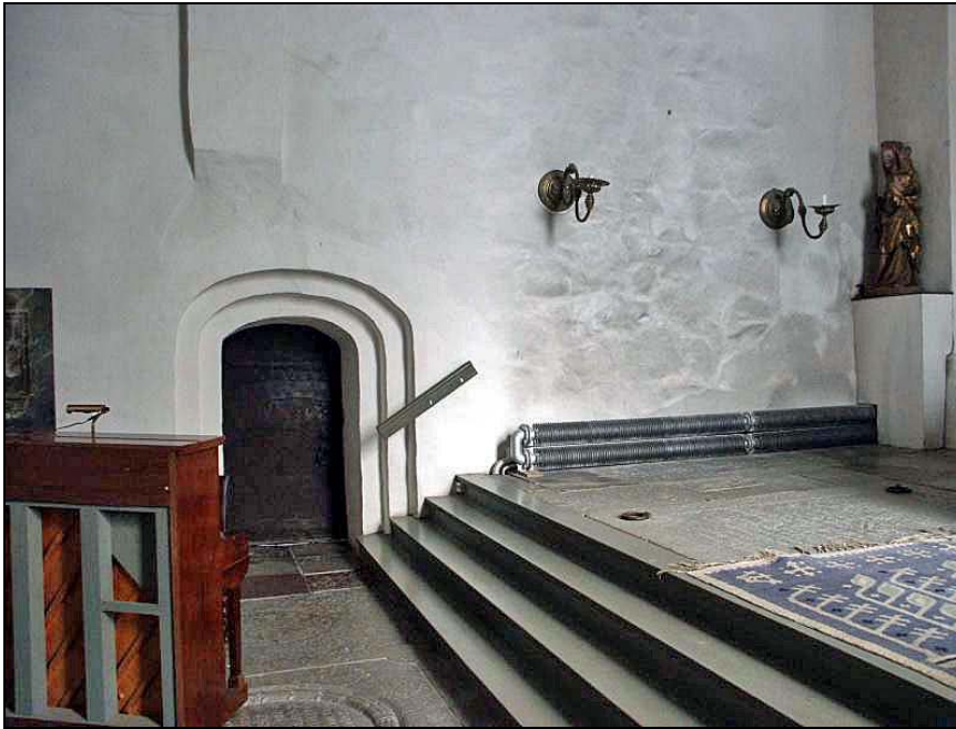
2009-08-31 (JD). Träkortrappans anslutning till den medeltida korbänken, som delvis var inklädd..
