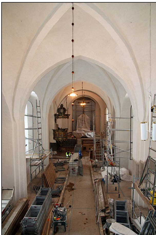
2010-02-09. Det nya grangolvet i bänkkvarteren har lagts och ställningsbygge pågår.
