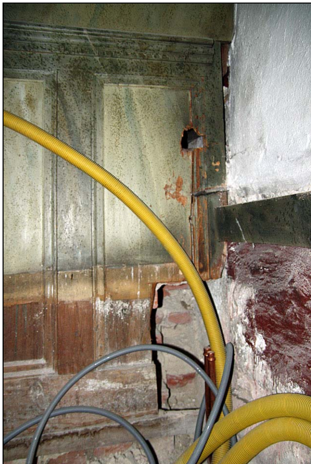
2010-01-26. Västra bänkfronten i södra korsarmens övre del.
