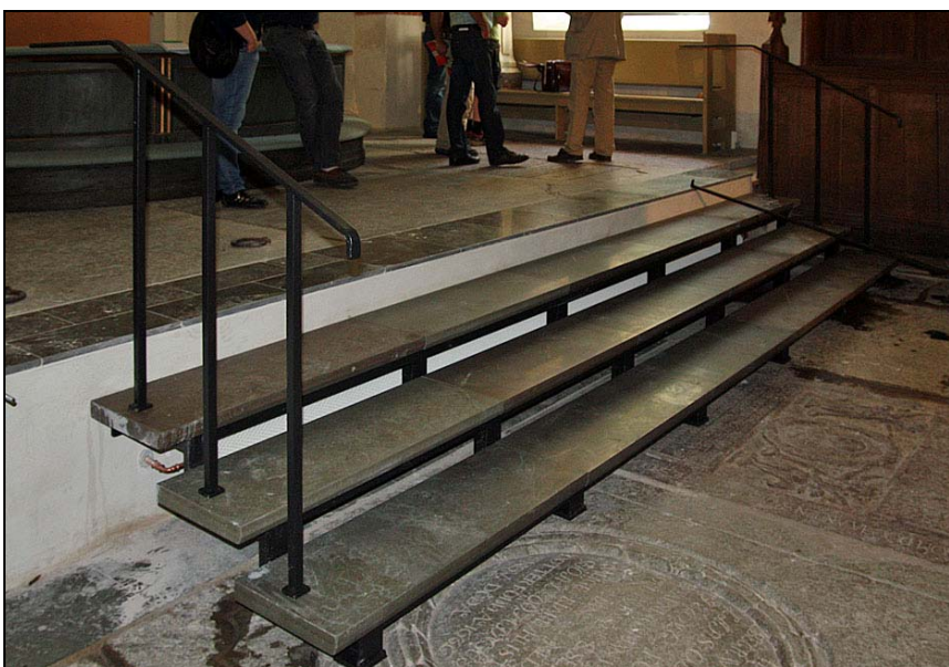
2010-06-03. Den nya korttrappan med kalkstensplattor på en konstruktion av järnsmide och stål har monterats.
