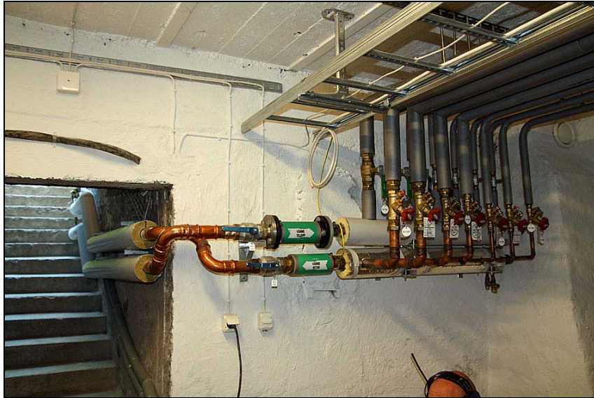
2010-06-03. Ledningarna för det nya värmesystemet löper in från ett hål i trapploppets södra vägg. Hålet ligger under marknivå.
