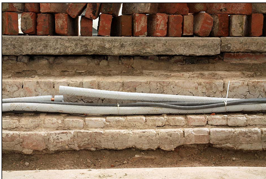
2010-03-02. Blottlagt tegelmurverk efter rivning av den gamla korrappan
