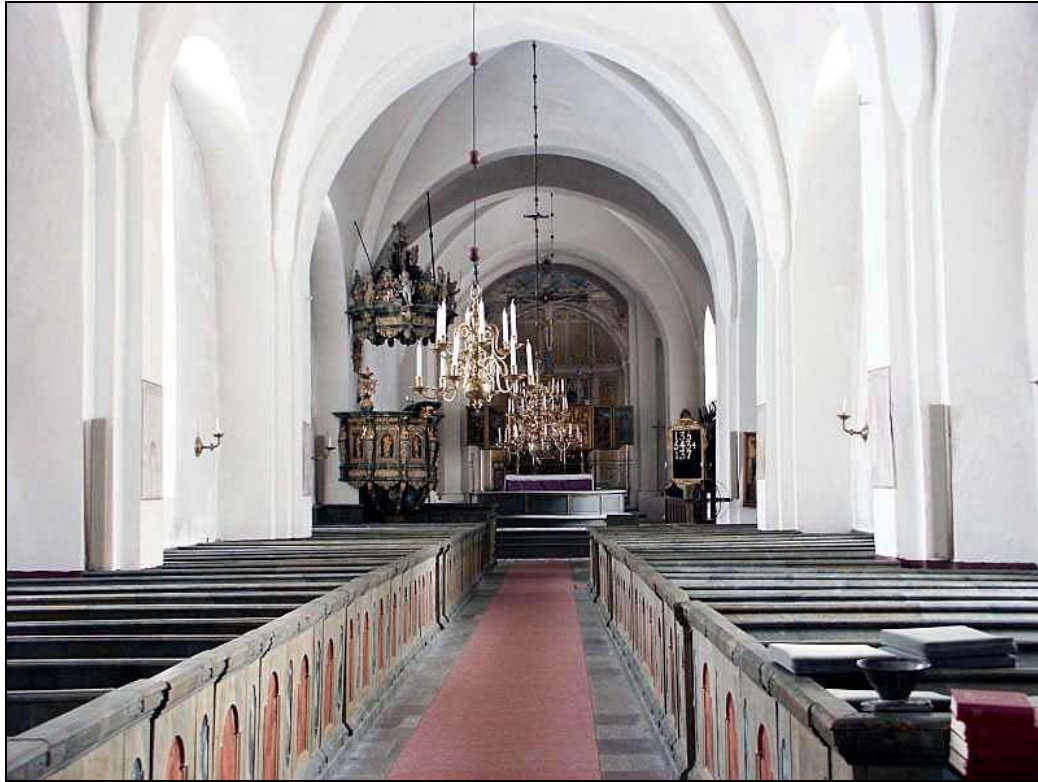
2005 (JD). Långhuset mot öster innan restaureringen.
