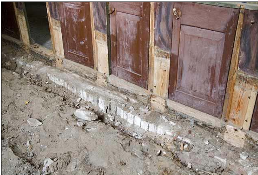
2009-08-21 (JD). Insidan av bänkgavlar och luckor i det södra långhuskvarteret under pågående demontering. Den gamla bänkinredningens ryggar och sitsar avtecknar sig som omålade partier på bänkgavlarna. Enligt uppgift breddades gav-larna i det södra kvarteret 1926, vilket man kan se spår av på bilden.
