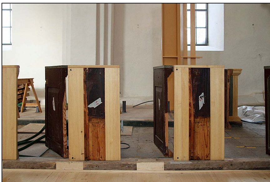
2010-03-16. De breddade bänkgavlarna har monterats på den ilagade tröskelstocken.
