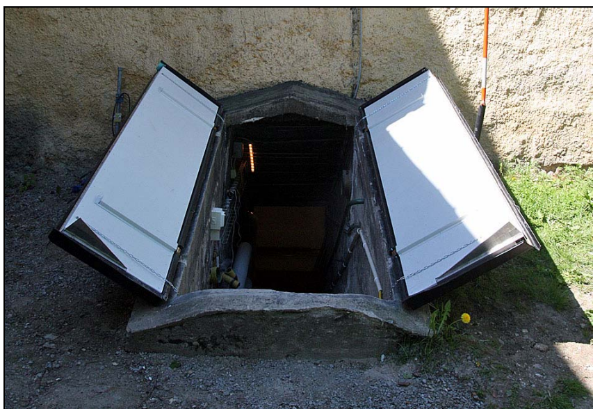
2010-06-03. Luckorna till källaren har fått en förbättrad isolering
