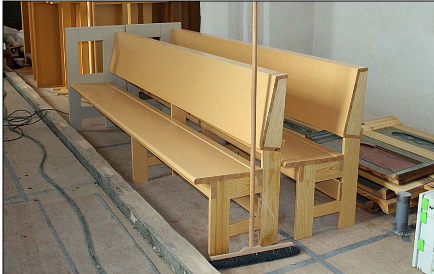
2010-03-16. De nya kyrkbänkarna inför montering. Bänkarna har grundmållats på snickeriet.
