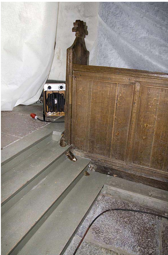
2009-08-31 (JD). Träkortrappans anslutning till den medeltida korbänken, som delvis var inklädd..
