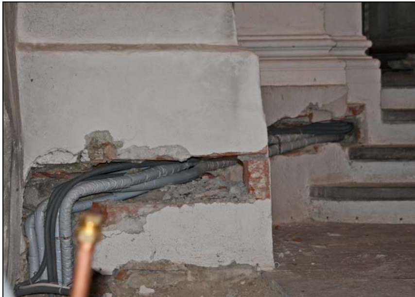
2010-01-12. Nya rör till gravkoret har dragits i de gamla kanalerna genom korts väggpelare.
