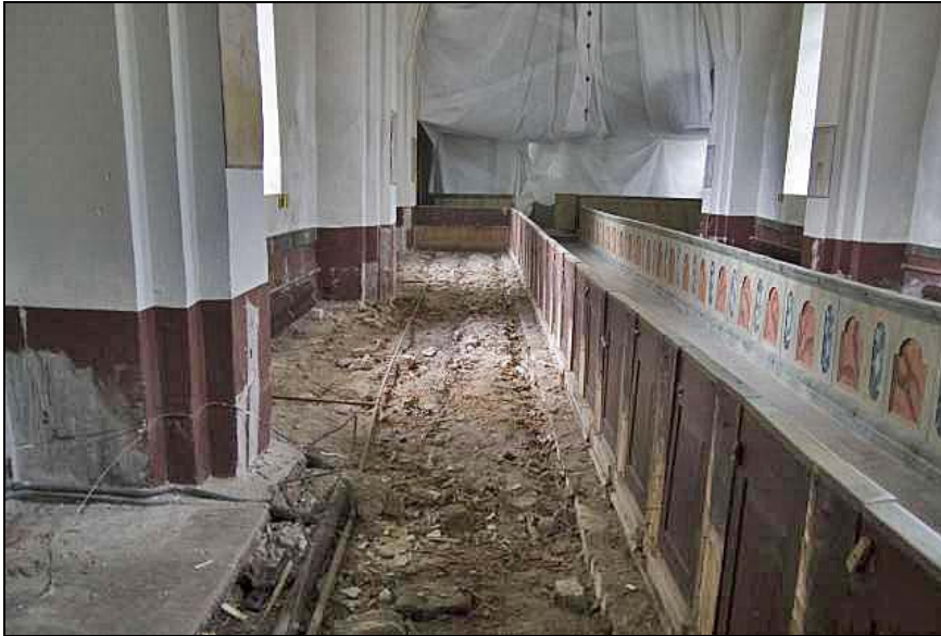
2009-08-21 (JD). Södra långhuskvarteret efter demontering av bänkar och golv.
