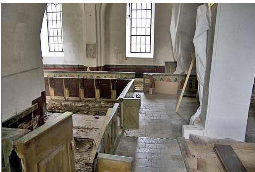
2009-08-21 (JD). Södra korsarmen mot söder under demontering av bänkkvarter.
