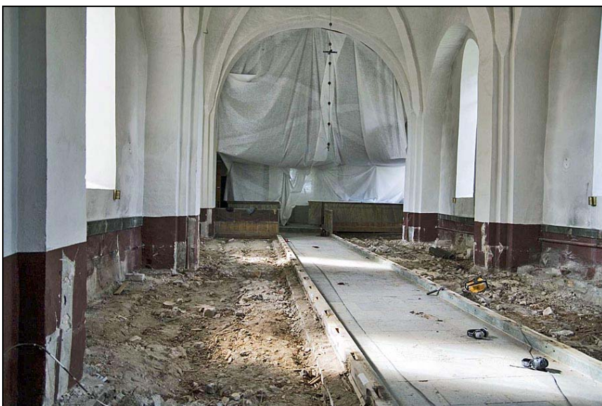
2009-08-31 (JD). Långhusets bänkinredning och golv har demonterats. Den gamla tröskelstocken, som återanvändes efter lagningar, ligger fortfarande på plats. Väggarnas bröstning är målad med oljefärg i samma färg som bänkinredningens insida.
