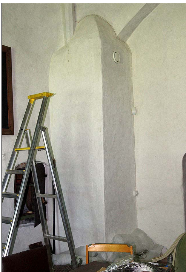
2010-06-03. Sakristian har fått en ny frånluftsventil som leder in i den gamla skorstenspipan vid kyrkans östvägg.
