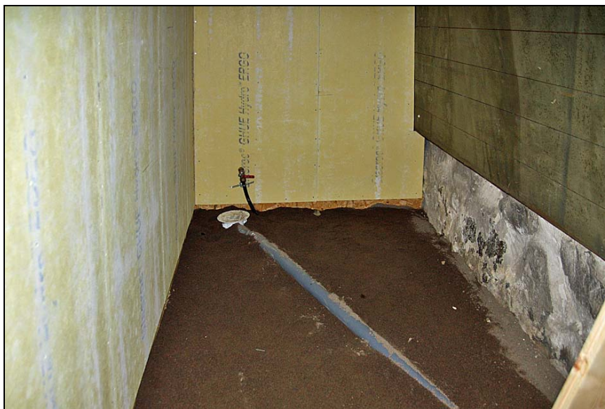
2009-11-17. Det östra biutrymmet i södra korsarmen under uppförande. Utrymmet är försett med en golvbrunn med avloppsrör.
