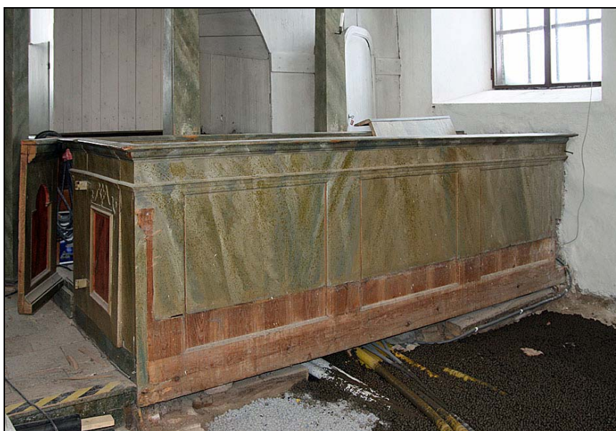
2010-03-02. Fronten till norra bänkkvarteret under läktaren efter demontering av framförliggande bänkar och plankgolv.
