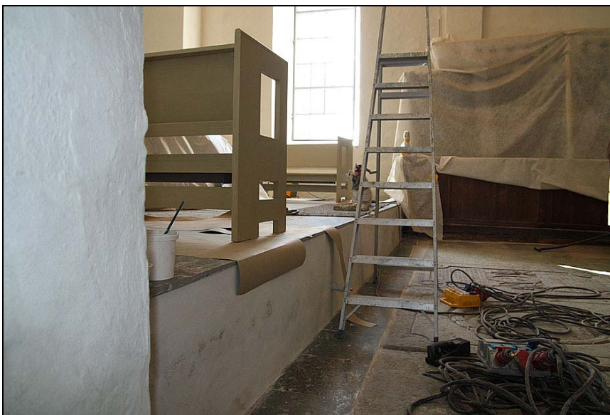
2010-04-13. Trappstegen i tegel har och rivits och murats på. Kalkstensgolvet nedanför och ovanför avsatsen har kompletterats med nya kalkstensplattor.
