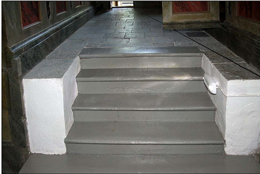
2010-06-03. Trappan mellan den övre och undre delen av södra korsarmen har målats och nödbelysning har monterats på muren vid sidan av trappstegen.
