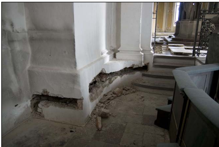
2010-09-14 (JD). Kanaler för det gamla värmesystemet gick bl.a. genom pelarnas baser.
