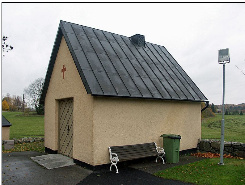
2008-10-20. Bårhusets östra takfall efter grund- och mellanstrykning. Slutstrykning återstår.
