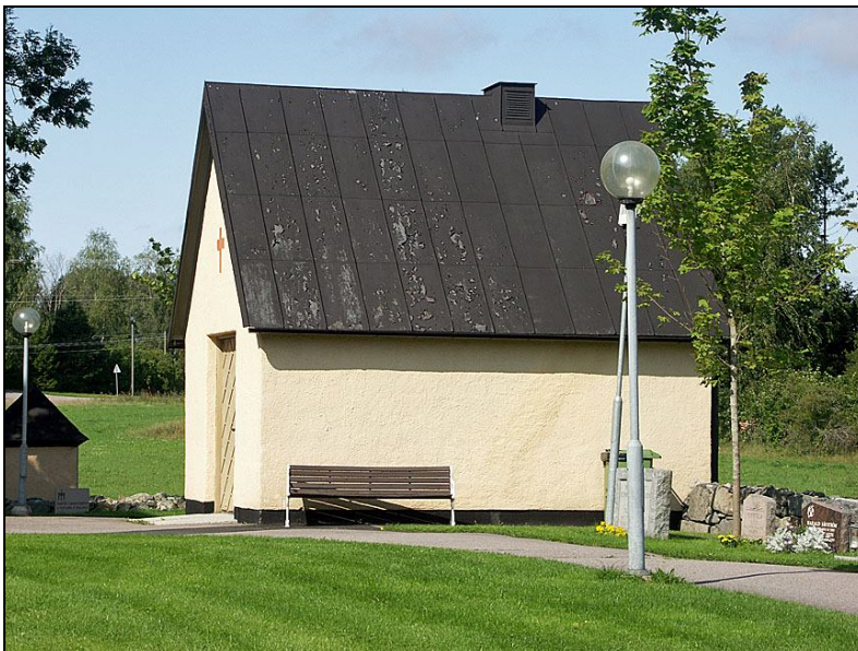
2008-08-19. Bårhuset innan ommålning av tak.
