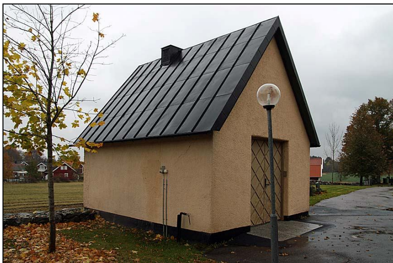
2010-10-19. Bårhusets västra takfall efter ommålning.
