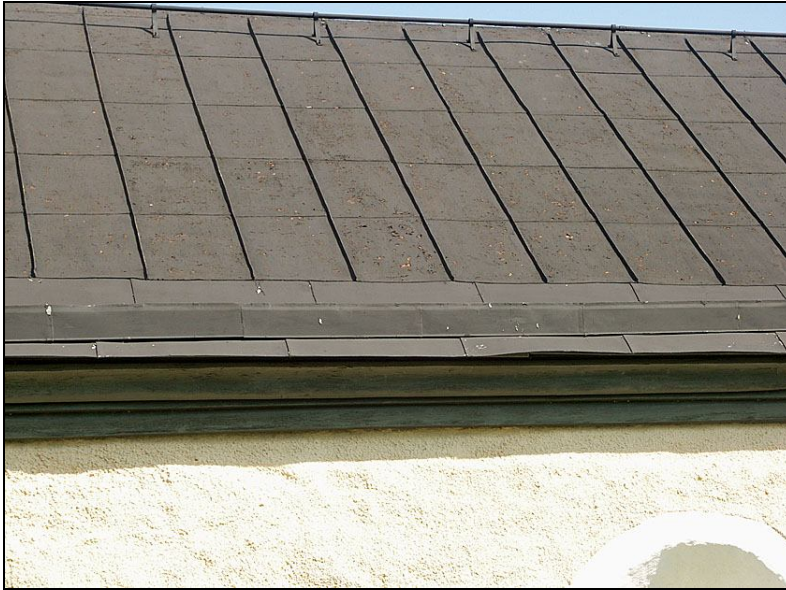
2008-08-19. Långhusets plåttak innan ommålning. De nyare plåtarna vid takfoten framträder i kontrast mot den äldre svart-plåten.
