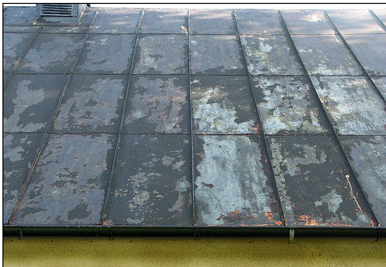
2008-09-24. Rengjort plåttak på bårhuset.
