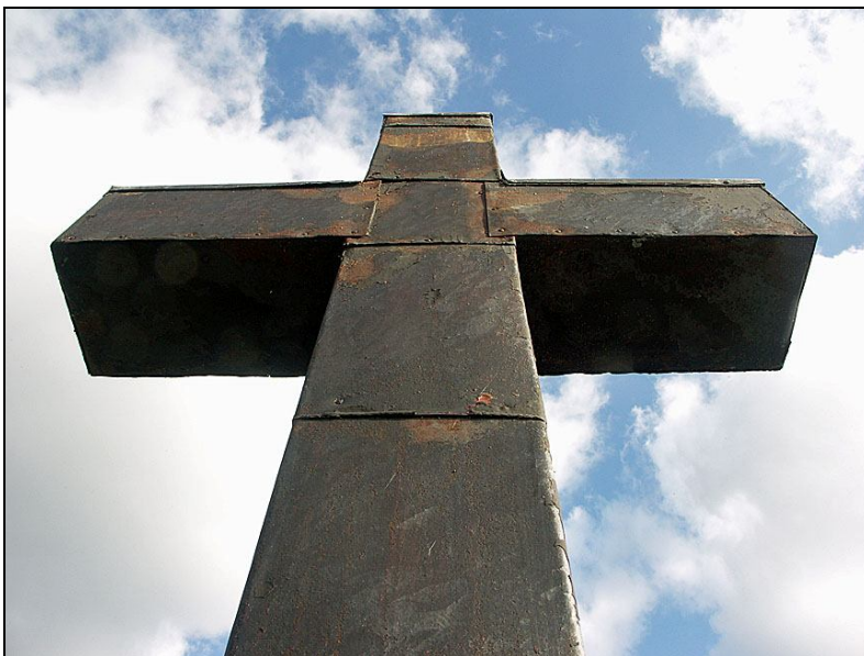
2008-09-24. Krönkorsets plåtbeklädnad är spikad mot stommen. Korsets rosthåll lappades för att slippa byta ut den gamla beklädnaden.
