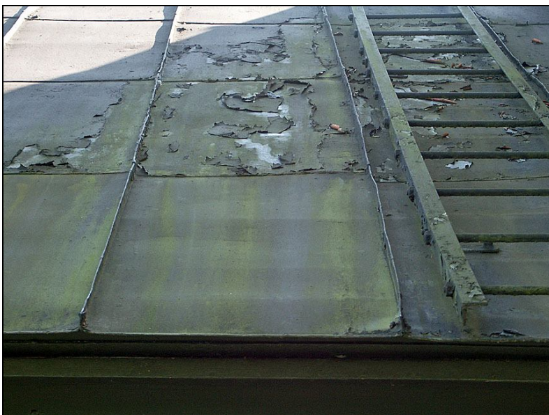
2008-08-19. Galvaniserat plåttak på bårhusets västra takfall
