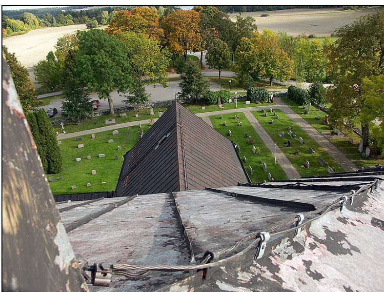
2008-09-24. Torntaket och långhusets galvaniserade tak innan ommålning.
