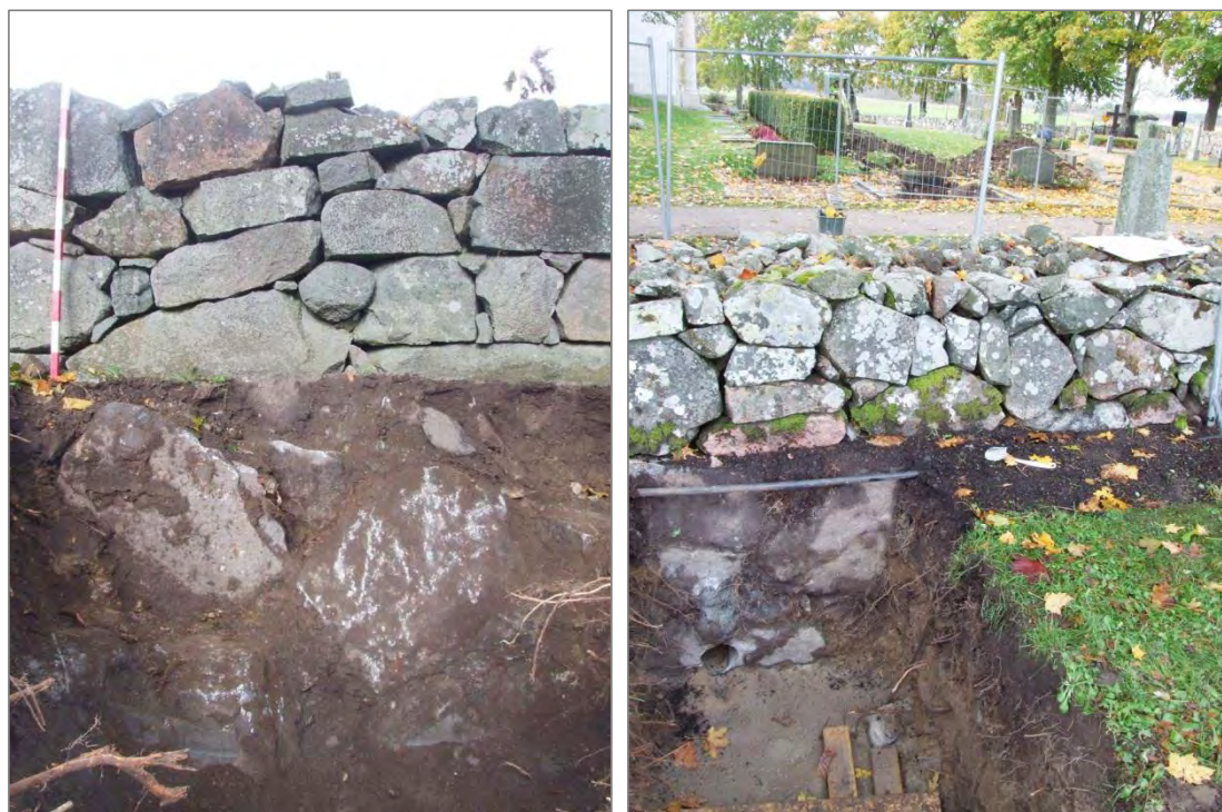
Figur 26 T.v. Närbild av den varmmurade äldre bogårdsmuren under nuvarande kyrkogårdsmur. Foto mot N.
