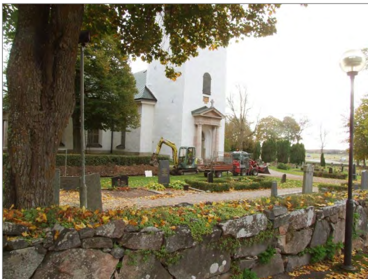
Figur 9. Schaktningsarbeten vid schakt 2, etapp 1. Foto mot SO.
