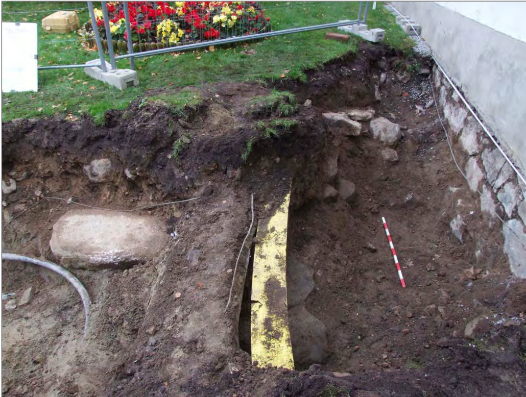
Figur 14. Översikt av schakt 1. I mitten av bilden framgår ett 1 m brett parti av olika ledningar som ligger över det medeltida vapenshusets tröskelsten. Foto mot N.
