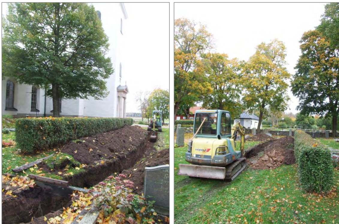
Figur 21 T.h. Översikt av schakt 2 mot S, vid gravplats 421.
