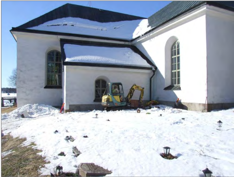
Figur 29. Grävning för bergvärme vid sakristian. Foto mot S.
