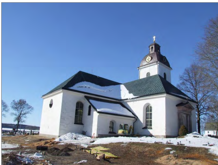
Figur 10. Schaktning för bergvärme vid Alunda kyrka april 2013. Foto mot SV.
