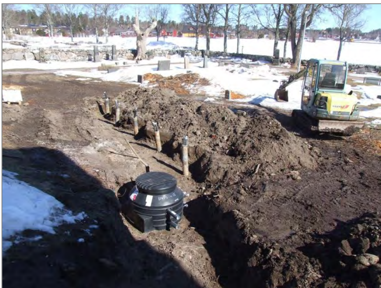
Figur 30. Schakt med bergvärmeborrhål och pump. Foto mot NÖ.
