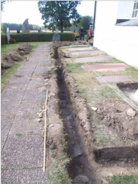
Figur 16. Mur A1 och A2, vilka troligen utgör grundmur till kyrkans medeltida vapenhus. Foto mot V.
