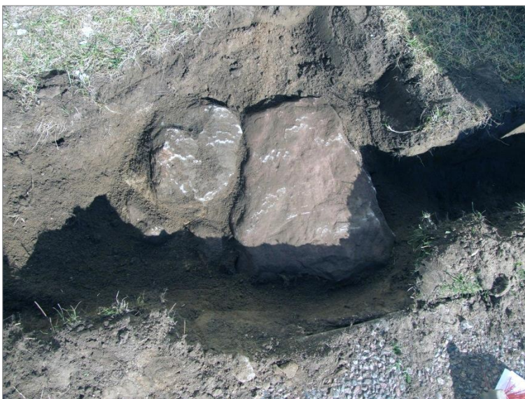
Figur 13. Löst liggande sten ovanpå grundmur A2 som borttogs vid schaktningen.
