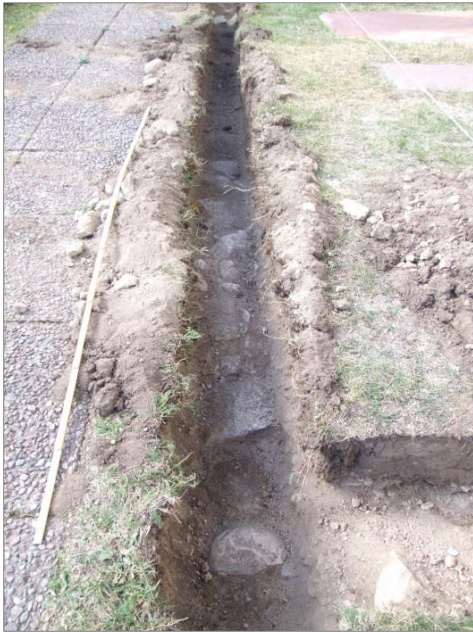
Figur 12. A1, rest efter grundmur. Foto mot V.
