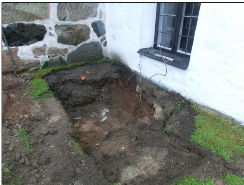
Figur 7. Gropen vid sakristians östra vägg. Under kyrkans norra vägg kragar grundstenarna ut ca 0,5 meter. Foto från nordost, 2014-06-19.
