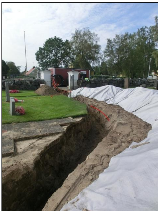
Figur 14. Schaktet fram mot ingången. I kröken fanns ett sotlager innehållande en del slagg (här förstärkt med en röd linje). Foto från nordost, 2014-08-14.
