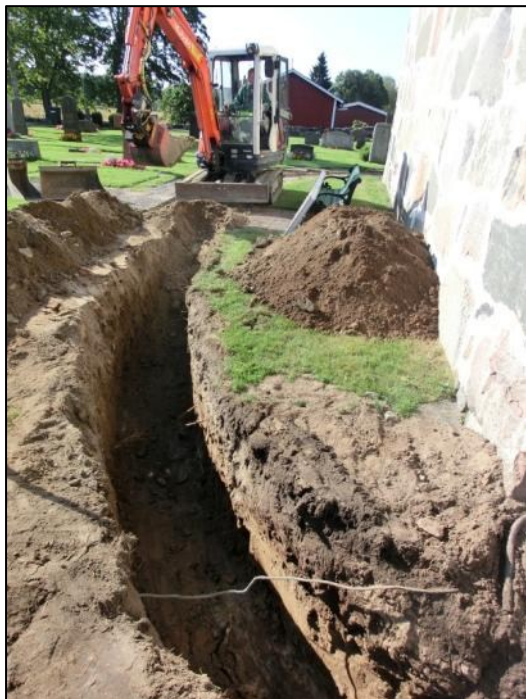
Figur 10. Foto av schaktet parallellt med kyrkans östra vägg. I partiet där gräsmattan börjar blev det djupare ner till ren mjäla. Foto från norr, 2014-08-13.
