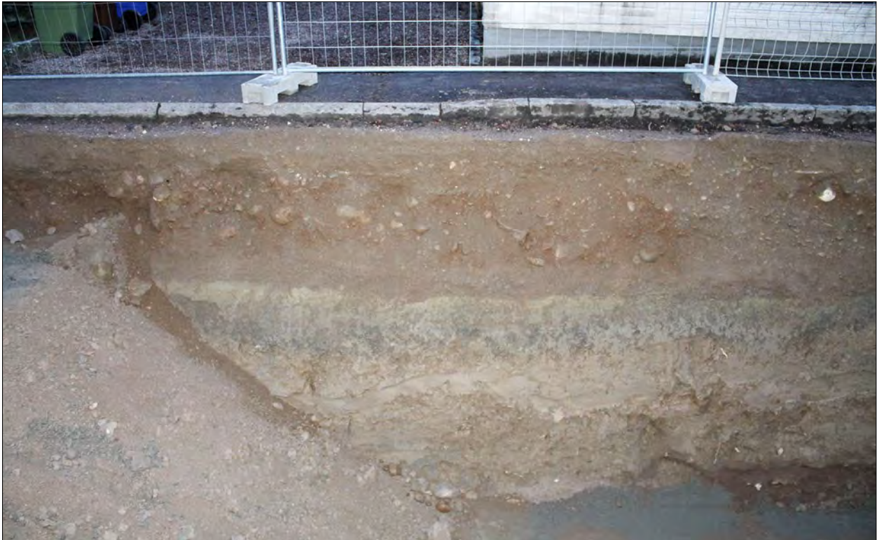
Figur 56. Östra schaktväggen i Sigyns väg. Naturliga och påförda lager i schaktväggarna. Foto från öster: Jonas Wikborg, SAU.
