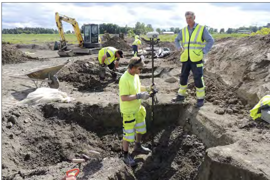
Figur 24. Undersökning av stolpfundament. Arbetsbild med Hans Göthberg, Andreas Hennius, Fredrik Thölin, Elin Säll och Robin Lucas. Foto från norr: Malin Lucas, Upplandsmuseet.
