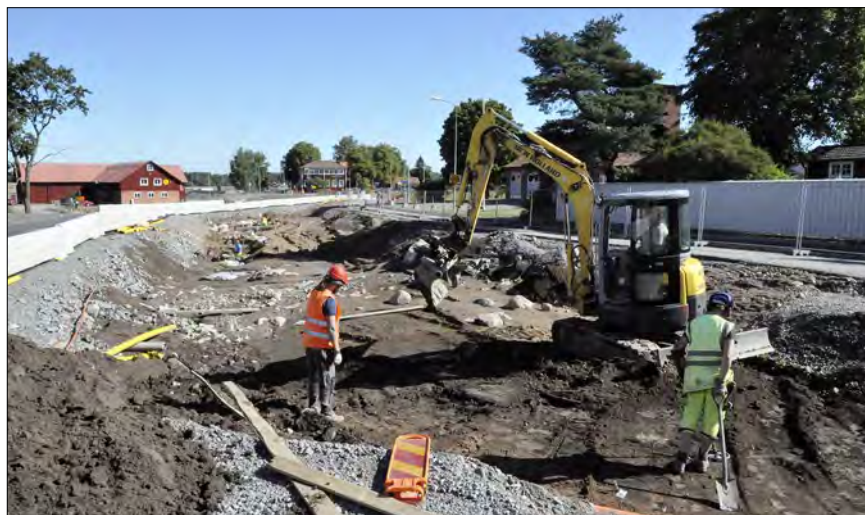
Figur 36. Schaktning och metall-detektering pågår vid delområdets södra delar, detaljyta 13S. Observera tjockleken på de påförda massorna. Foto från sydsydväst: Jonas Wikborg, SAU.
