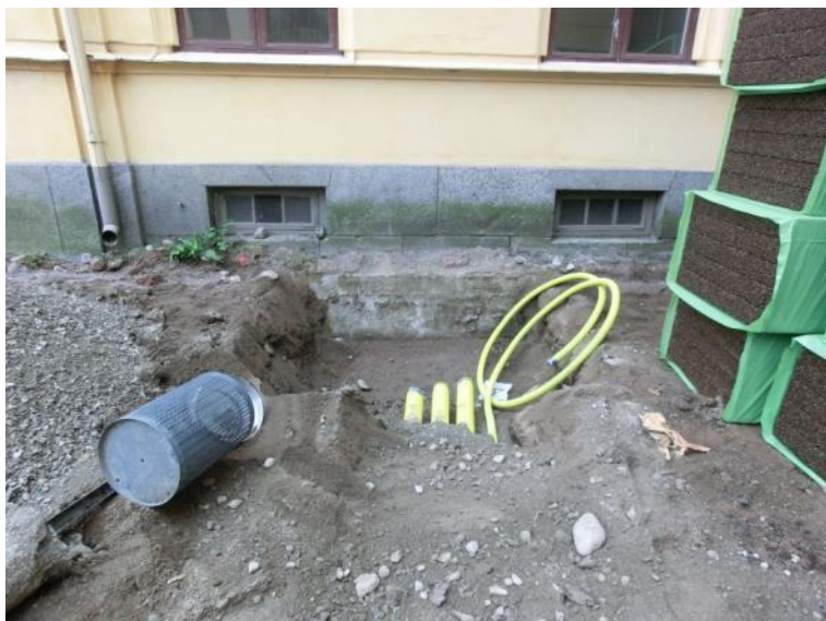
Figur 7. Schakt för ledningar och tomrör vid område B. Foto mot sydost, 2014-09-11.
