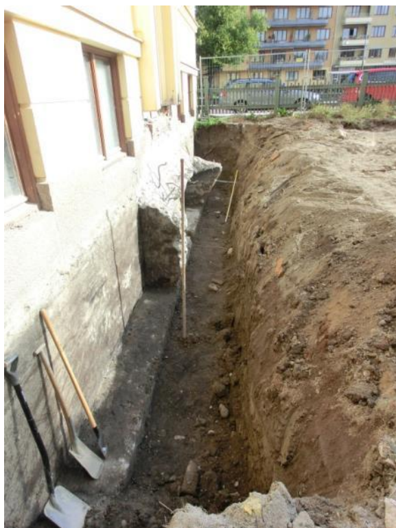
Figur 6. Foto av schaktet på sydöstra sidan av hus 2. Foto mot nordost 2014-09-02.
