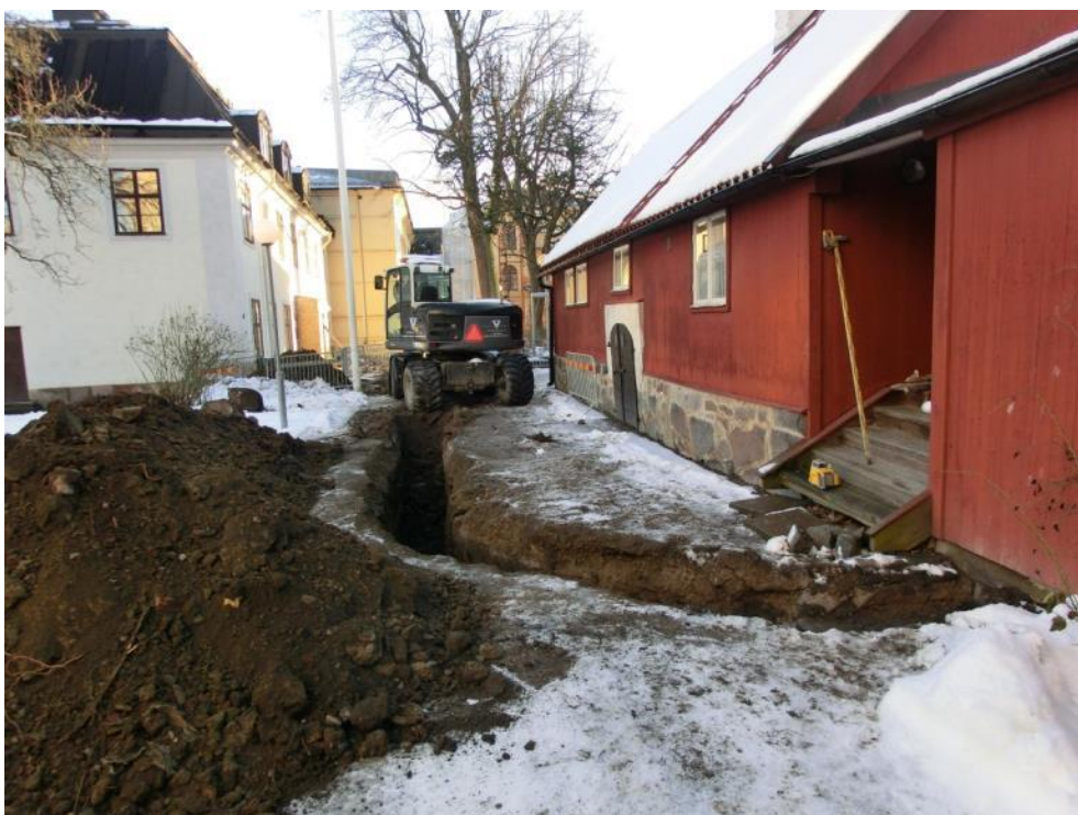
Figur 19. Schaktet för vattenledningen utgående från hus 3. Foto mot sydost, 2015-01-27.
