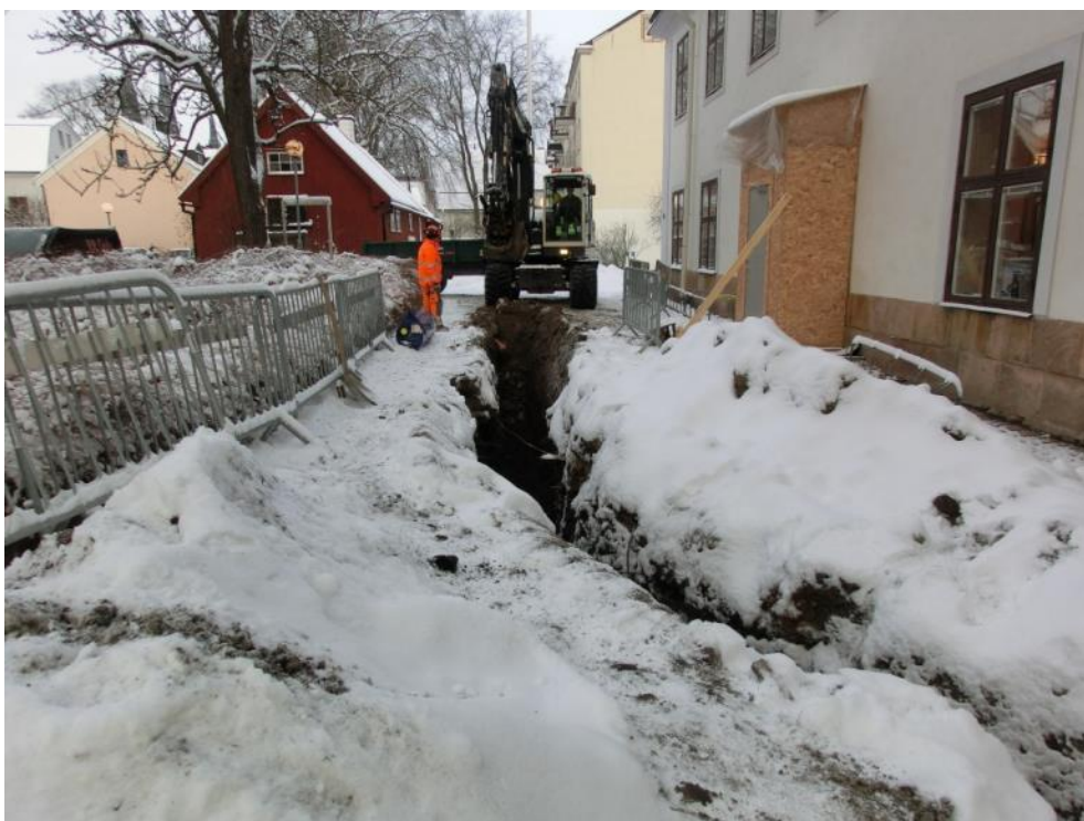
Figur 20. Schaktet för vattenledningen från hus 5. Foto mot nordväst, 2015-01-23.
