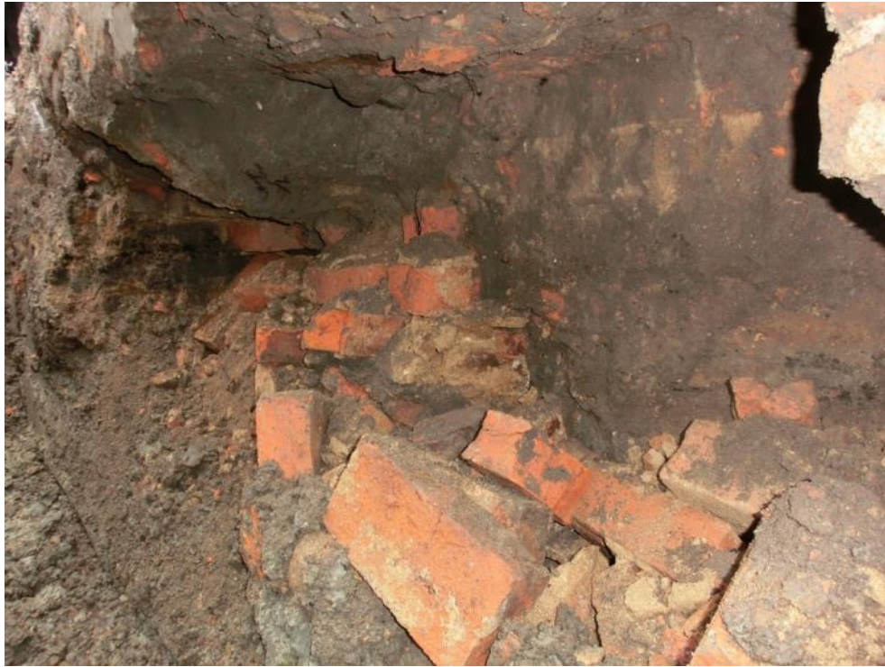
Figur 21. Raserat tegel med en bevarad mur i bakkanten i schaktets södra sida. Foto mot söder, 2015-01-28.
