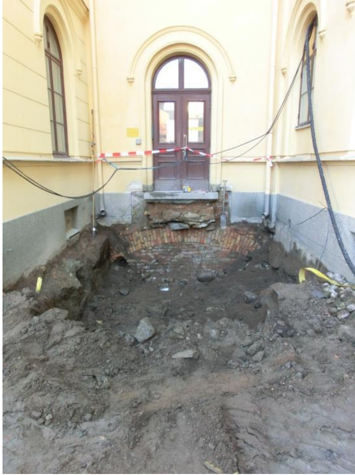
Figur 25. Schakt vid område J inför anläggande av ramp. Under trapphuset mellan de två byggnaderna finns ett fint slaget källarvalv. Foto mot nordost, 2015-02-24.
