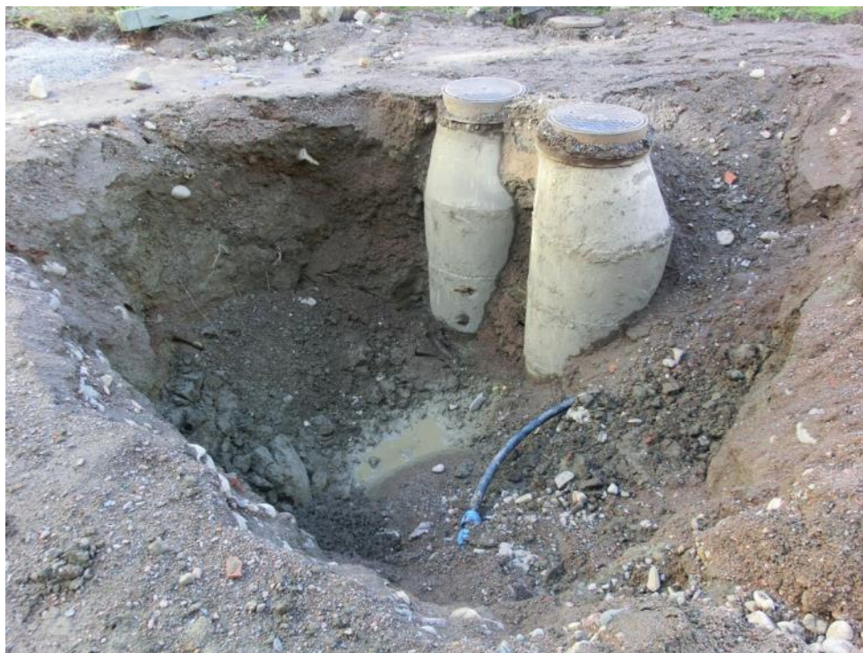
Figur 15. Område G med upptaget schakt runt två brunnar. Foto mot norr, 2014-09-23.
