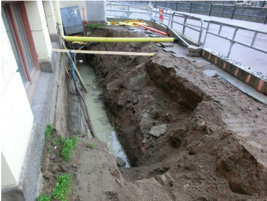
Figur 16. Schakt för dränering utanför hus 2 har påbörjats. Foto mot nordväst, 2014-10-09.
