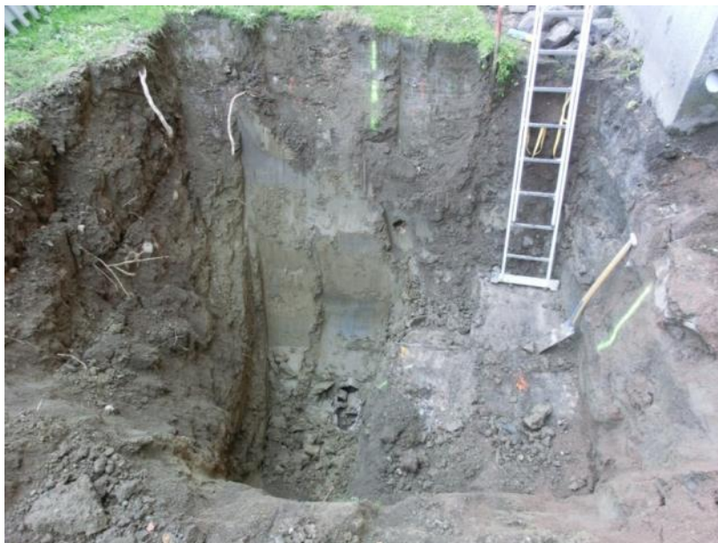
Figur 9. Grop vid område C med cementrör i botten utanför betongsulan. Foto mot sydost, 2014-09-11.
