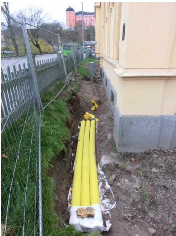
Figur 11. Schakt intill södra fasaden på hus 1a, med Mungatan till vänster i bild. Foto mot sydväst, 2014-10-28.
