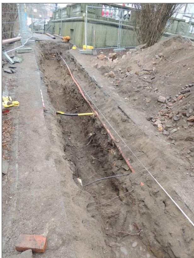
Figur 18. Schaktet efter avslutad arkeologisk undersökning. Foto mot S, Anna Ölund, Upplandsmuseet.
