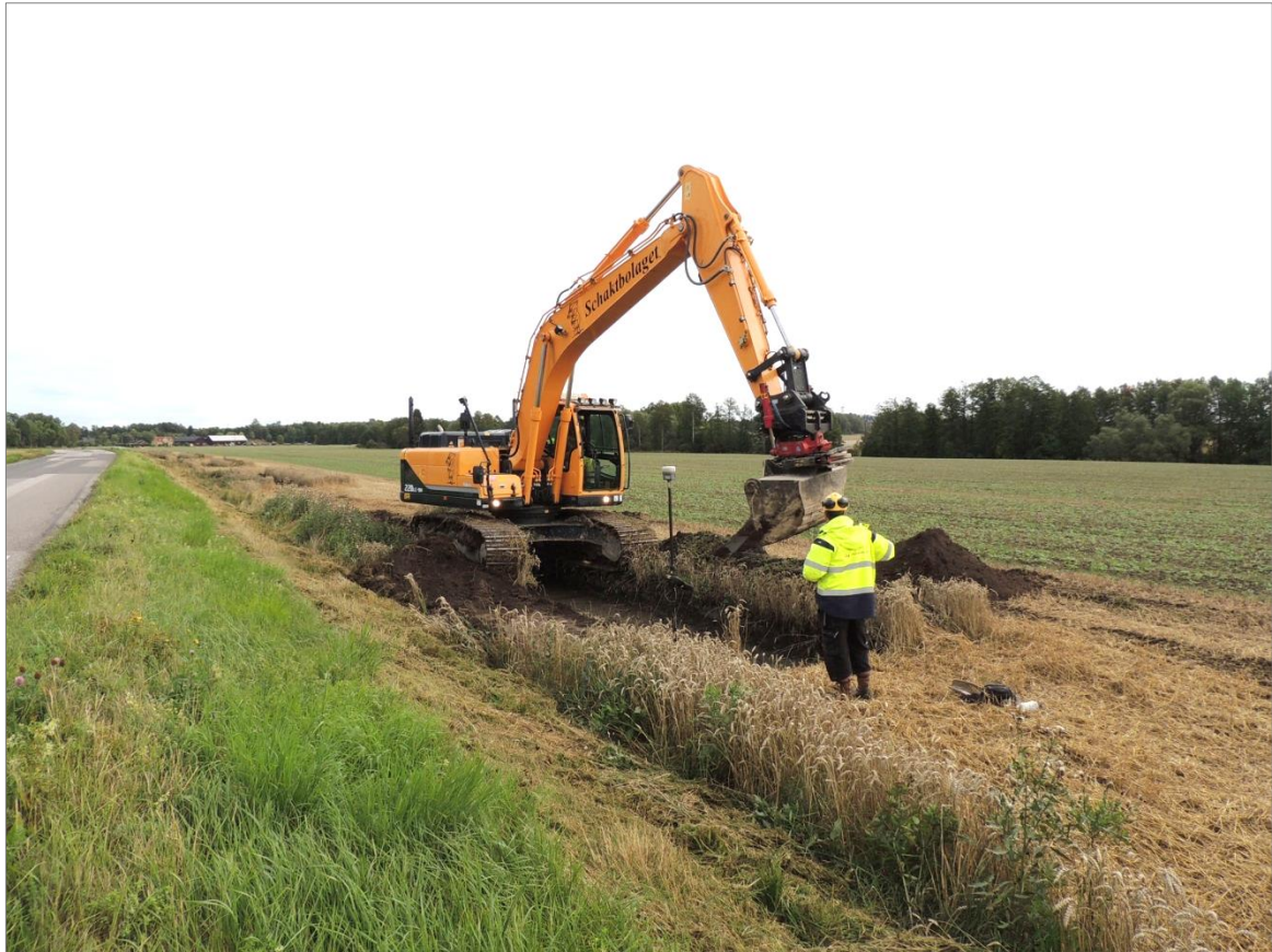
Figur 14. Boplatsen Lokal 5 låg omedelbart öster om vägen mellan Skuttunge kyrka och Häggeby. Boplatsen låg i stora delar av sträckningen markant lägre än både vägen och åkermarken väster om vägen. Detta avspeglar en äldre situation eftersom vägen låg vid gränsen mellan åkermark och äng. Mot norr.
