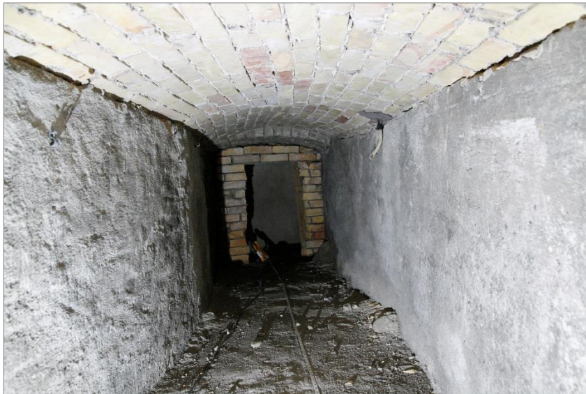
Figur 18. Gång A4 sedd mot sakristian och den nu upptagna igensättningen. Stötfogen i valvtaket ligger vid ingången från koret till sakristian. Foto mot N, Ulrika Sahlsten, Upplandsmuseet.
