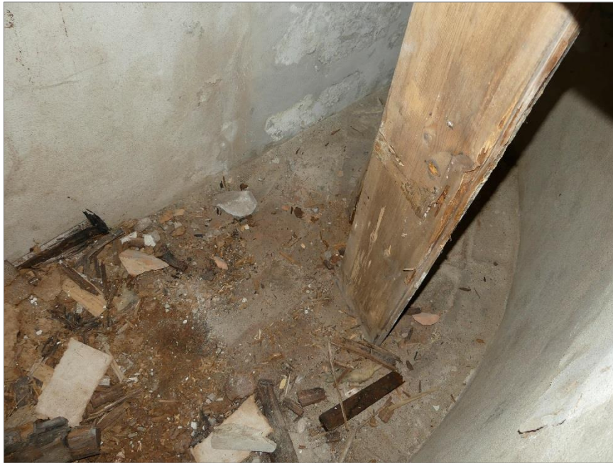
Figur 15. Källare A3 mot S.
