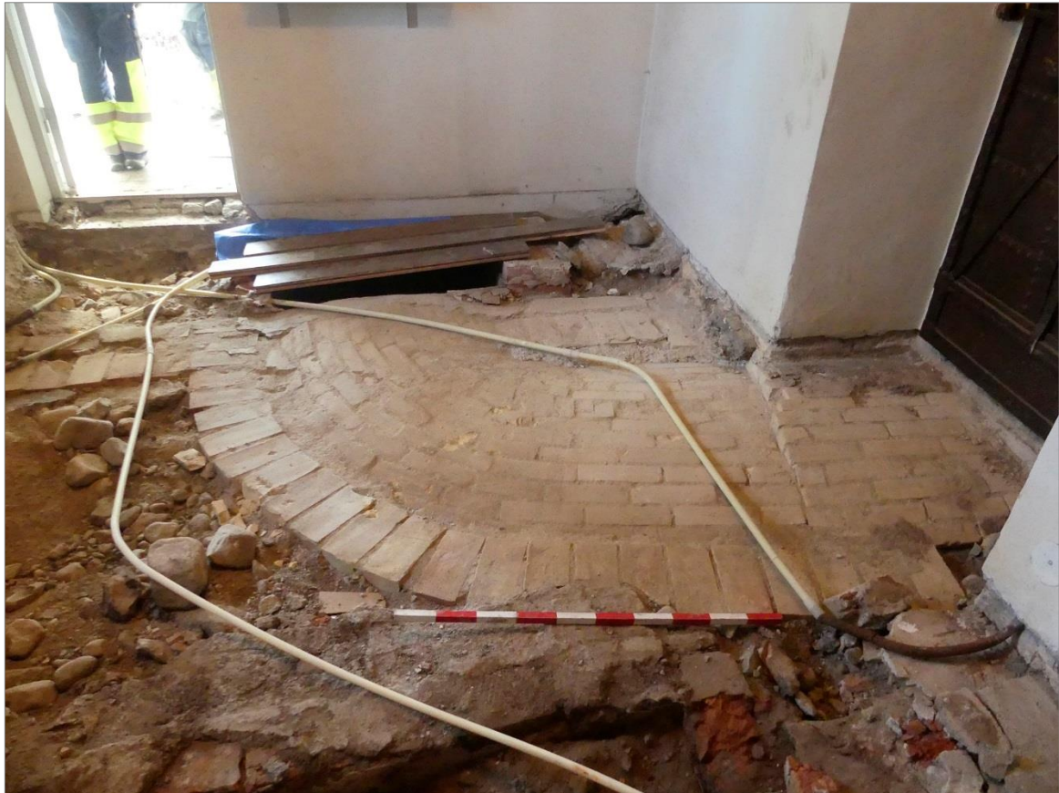
Figur 16. A4. Gång med lågt slaget valv i gultegel i sakristians SÖ-hörn. Källare A3 utgör en del av utrymmet under valvet och nedgången till källaren ses under brädorna i bildens överkant. Observera även stötfogen i valvet i höjd med ingången till koret. Foto mot Ö.
