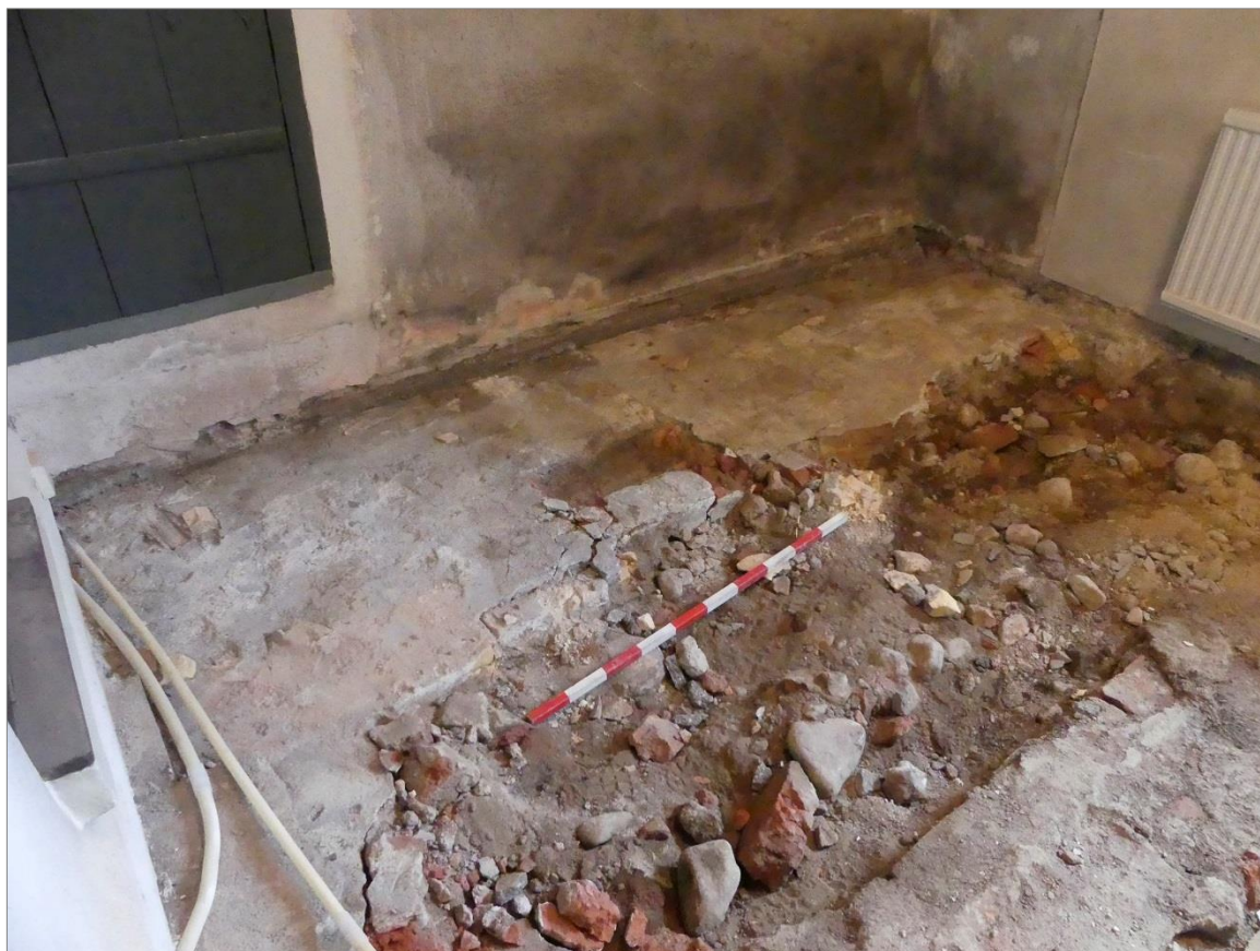
Figur 12. A1 – Golv. Del av äldre golv i sakristian som utgjordes av ett kalkbruksstruket tegelgolv. Foto mot NV.
