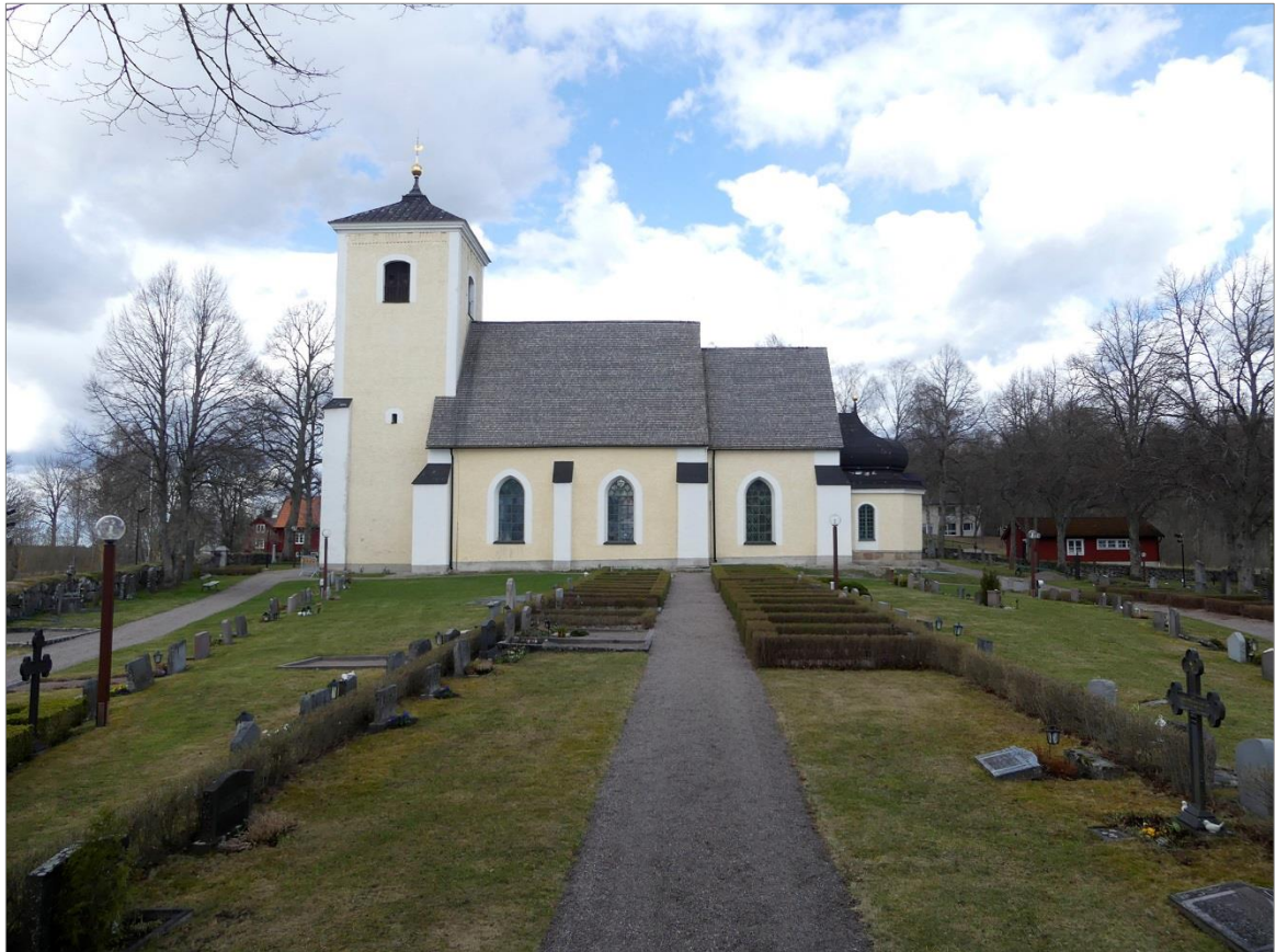
Figur 2. Lena kyrka i april 2018 i samband med renovering av kyrkans sakristia. Foto mot N.
