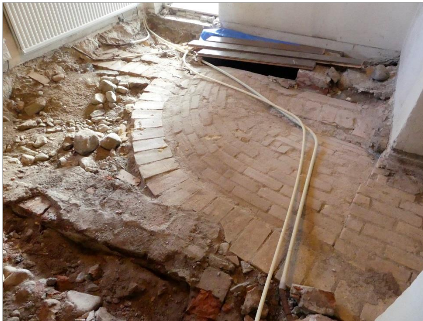
Figur 9. Sakristians östra del där ingången till koret ses i bildens högra kant och utgången till det östra rummet ses i bildens övre del. Foto mot Ö.
