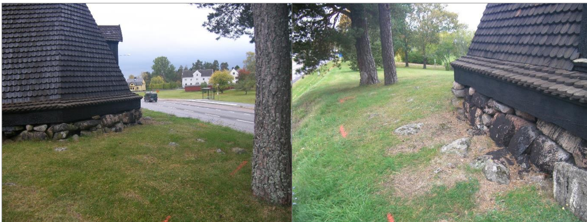
Figur 15 (tv). Hörnet av husgrunden IV (se figur 10), före schaktningarna. Foto från norr. Figur 16 (th). Husgrunden IV (se figur 10), före schaktningarna. Stenarna närmast bild, invid klockstapeln, är inte inritade på plan eftersom de täcktes av schaktmassor vid grävningen längs den branta slänten. Foto från söder.
