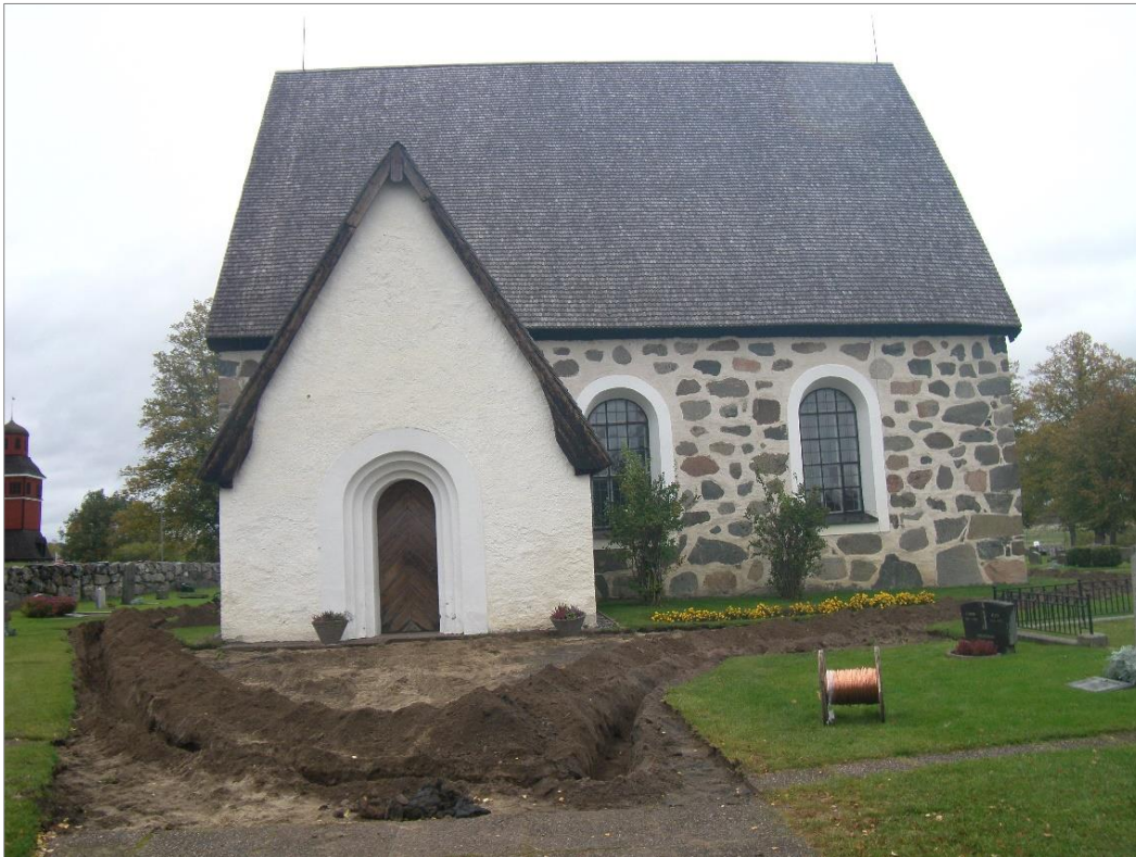
Figur 5. Schaktet söder om vapenhuset, med lämningar efter klockgjutning. Foto från söder.
