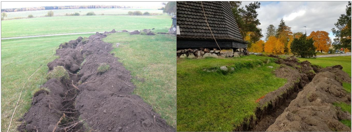
Figur 13 (th). Schakt nedanför terrasskanten III. Foto från öster. Figur 14 (th). Schakt nedanför terrasskanten III. Foto från väster.
