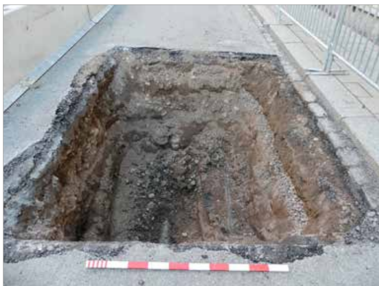
Figur 5. Schakt 2 i Bäverns gränd med fyllnadslager och ledningar. Foto mot Ö, Malin Lucas.
