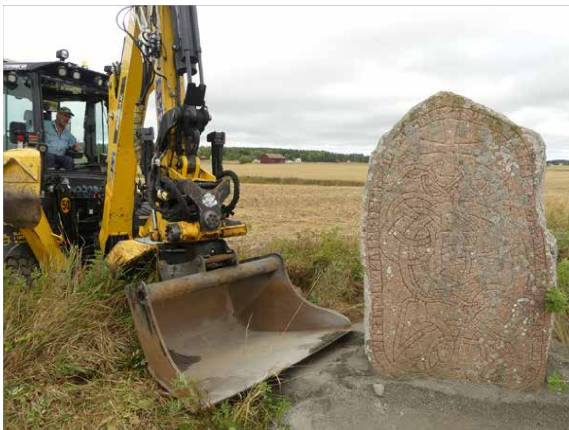
Figur 6. U1176, Huddungeby, Huddunge sn, före och efter åtgärd.
