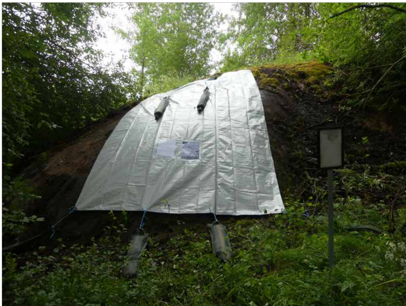
Figur 14. Runhällen U497, Tibble, Husby-Långhundra sn, övertäckt och nedtyngd med sandsäckar fram till april 2021. Foto mot S.
