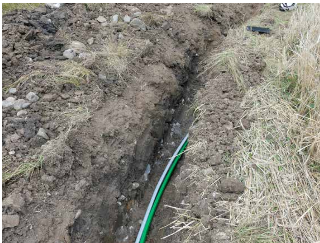
Figur 45. I botten av schakt 1695 fanns den stora nedgrävningen A1725 med en fyllning av stenar i mörk lera. Foto mot norr.
