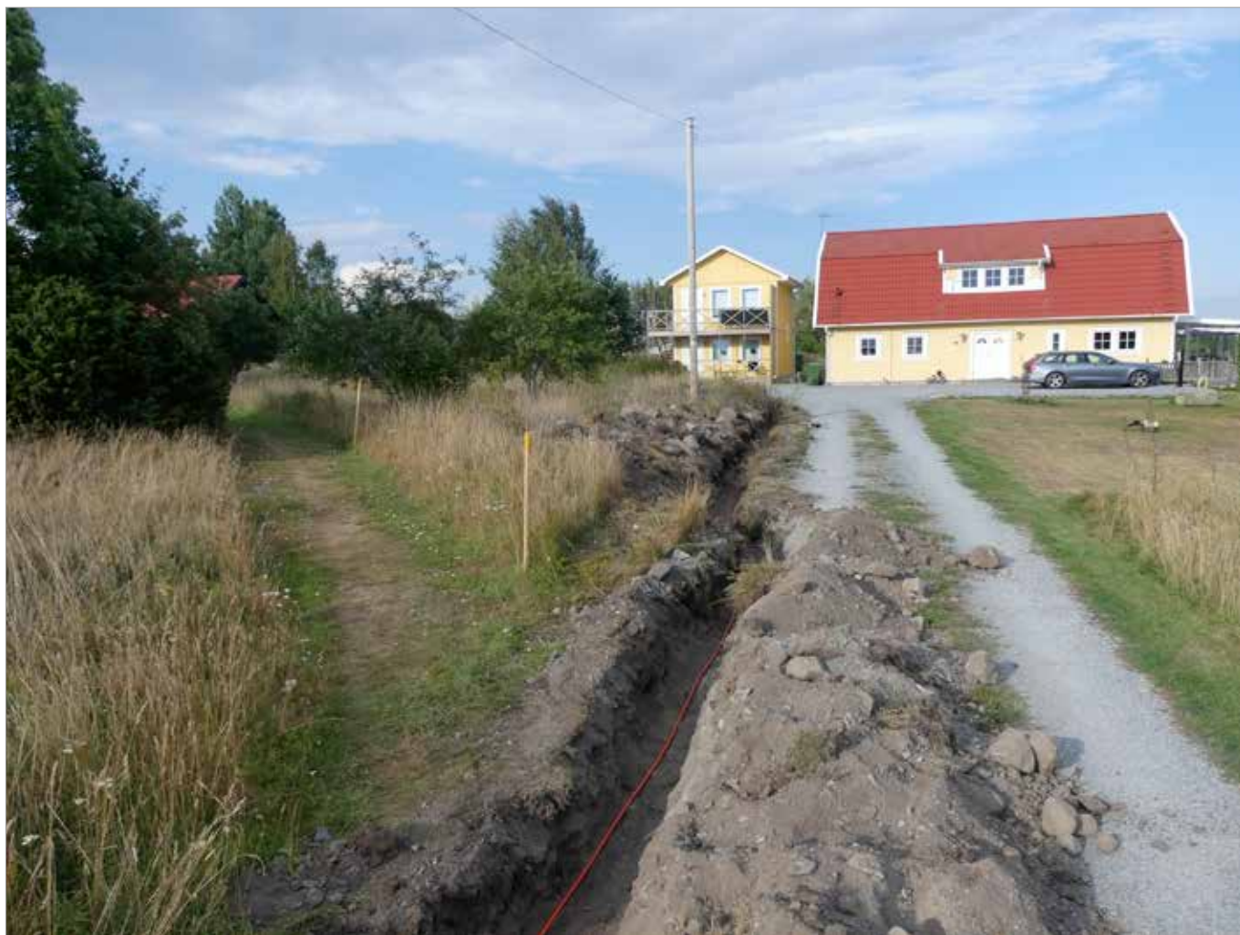
Figur 9. Schakt 1301 grävdes i väggkant. Buskarna i bildens vänstra kant döljer skärvstenshögen L1942:2006. I schaktet nära telefonstolpen fanns nedgrävningen A1333. Foto mot nordöst.
