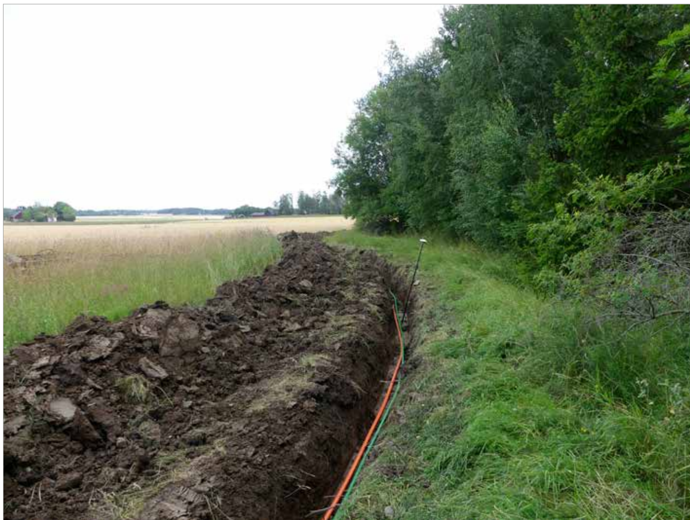
Figur 56. Schakt 941 grävdes i flack mark norr om en moränrygg med de möjliga högarna L1943:7499. Foto mot öster.
