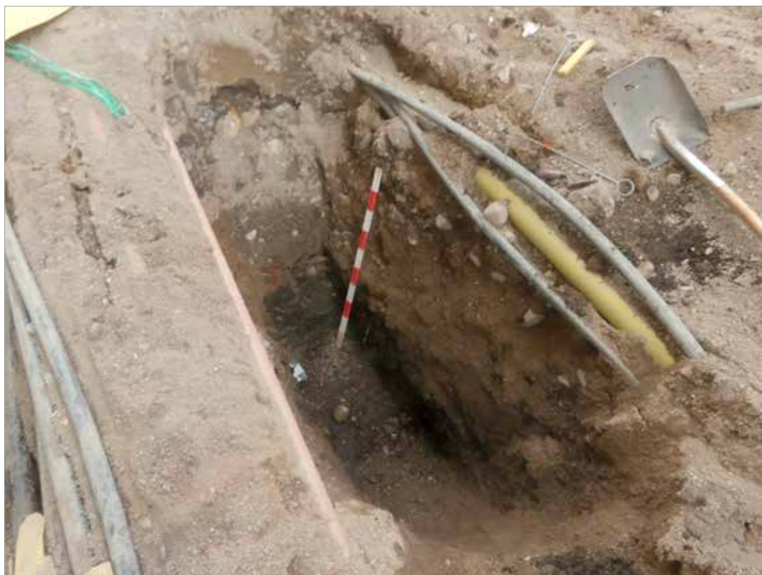
Figur 12. Sektion 1 i schakt A. Foto mot Ö.
