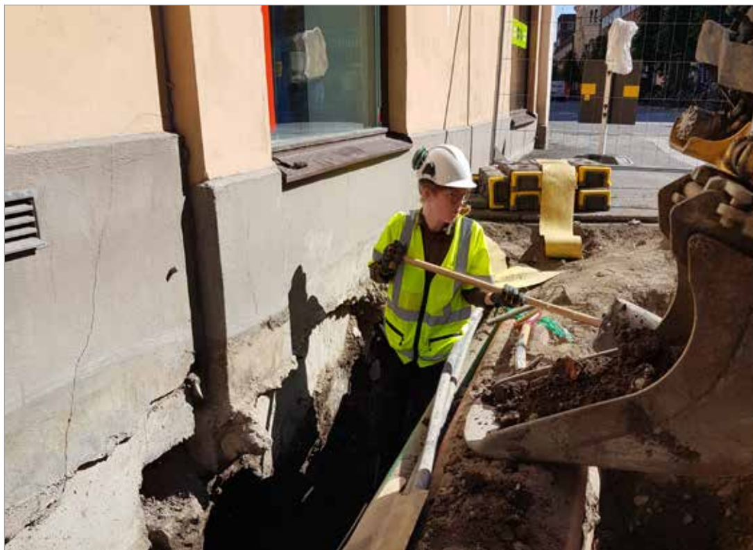
Figur 7. Utrymmet närmast fasaden i schakt A grävdes för hand. Foto mot NÖ, Linda Qviström.
