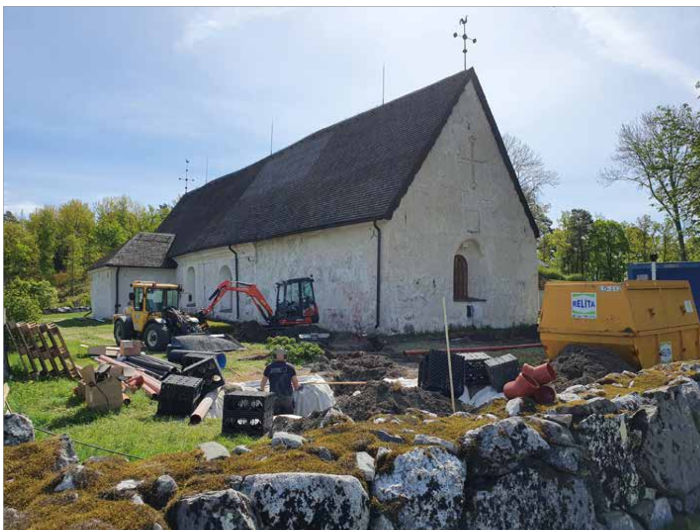
Figur 8. Arbetsbild sedd mot sydost. Foto: Adam Hultberg.
