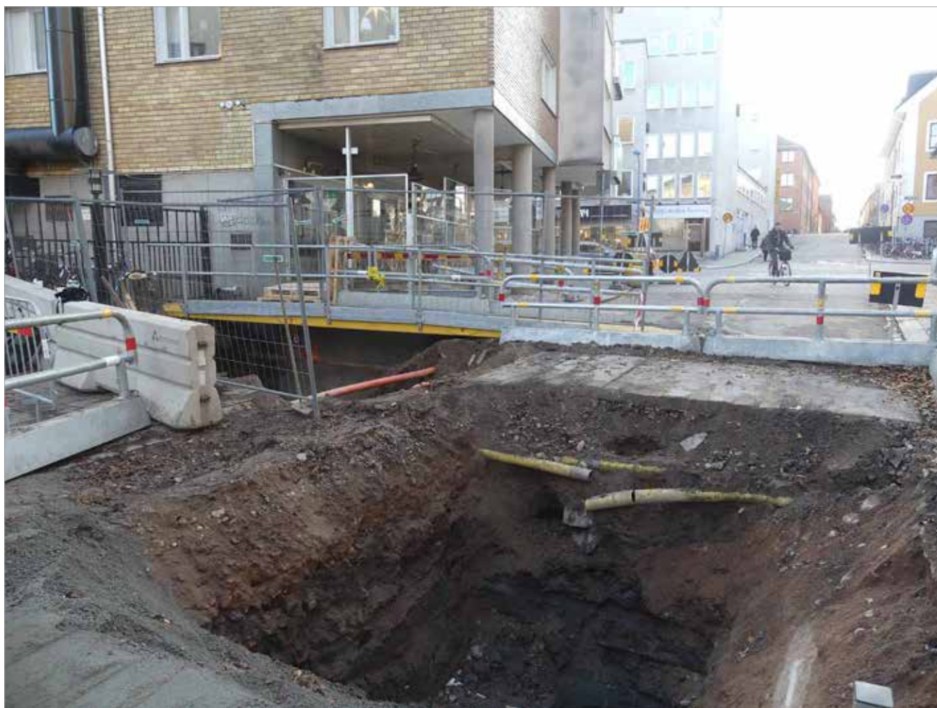
Figur 140. Läget för schaktsträcka 20. I förgrunden syns schaktsträcka 10 och till vänster schaktsträckorna 18–19. Schaktsträcka 20 låg framför och delvis under den tunga avspärrningen. Sträckorna 11–14 har ännu inte grävts. Foto mot V., Malin Lucas, Upplandsmuseet.
