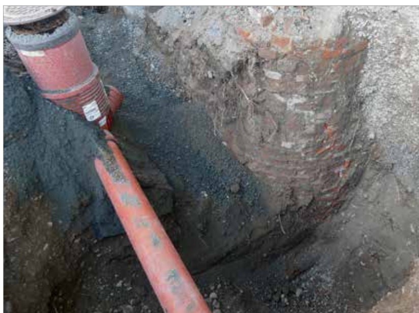
Figur 16. En tegelmurad brunn i schaktsträcka 1 som återanvänts genom att en modern brunn ställts ned i tegelbrunnen. Foto mot N., Malin Lucas, Upplandsmuseet.
