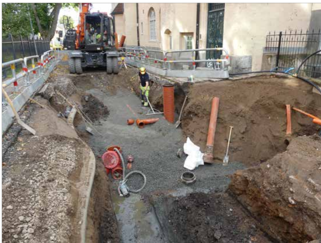
Figur 33. Schaktsträcka 4 med bevarade lager till höger i bild. I fotot syns också servisschaktet, sträcka 15. Foto mot NV, Anna Ölund, Upplandsmuseet.
