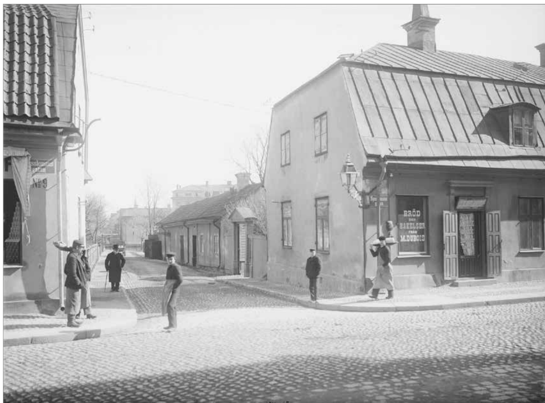
Figur 11. S:t Johannesgatan under tidigt 1900-tal. Till höger i bild syns bostadshuset som byggdes åt sysslomannen 1775–76 och som revs 1964. Foto: Alfred Dahlgren. Upplandsmuseet AD151.
