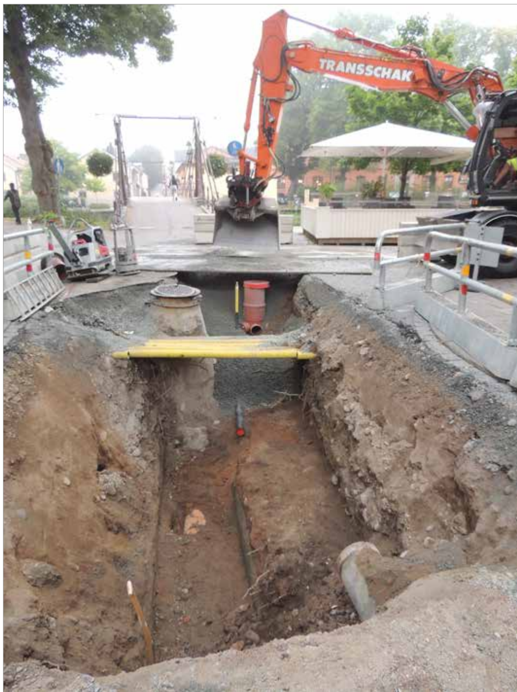
Figur 17. Bevarade lager i schaktsträcka 1 till höger i bild. Järnbron i fonden. Foto mot NO, Malin Lucas, Upplandsmuseet.
