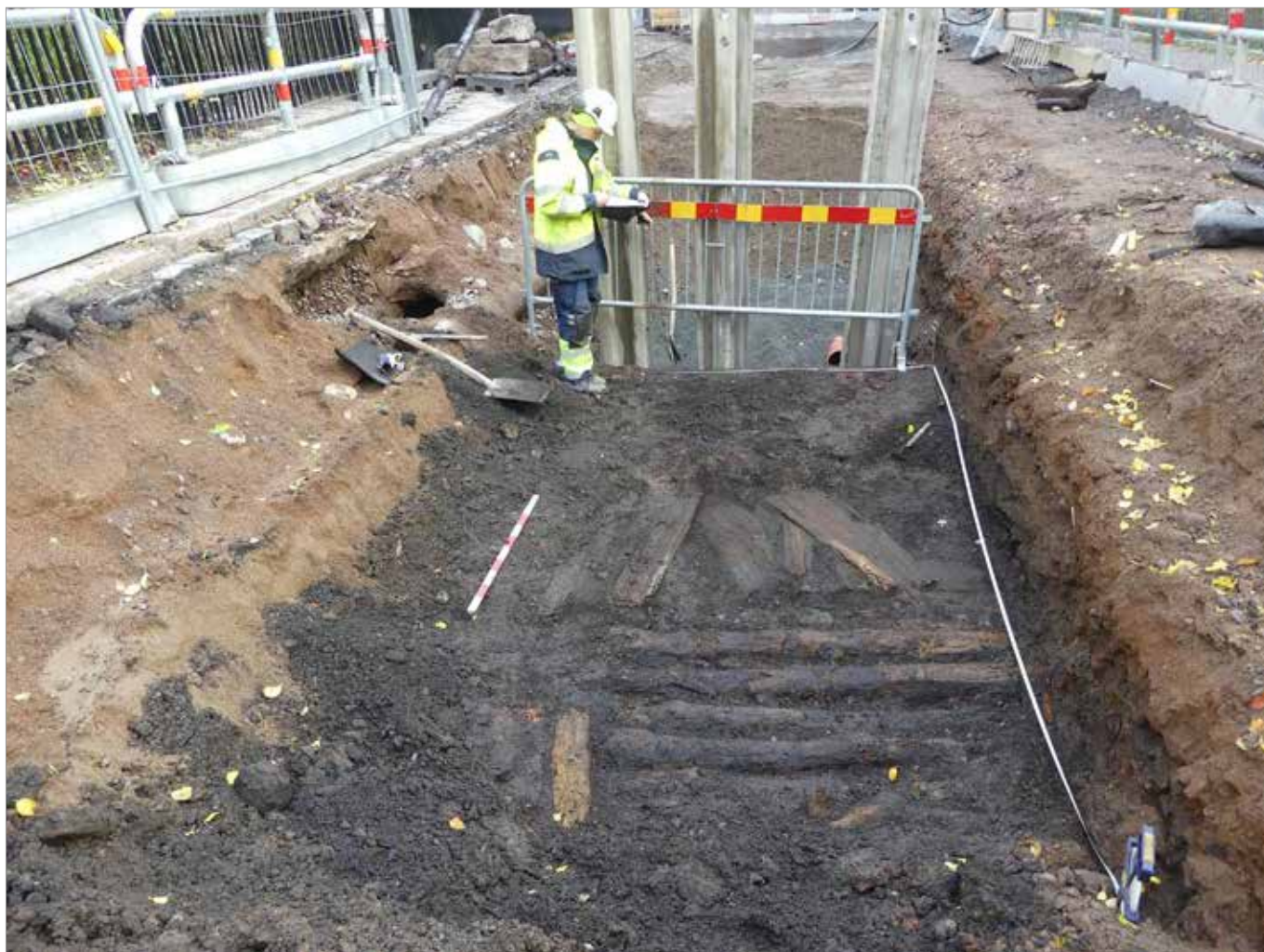
Figur 63. Schaktsträcka 9, Hus 13, golv A86 och möjlig nedrasad vägg, A23. Foto mot Ö., Malin Lucas, Upplandsmuseet.
