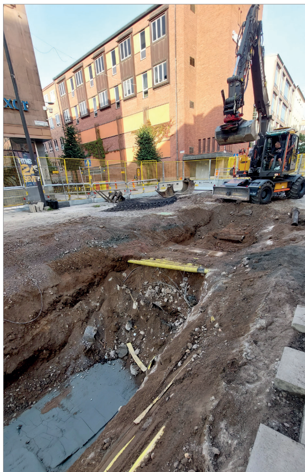
Figur 4. En del av fjärrvärmeschaktet i Dragarbrunnsgatan, strax söder om Bangårdsgatan. Foto mot nordväst, Joakim Kjellberg, Upplandsmuseet.
