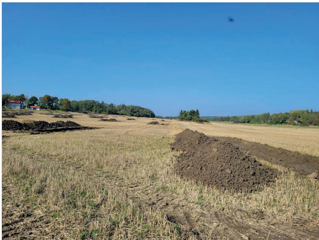
Figur 4. Projektområdet består av åkermark som till stor del ligger i en sluttning. Här med grävda schakt. Foto mot norr. Malin Lucas, Upplandsmuseet.
