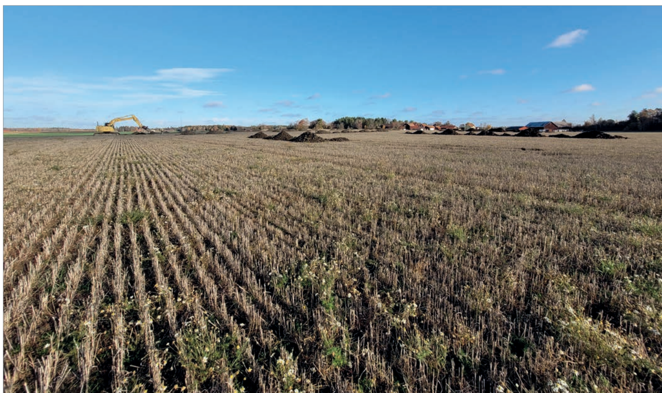
Figur 20. Schaktning inom område 3B. I fonden syns till höger Järstenas bebyggelse. Foto från söder: Per Frölund.
