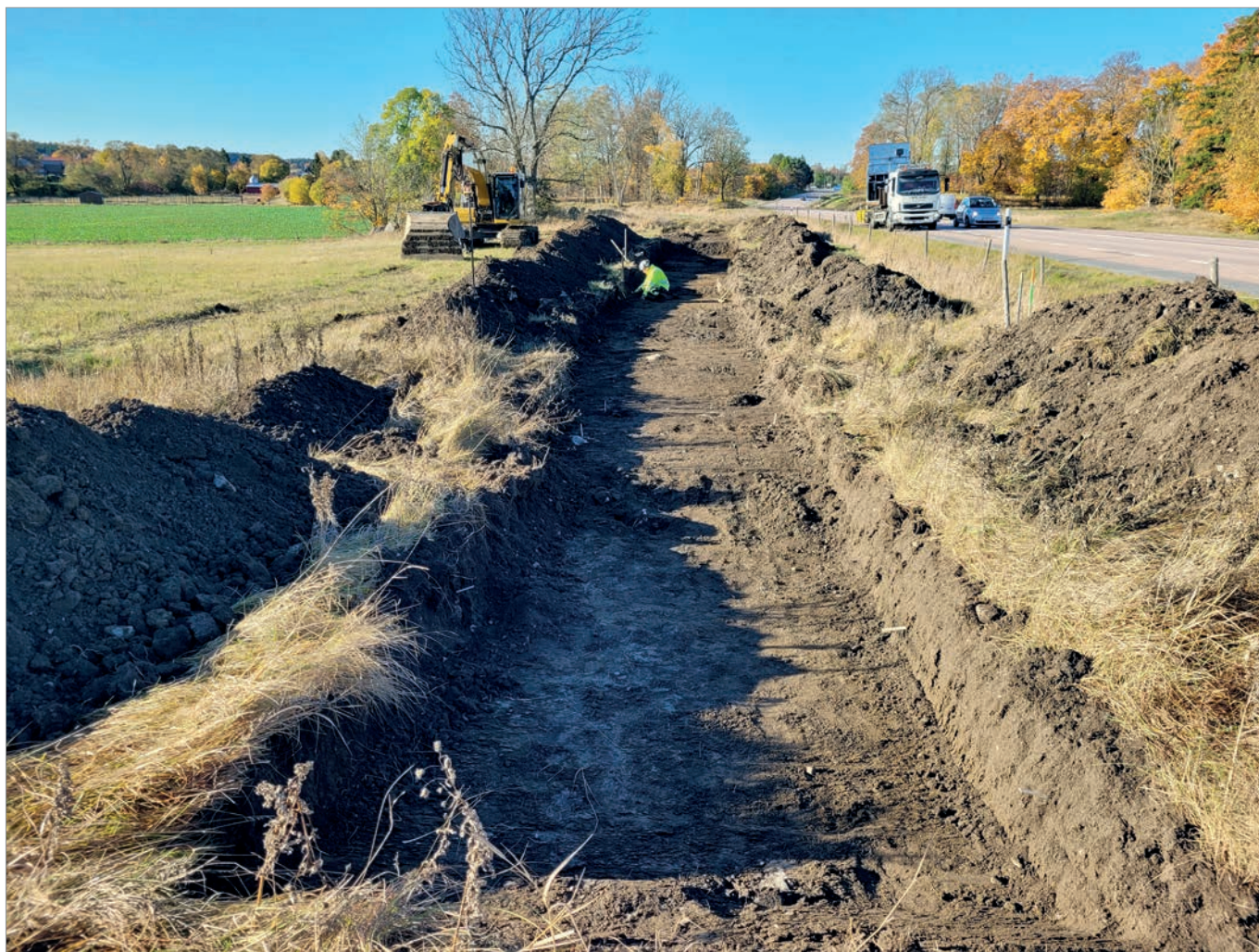
Figur 16. På en avsats vid Kvarnbacken innehöll schaktet lämningar som tillhörde boplatsoområdet L2020:10960. Foto mot väster, Robin Lucas, Stiftelsen Upplandsmuseet.
