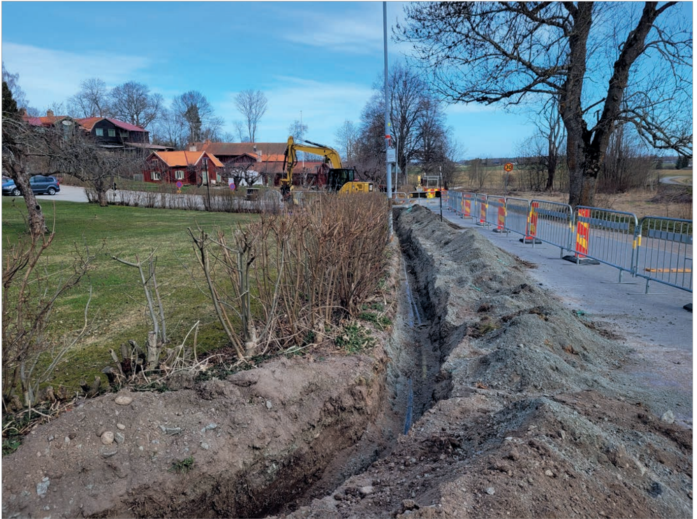
Figur 1. Grävt schakt före igenläggning utmed Ärnäsvägen. Foto från öster: Per Frölund, Stiftelsen Upplandsmuseet.
