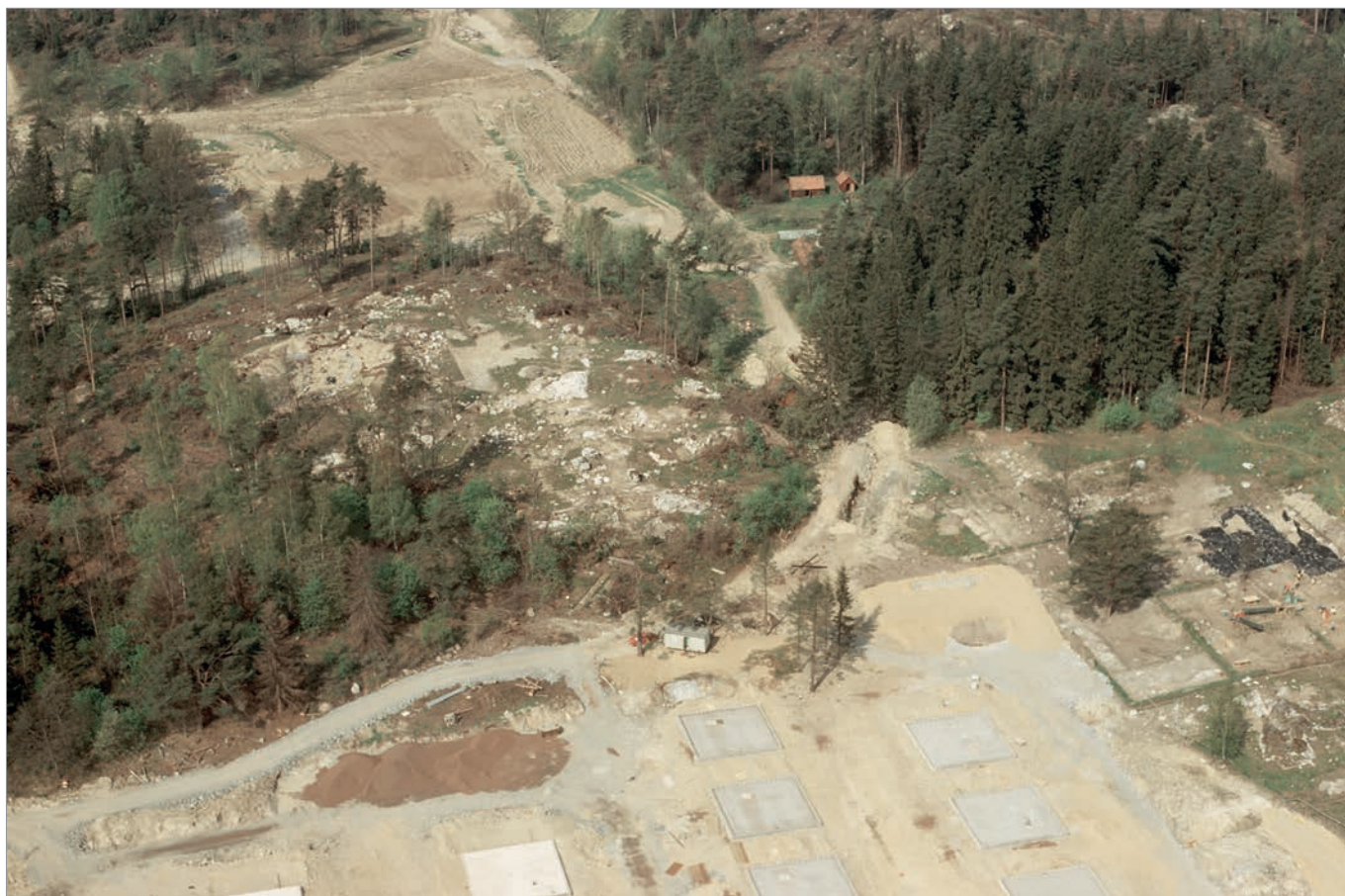
Figur 5. Flygfoto över Botkyrka 13:1 centralt i bilden, vid vägen i skogsbrynet syns torpet Lugnet. Nedtill i bildens vänstra hörn syns delar av Botkyrka 69:1. I bildens förgrund ligger husplattor för husen på Bronsgjutarvägen. Foto från ostsydost av Björn Ambrosiani 1971-05-18. Bild Riksantikvarieämbetet KMB_16001000541926_BAI710518_015. CC BY.
