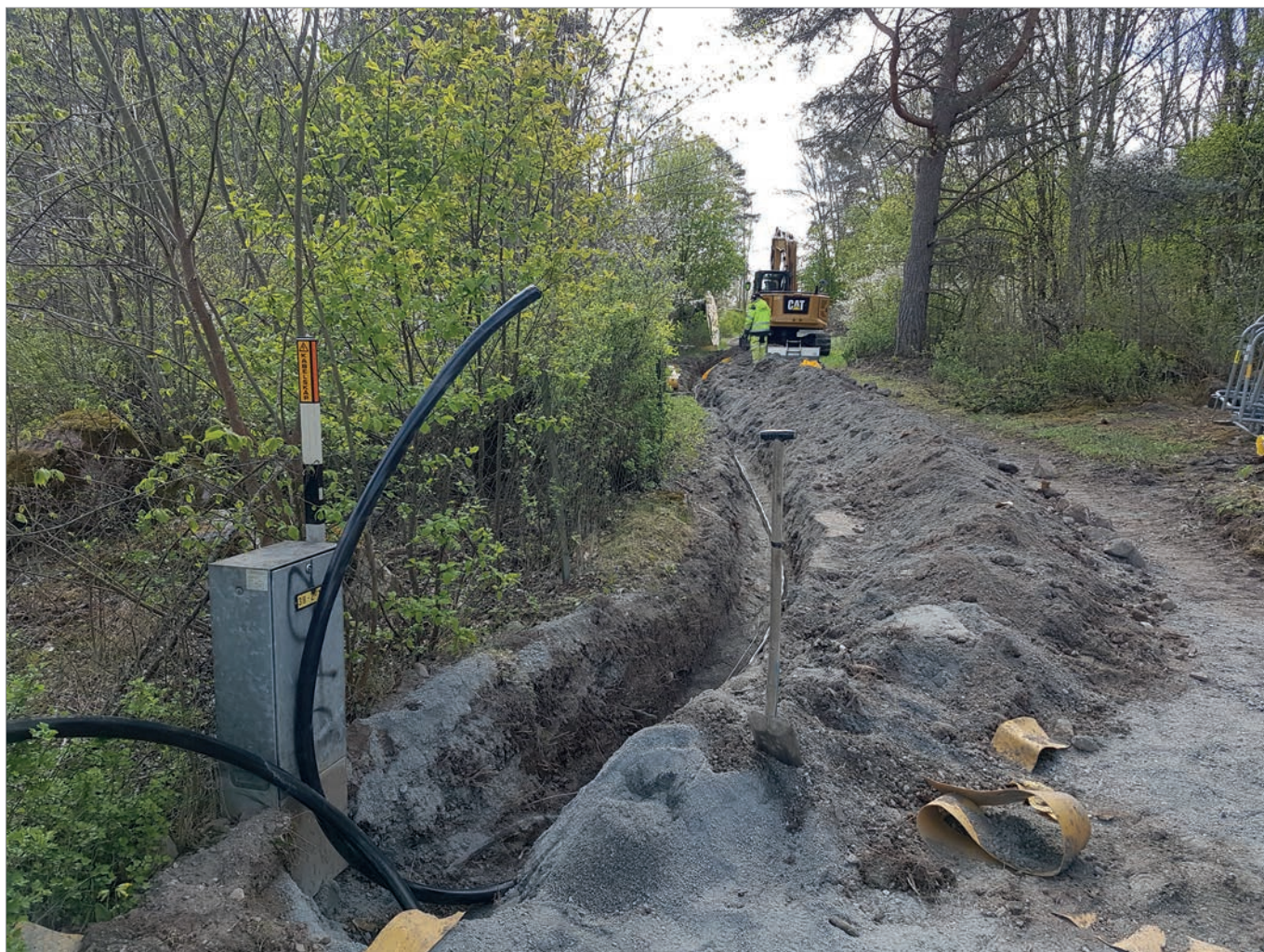
Figur 5. Schakt 2 grävdes i den östra kanten av en mindre grusväg. I de täta snären till höger i bild ligger Karbergas bytomt (L1943:5073). Foto mot söder, Hans Göthberg, Stiftelsen Upplandsmuseet.
