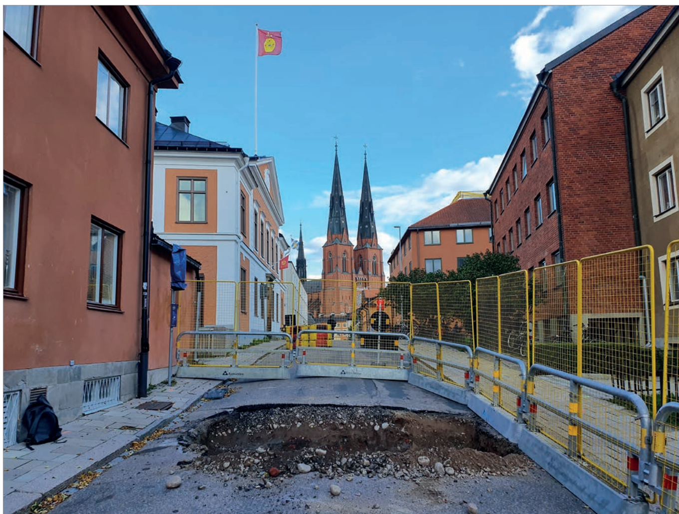
Figur 12. Schaktet 1 i S:t Larsgatan, med domkyrkan som fond. Till vänster i bild ses Upplands nation. Foto mot sydost, Adam Hultberg, Upplandsmuseet.
