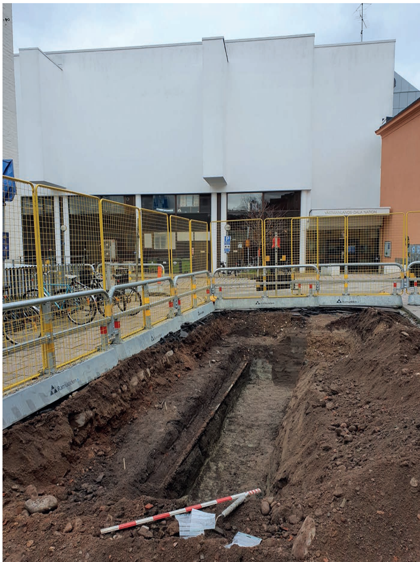
Figur 31. Nordöstra delen av Schakt 5 på Svartmangatan. Stora delar av eventuella äldre lämningar var sedan tidigare bortschaktade eller störda av rödragningar. Längs schaktets nordvästra kant, till vänster i bild fanns bevarade kulturlager innanför lednings-schaktet. Dessa med en bredd om 0,3–0,5 m. Dessa har tolkats som möjliga spår efter äldre odling. Foto mot NV, Joakim Kjellberg, Upplandsmuseet.
