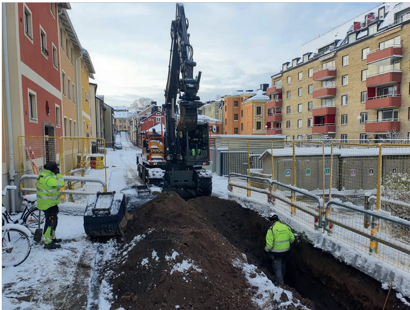
Figur 30. Schaktning pågår i schakt 5. Foto mot sydväst, Adam Hultberg, Upplandsmuseet.
