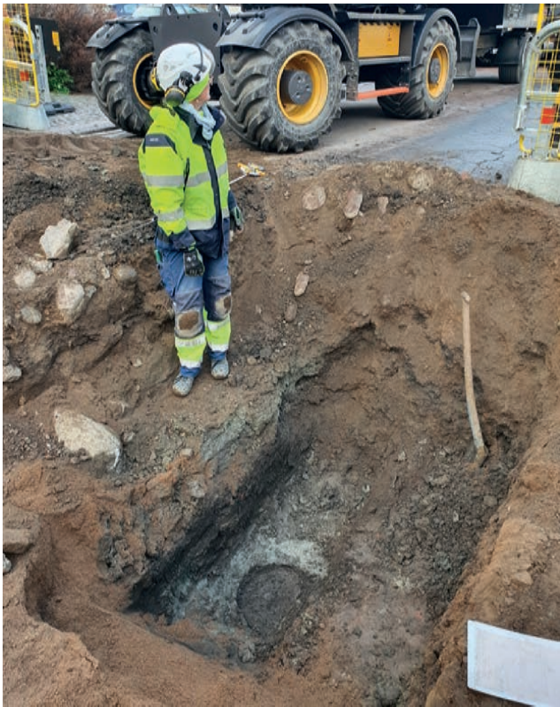
Figur 27. I nordvästra delen av schakt 4 påträffades en nedgrävd tunna K39, K40, som troligen fungerat som en brunn vilken hade ett djup av minst 2,9 m under dagens markyta. Foto Adam Hultberg, Upplandsmuseet.
