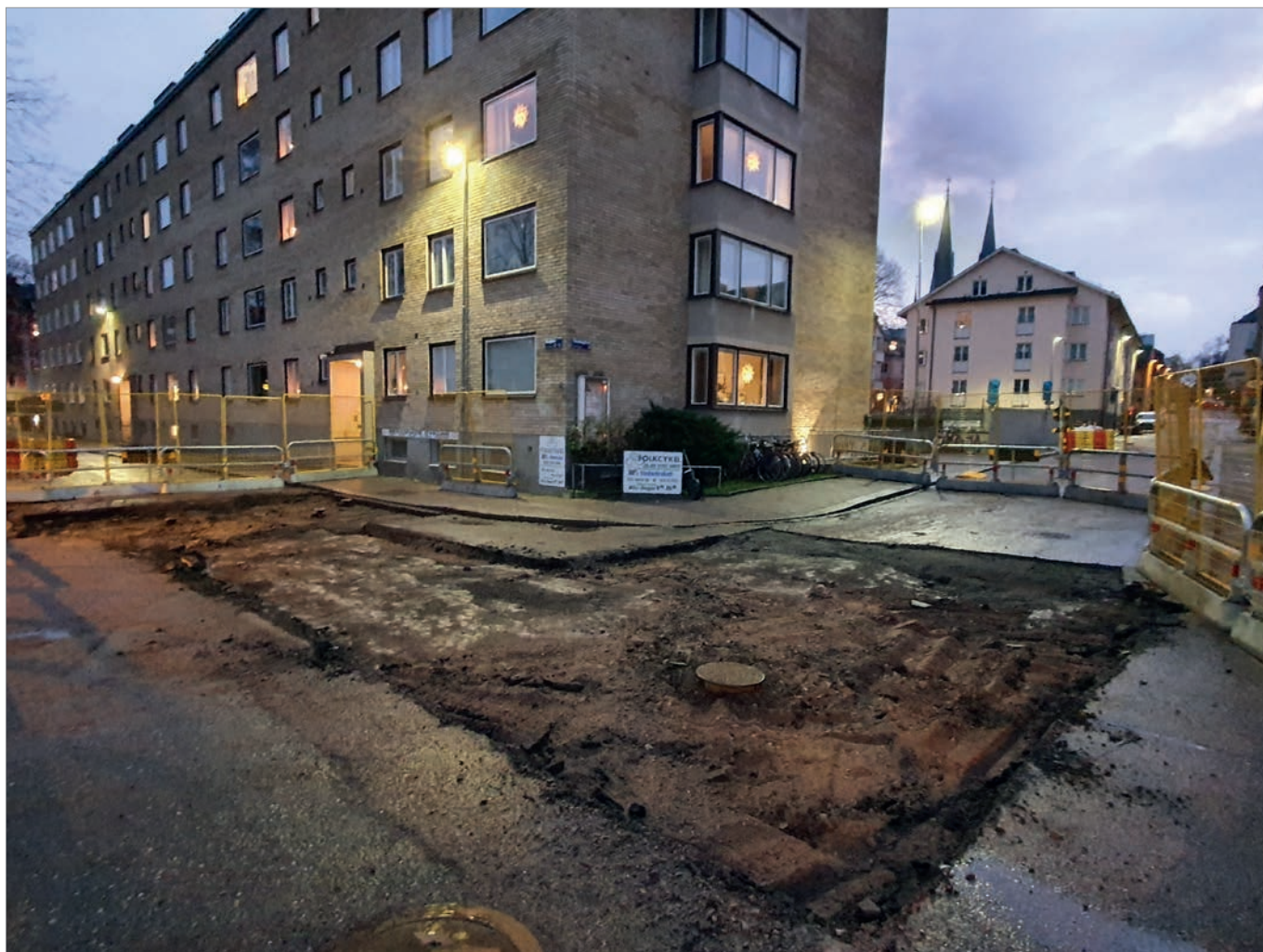
Figur 32. Schakt 6 grävdes i korsningen Skolgatan och Rundelsgränd. Foto i slutet av november 2022, mot öster, Adam Hultberg, Upplandsmuseet.
