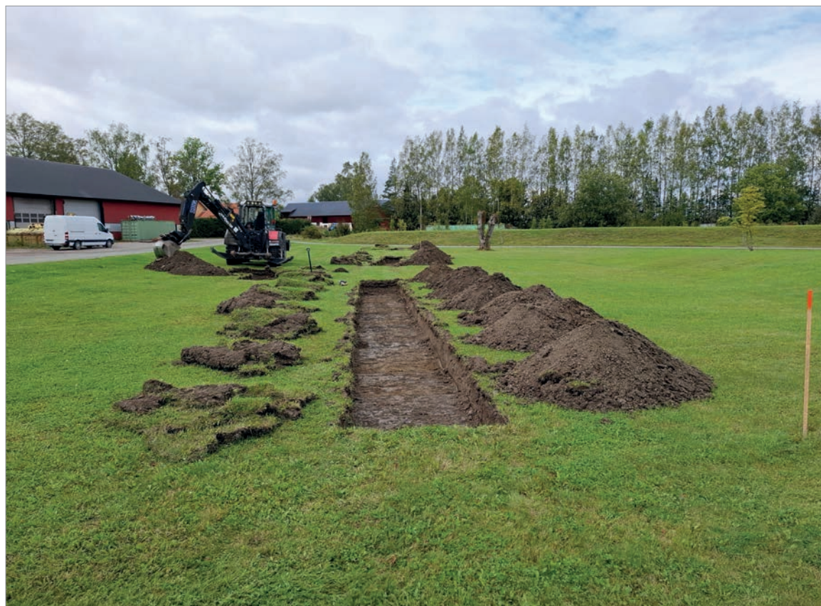
Figur 4. Schakten grävdes i en flack gräsbevuxt yta invid den nuvarande Nyvlavägen. Foto mot nordväst, Hans Göthberg, Stiftelsen Upplandsmuseet.
