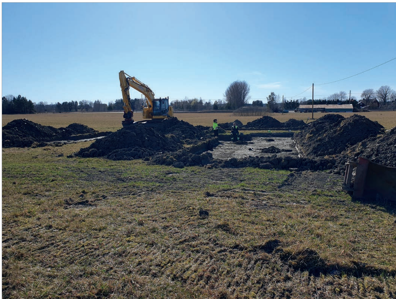
Figur 4. Schakten grävdes med dubbel skopbredd. Skyddsavstånd hölls till den befintliga luftledningen. Foto Andreas Henniuss, Stiftelsen Upplandsmuseet.
