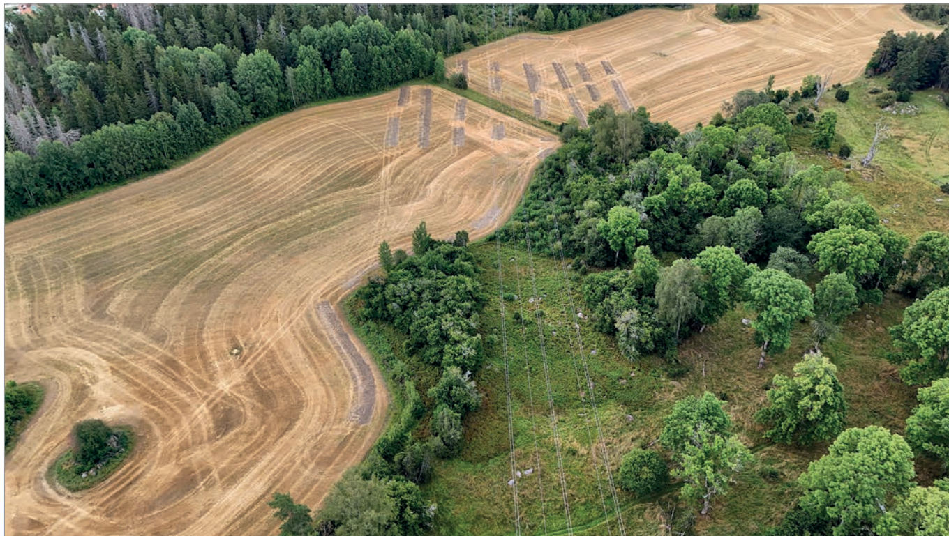
Figur 21. Arbetsyta 49, byggväg 49 och rivningsstolpe 231. I kanten mellan åker och hagmark syns i förgrunden schakt tillhörande byggväg 49. Schakten inom arbetsyta 49 är belägna i gärdet under ledningen och på ömse sidor om en mindre brukningsväg. I bakgrunden anas delar av rivningsstolpe 231. Foto från nordöst: Andreas Hennius, Stiftelsen Upplandsmuseet.
