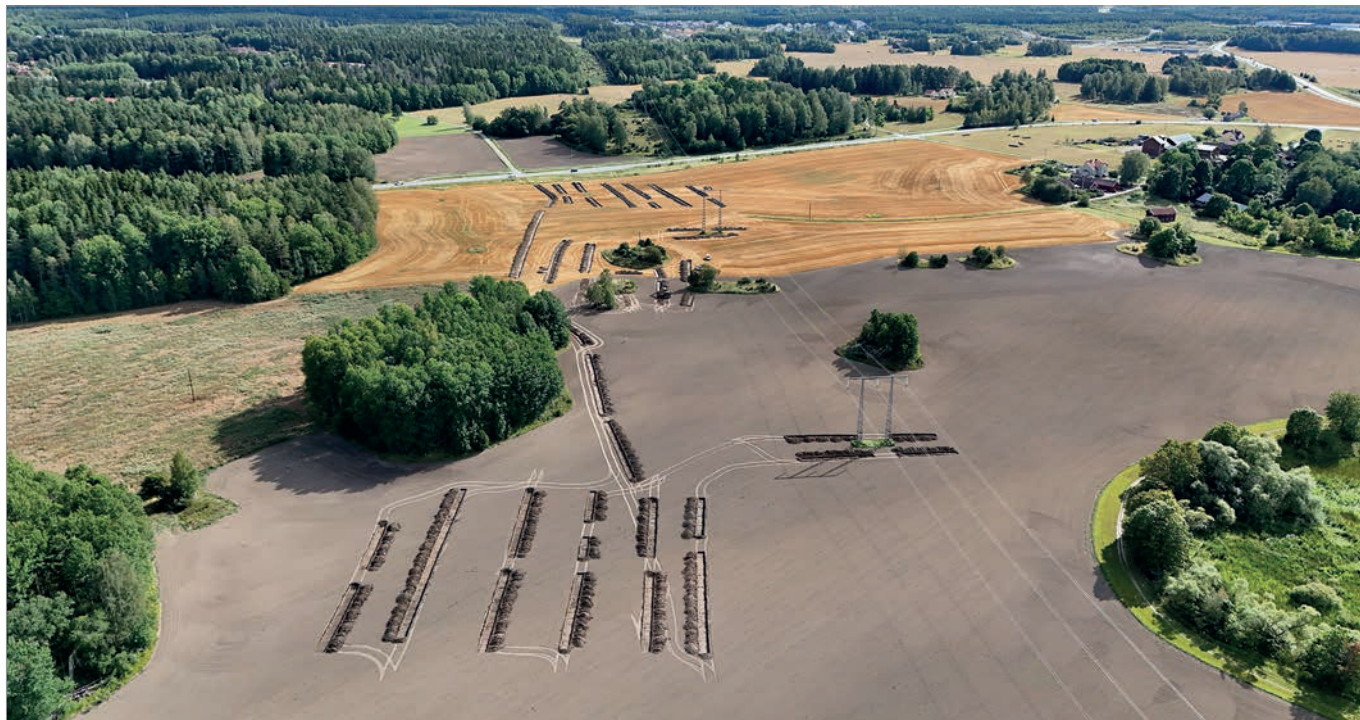
Figur 15. Schakt inom arbetsyta 45 och byggväg 45, arbetsyta 47 och 36 samt rivningsstolparna 228-229. Arbetsyta 45 är i förgrunden, arbetsyta 47 mellan de mindre åkerholmarna i bildens och arbetsyta 46 i bakgrunden närmast väg 696. Foto från norr: Andreas Hennius, Stiftelsen Upplandsmuseet.
