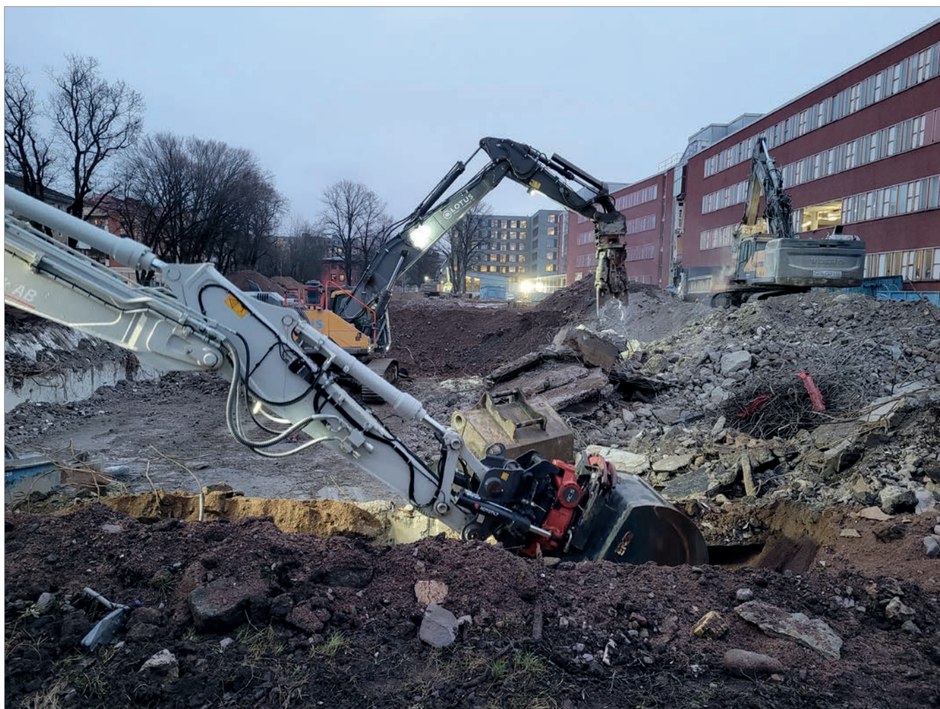
Figur 5. Arbetsmiljön inom kvarteret Hugin med flera större maskiner i rivningsarbete. Foto av Malin Lucas, Stiftelsen Upplandsmuseet.
