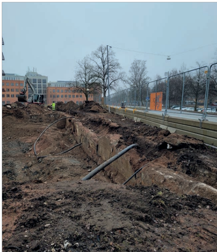
Figur 13. Schakt 8 med betongmuren K3. Foto mot sydost, Malin Lucas, Stiftelsen Upplandsmuseet.
