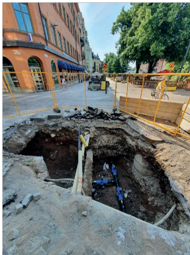
Figur 23. Schaktningsövervakning i korsningen Drottninggatan-Östra Ågatan 2022. Med inkopplingspunkten för VA ledningen som anslöt mot Stora torget och Sträcka 2C. Foto mot norr, Joakim Kjellberg, Upplandsmuseet.
