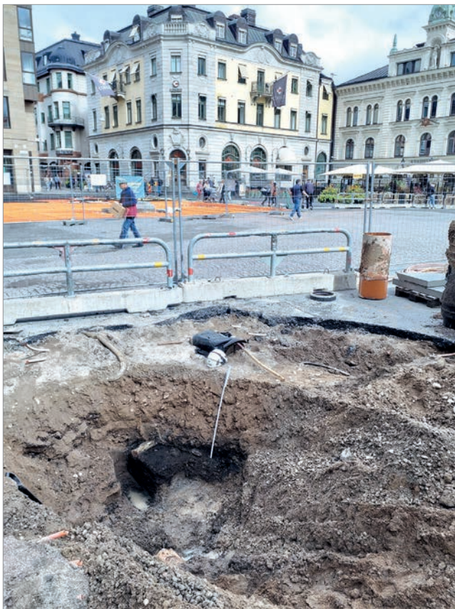
Figur 196. Kontextgrupp 226 utgjordes av en isolerad kulturlagerklack i den västra schaktväggen och låg mellan två sentida rörschakt. Lämningarna saknar stratigrafisk koppling men nivåmässigt motsvarar de troligast lager K714 i sektion 32. Foto: Adam Hultberg, Upplandsmuseet.
