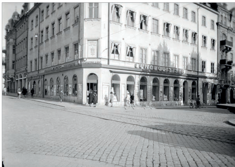
Figur 32. Läget för de äldre fynden och ett skepp djupt ned i leran vid Lundequistska bokhandeln i Uppsala. Bokhandeln låg då vid hörnet av Drottninggatan och Östra Ågatan. Foto från 1942 av Gunnar Sundgren i Upplandsmuseets bildsamling.
