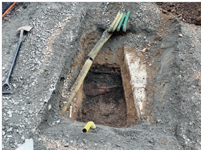
Figur 125. Schakt 6 med bevarade kulturlager invid en betongkulvert. Foto mot nordöst, Adam Hultberg, Upplandsmuseet.
