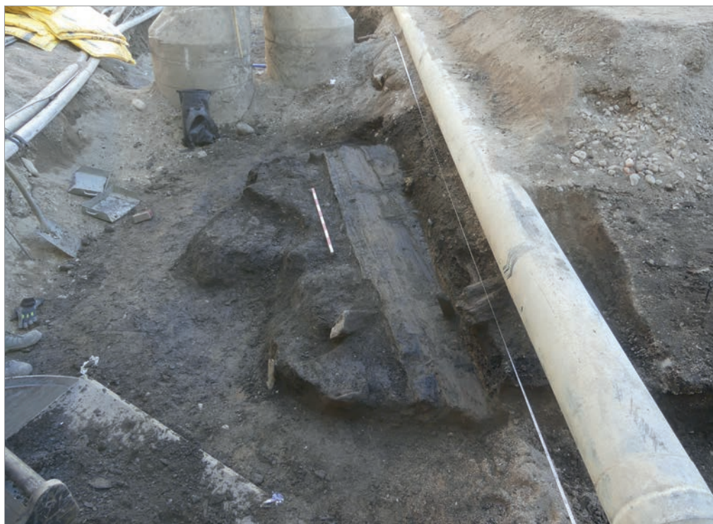
Figur 94. Den mycket kraftiga träkonstruktionen i kontextgrupp 59, av två parallella och längs schaktet löpande grova plankor K128 och underliggande bärkonstruktioner K136 och K144. Lämningarna har tolkats som ett golv i en byggnad eller möjligen som fundament med oklar funktion på grund av sitt kraftiga utförande. Foto mot nordöst: Joakim Kjellberg, Upplandsmuseet.
