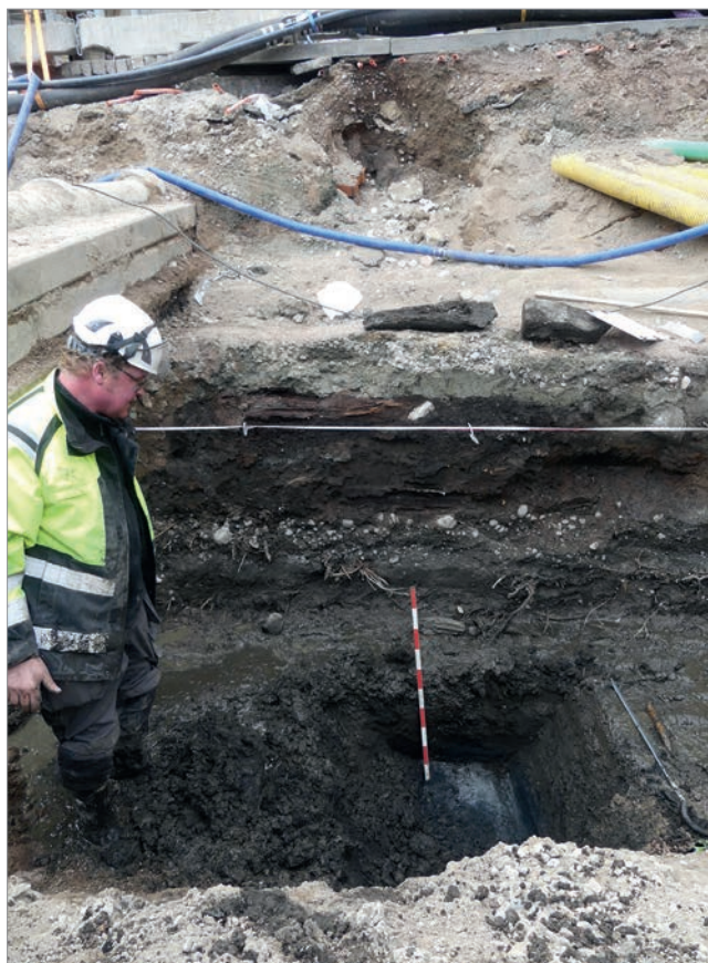
Figur 256. Pågående arbete och dokumentation vid en av de djupgrävda groparna för avledning av vatten från den omgivande ytan. Behovet av vattenavledning gav möjlighet till kontroll av de kulturlagertjocklek, de nedersta utfyllnadslagrens och markytans innehåll samt nivån för den ursprungliga topografin. Notera även risbädden för den äldsta strandgatan som diskuteras under Skede II. Foto: Adam Hultberg, Upplandsmuseet.
