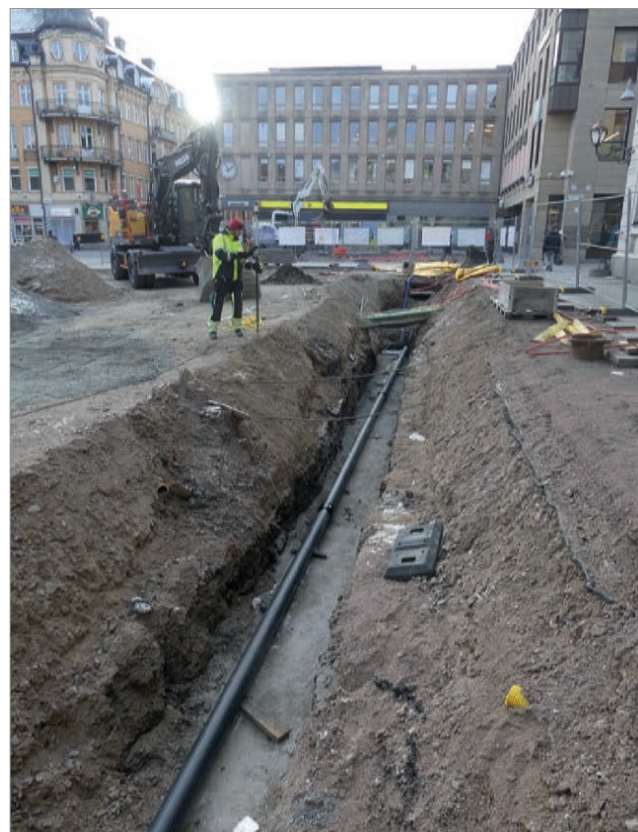
Figur 37. Inmätning av schakt, sektioner och höjder gjordes regelbundet i samarbete med Uppsala kommuns mättekniker. Här dokumenteras dagens öppning av Sträcka 2 med de sentida utfyllnadsmassorna släntade och sektionerna mot schaktbotten rensade. De nya rören lades på samma djup som de tidigare befintliga. Ställvis kunde schaktbotten rensas och dokumenteras innan de återfylldes med modernt grusmaterial. Foto: Joakim Kjellberg, Upplandsmuseet.
