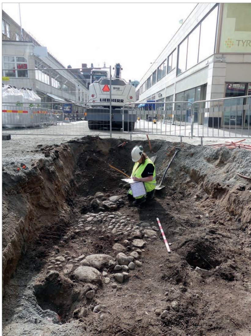
Figur 21. Ett av schakten på Kungsängsgatan, i korsningen mot Smedsgränd, med kullerstensläggning. Foto mot söder, Robin Lucas, Upplandsmuseet.
