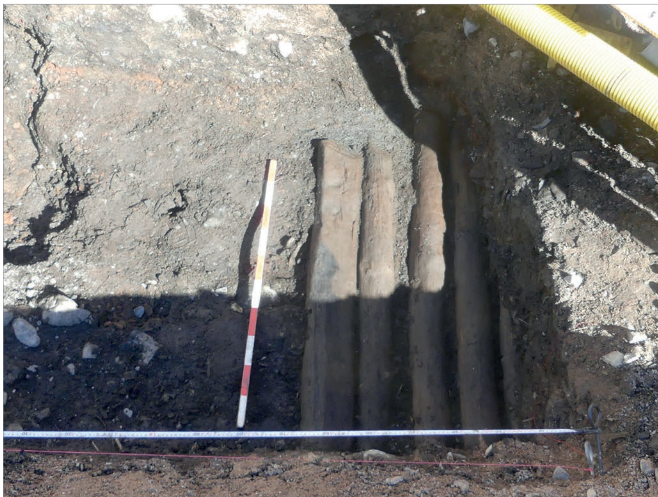
Figur 151. Kavelbron K397 i kontextgrupp 177. Observera att den fortsätter något in under de gula plaströren. Foto mot nordväst, Malin Lucas, Upplandsmuseet.
