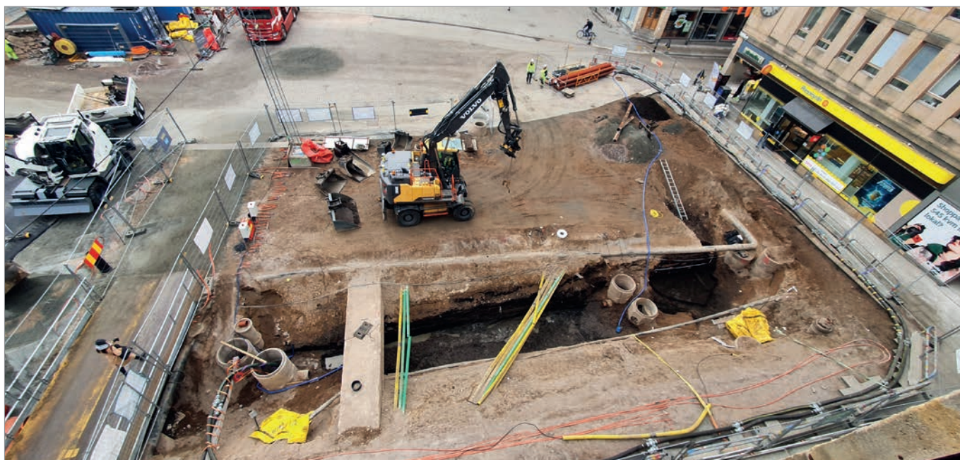
Figur 81. Översiktsbild visande stora delar av Sträcka 2A med Yta 1 och övergången mot Sträcka 2B längst till höger. Foto mot söder, Adam Hultberg, Upplandsmuseet.
