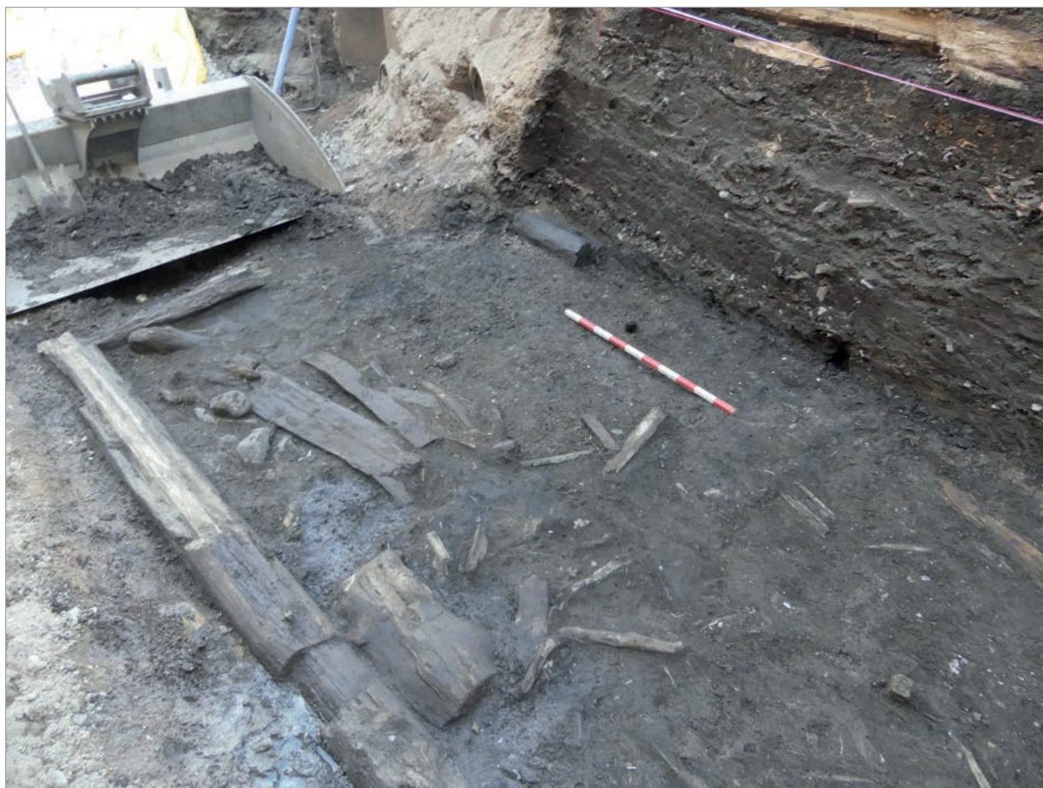
Figur 259. Den äldsta byggnad som kunde dokumenteras inom undersökningsytan var också en av de mest kompletta. Den bäst bevarade syllstocken var mångkantig och hade bilats med två urtag för anslutande timmer. Möjligen har den timrade konstruktionen utgjort bottenramen till en stolpbod med upphöjt golv och använts som förrådsbod på en av de äldsta stadsgårdarna i området. Foto Adam Hultberg, Upplandsmuseet.
