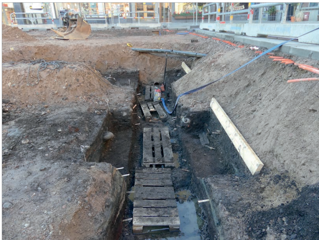
Figur 188. Dagvattenschaktet Sträcka 4 utvidgades med två fördjupningar för nya dagvattenbrunnar med sandfilter, kallade Yta 5 och Yta 6. På grund av den rikliga nederbörden och uppträngande vatten skapades även av nödvändighet en pumpgrop och stabila underlag för arbetet. Översiktsfoto under pågående utgrävning mot sydväst: Joakim Kjellberg, Upplandsmuseet
