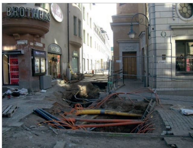
Figur 22. Schakt i korsningen Svarbäcksgatan-Påvel Snickares gränd som övervakades 2010. Foto mot öster, Joakim Kjellberg, Upplandsmuseet.
