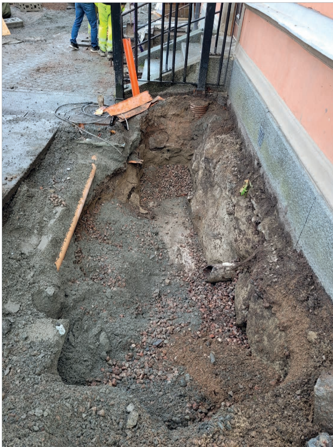
Figur 8. Schakt 6 med dagvattenledning till vänster och i övrigt singel och betong. Foto mot nordost, Malin Lucas, Stiftelsen Upplandsmuseet.
