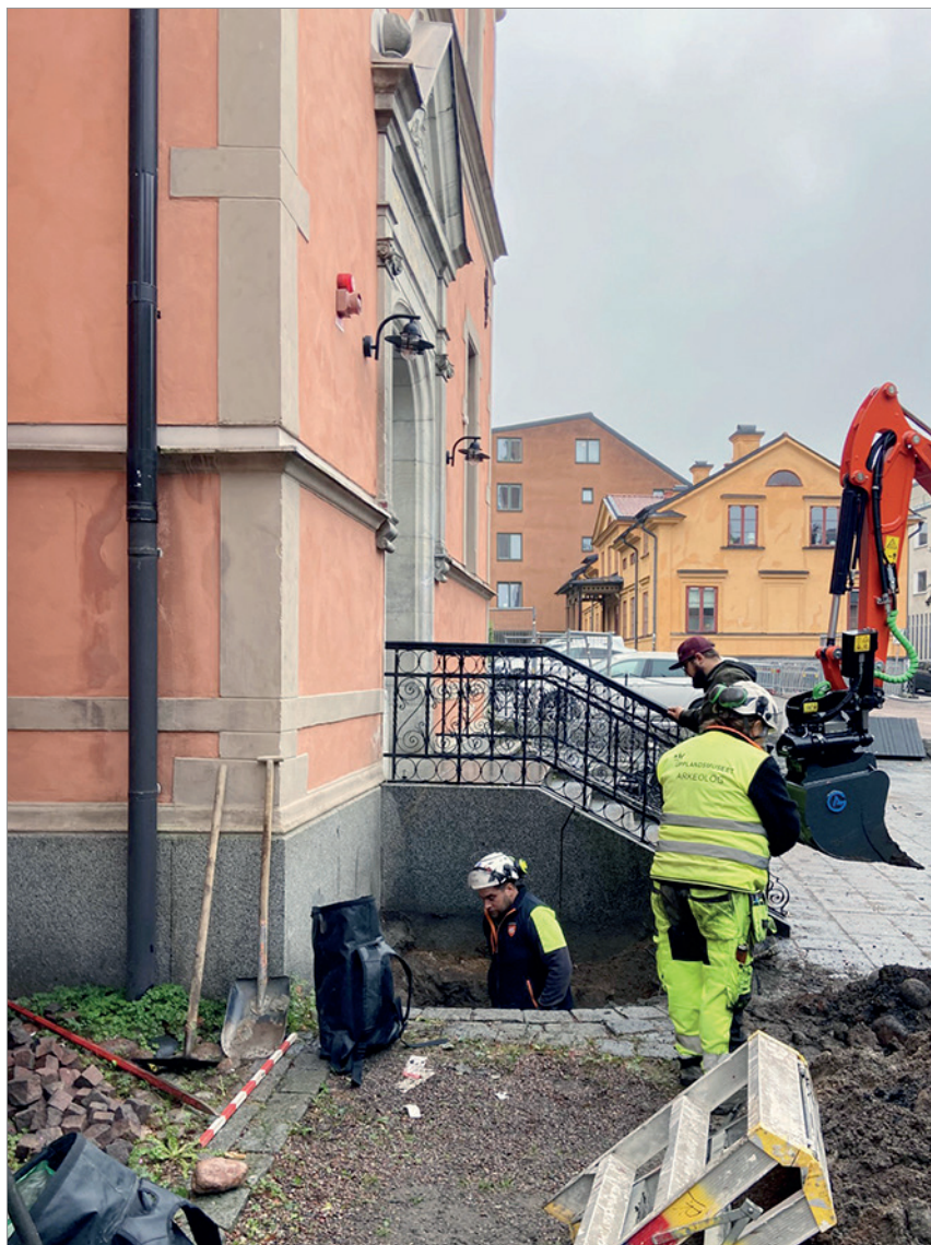
Figur 4. Övervakning pågår av schakt 1. Foto mot norr av Anna Ölund, Stiftelsen Upplandsmuseet.
