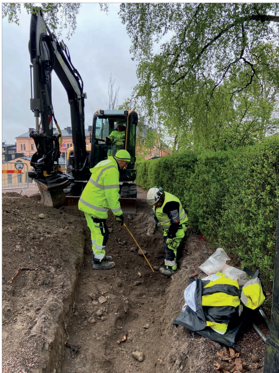
Figur 4. Pågående schaktning vid Helga Trefaldighet. Foto av Anna Ölund, Stiftelsen Upplandsmuseet.
