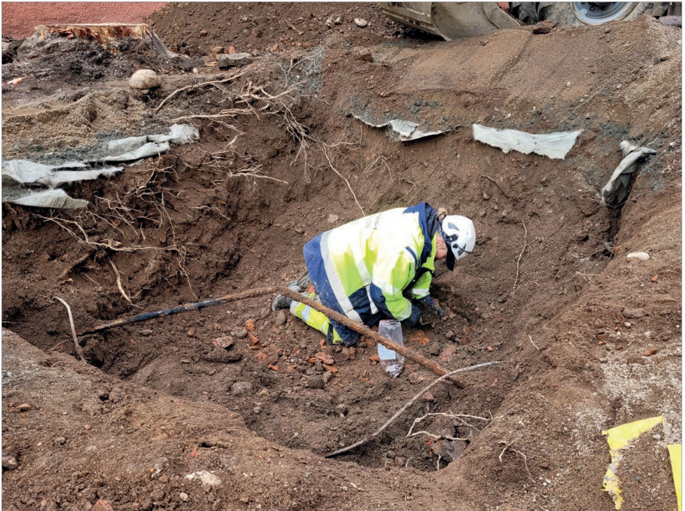
Figur 11. Raseringslager av krossat tegel blandat med sand och grus som låg mellan 0,8 och 1,3 meter under markytan undersöks. På bilden ses även en äldre gasledning. Foto mot norr, Malin Lucas, Stiftelsen Upplandsmuseet.
