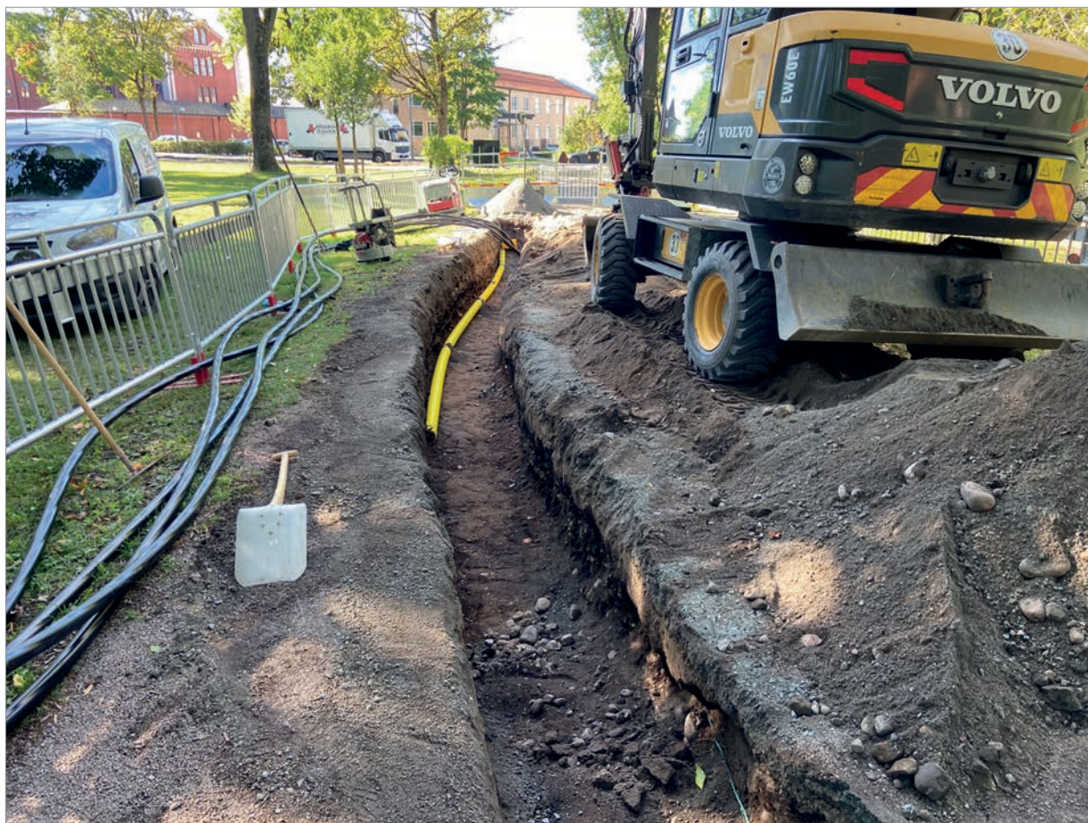
Figur 13. Översikt av schaktsträcka 4 i Tornerparken, Foto mot sydväst, Anna Ölund, Stiftelsen Upplandsmuseet.
