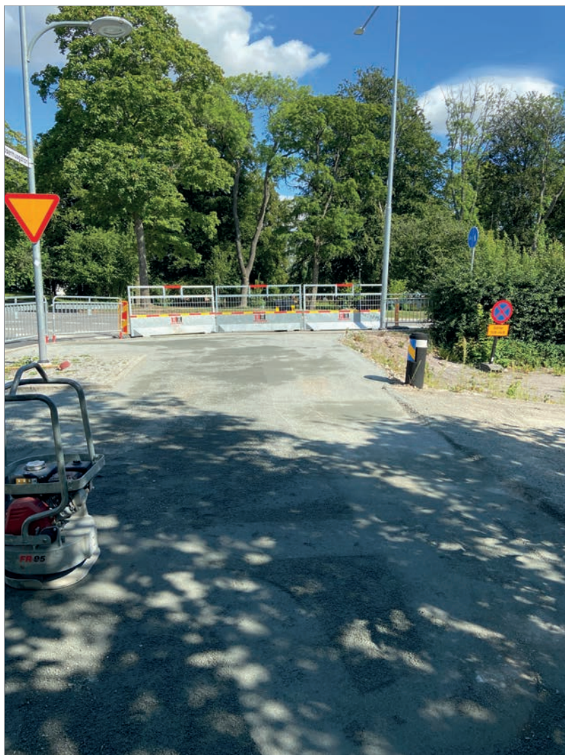
Figur 6. Schaktsträcka 1 med igenlagt schakt på Blåsenhusgatans östra del mot korsningen av Dag Hammarskjölds väg. Foto mot öster, Anna Ölund, Stiftelsen Upplandsmuseet.
