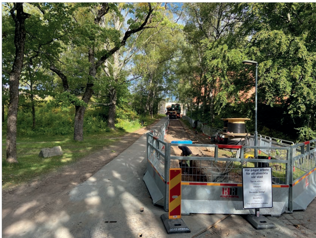
Figur 25. Översikt över schaktsträcka 5 som löpte i den östra sidan av Kung Jans väg upp mot Uppsala slott. Foto mot norr, Anna Ölund, Stiftelsen Upplandsmuseet.
