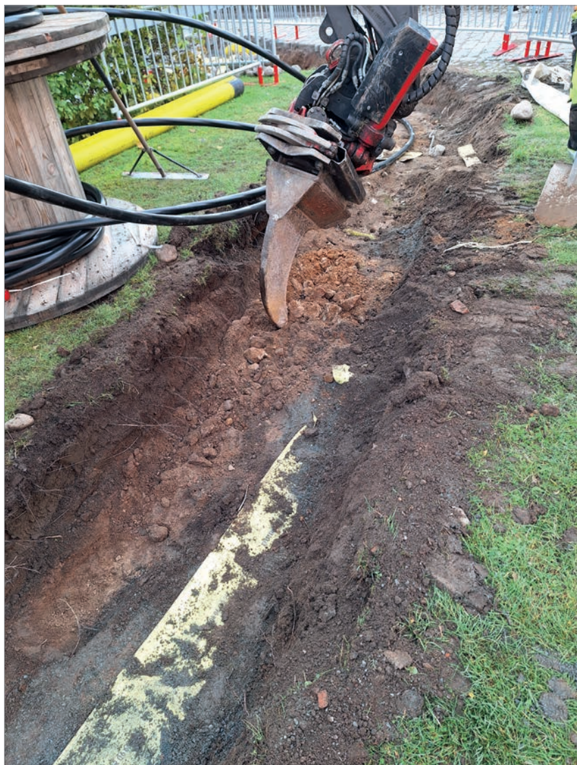
Figur 33. K14 som utgör en nedgrävning för kalkrörning. Fyllningen i nedgrävningen var mycket hård och fick hackas loss med tjälkrok. Foto mot väster, Amanda Jönsson, Stiftelsen Upplandsmuseet.
