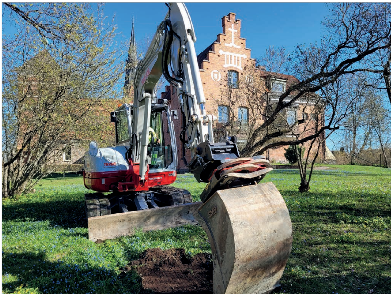
Figur 6. Pågående schaktning i prästgårdens trädgård. Foto mot norr, Malin Lucas, Stiftelsen Upplandsmuseet.
