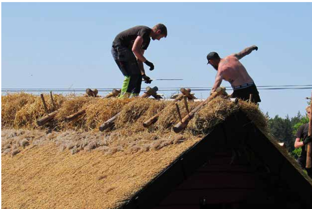
Stiftelsen Upplandsmuseets byggnadsantikvarier övervakar åtgärder i bebyggelsen i länet. Vasstakläggning på en källarbyggnad i Nolsterby, Östhammars kommun. Foto: Göran Olsson.
